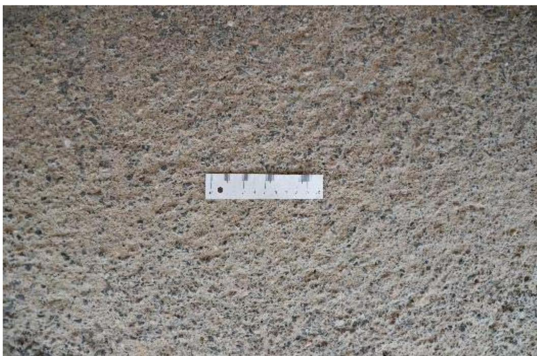
Abb. 138: Oberfläche nach dem Sandstrahlen
