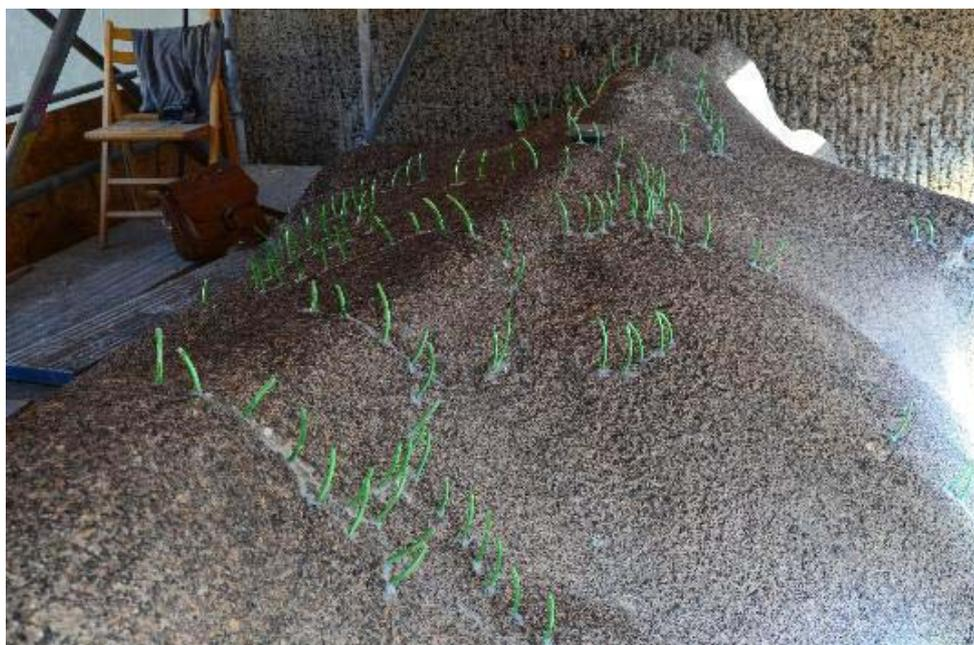
Abb. 124: Der Rücken der Kuh während der Verfüllung, hier wurde noch zusätzlich zu Zentrifix noch ein Silikonkautschuk als Verdämmung aufgebracht, was außer einem Mehraufwand keine verbesserte Abdichtung ergab
