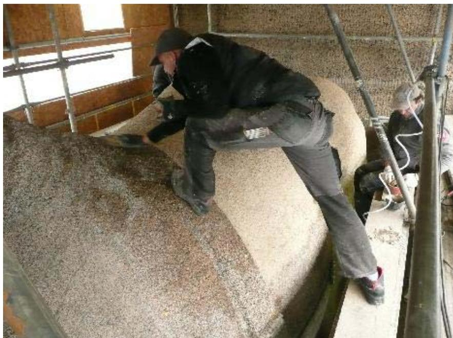
Abb. 134: Aufbringen des Mörtels 101 mit der Wurzelbürste
