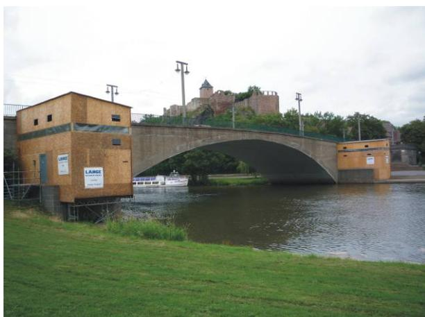
Abb. 42: Einhausung für die Trocknung der geschädigten Skulpturen
