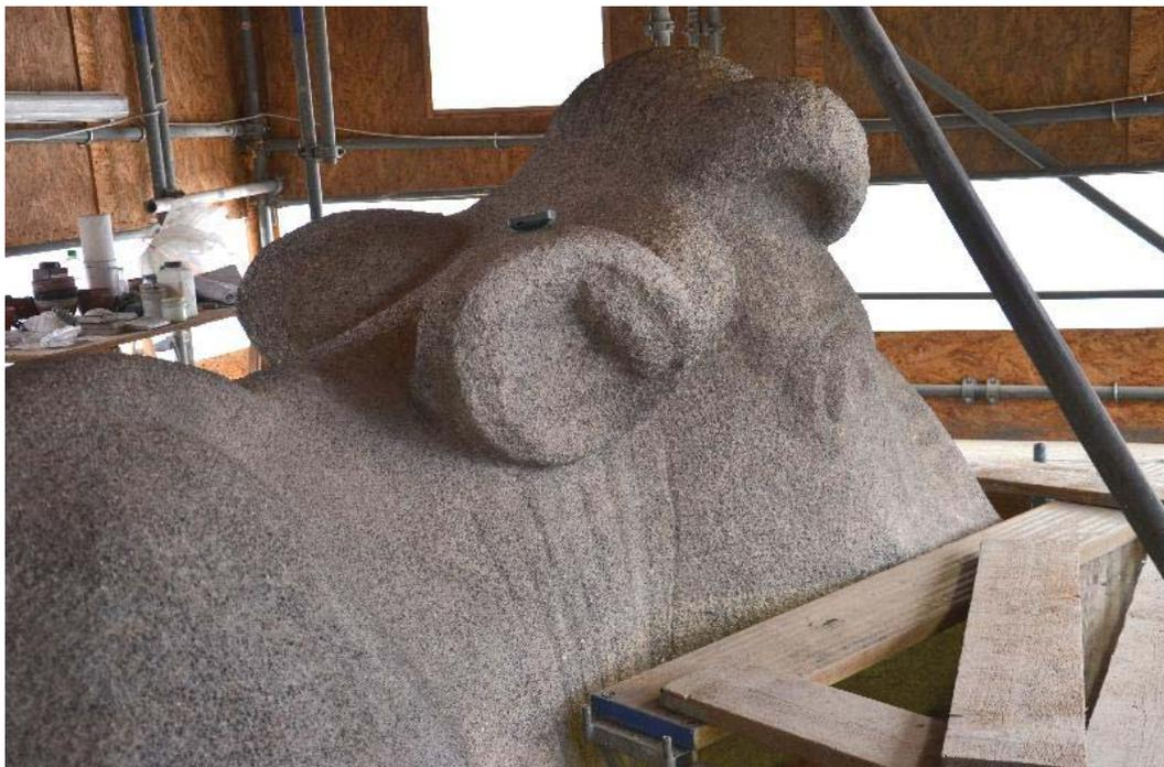
Abb. 145: Detail der fertig gestellten Skulptur der Kuh mit gefüllten Rissen, mit dem Fehlstellen ausfüllenden und die gesamte Oberfläche überdeckenden Mörtel sowie der abschließenden Schlämmlassur
