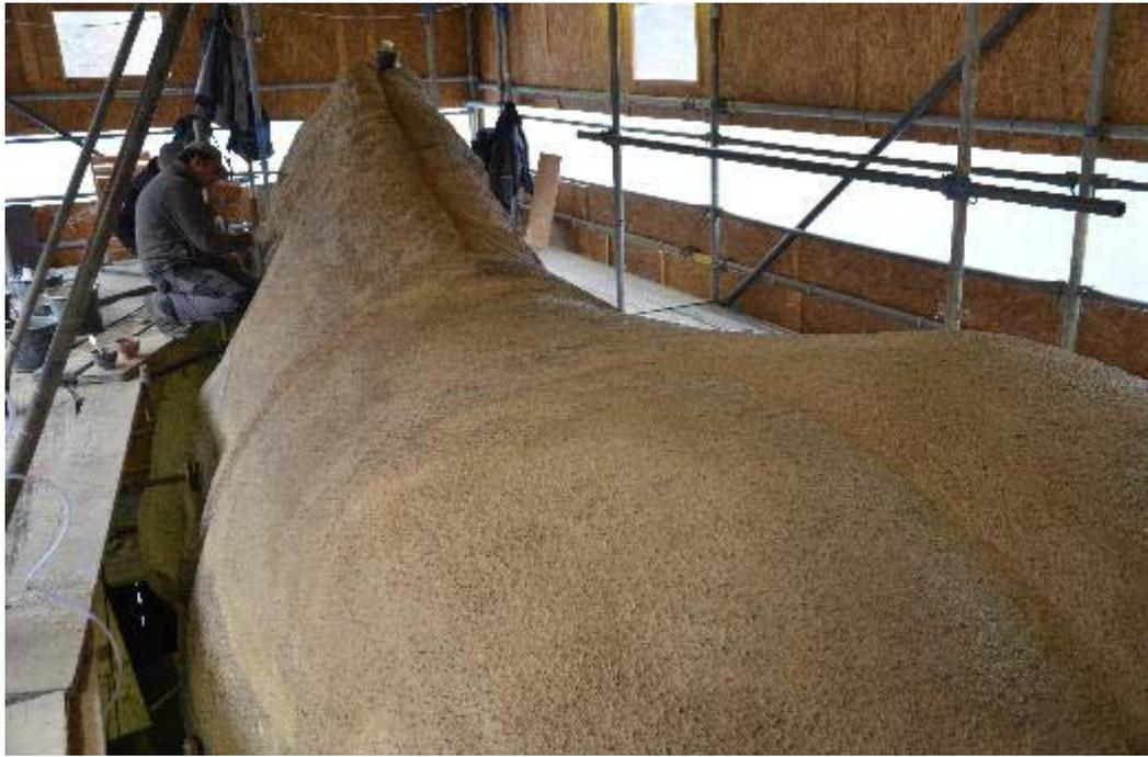
Abb. 135: Aufbringen des Mörtels 101 mit der Wurzelbürste
