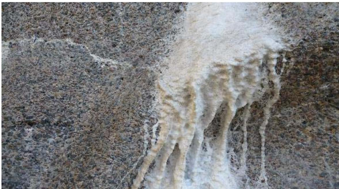
Abb. 113: Massive Sinterschicht
