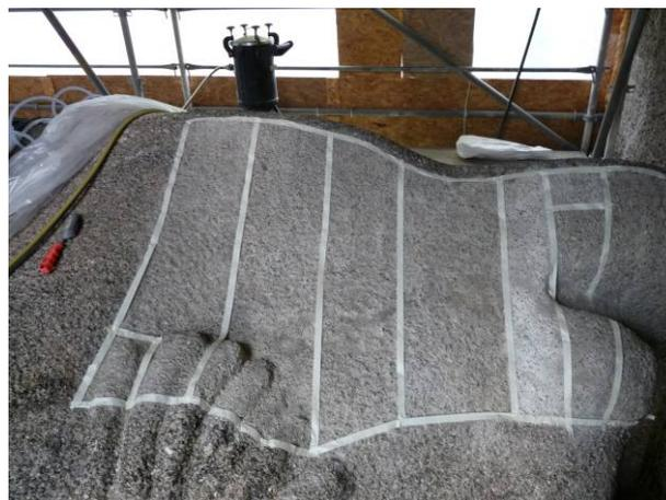
Abb. 98: Anlage von Musterflächen mit unterschiedlich pigmentierten Silikonharzschlämmen
