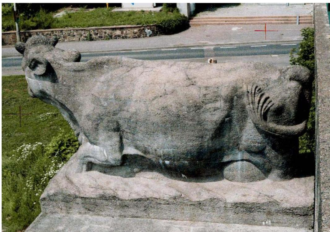
Abb. 32: Zustand 2010; Das Rissnetz auf dem Rücken ist seit 1995 deutlich dichter geworden (Reichenbach)
