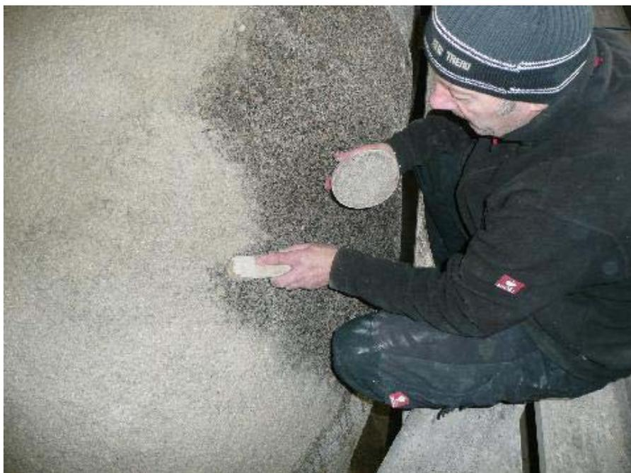
Abb. 133: Aufbringen des Mörtels 101 mit der Wurzelbürste (Detail)
