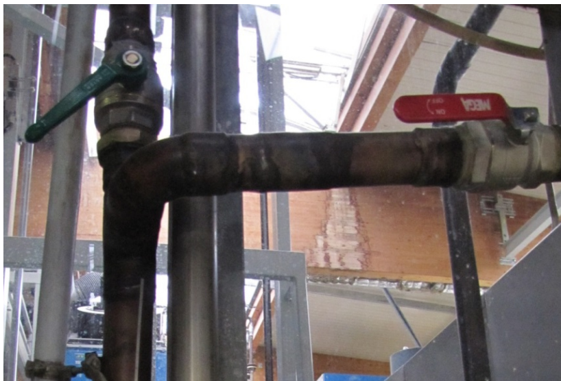
Abbildung 43: Teilgeöffneter Kugelhahn WSR 1, Wäscherei für Berufsbekleidung
