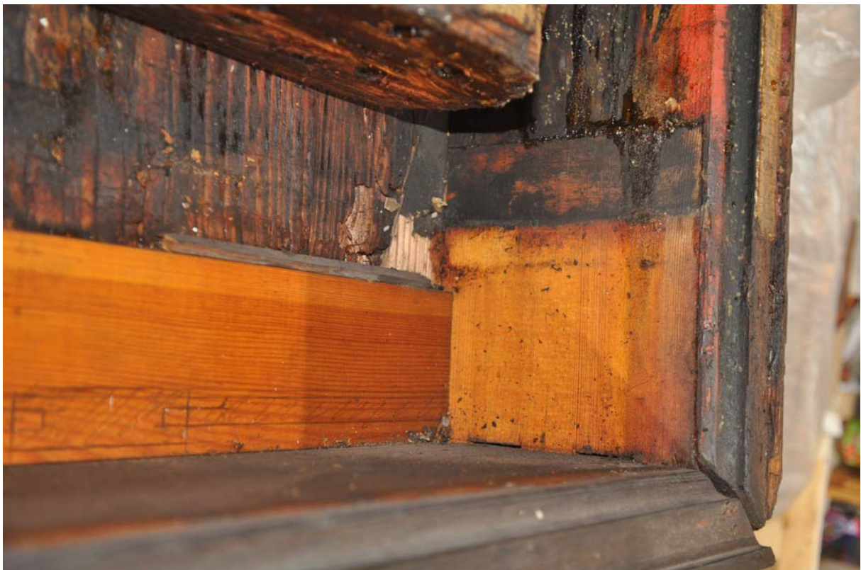
Die tischlerischen Erneuerungen im unteren Bereich des Altars wurden vor der Öltränkung ausgeführt, da die Neuholzteile ebenfalls genau so stark verölt sind,
