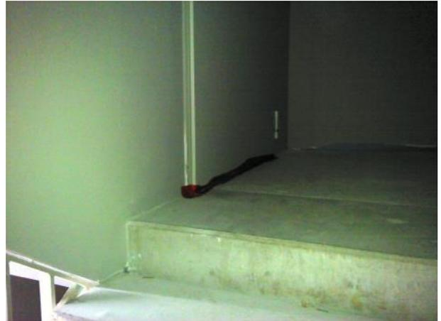
**Bild 18:** Thermische Trennung zum Glockenturm TRH 1
