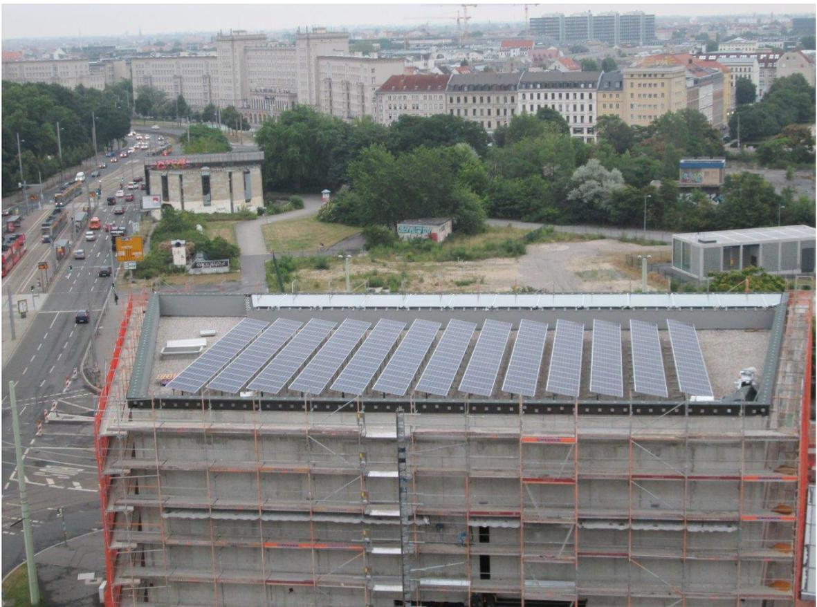
Abb. 28: Installierte Aufdachanlage am Projekt
