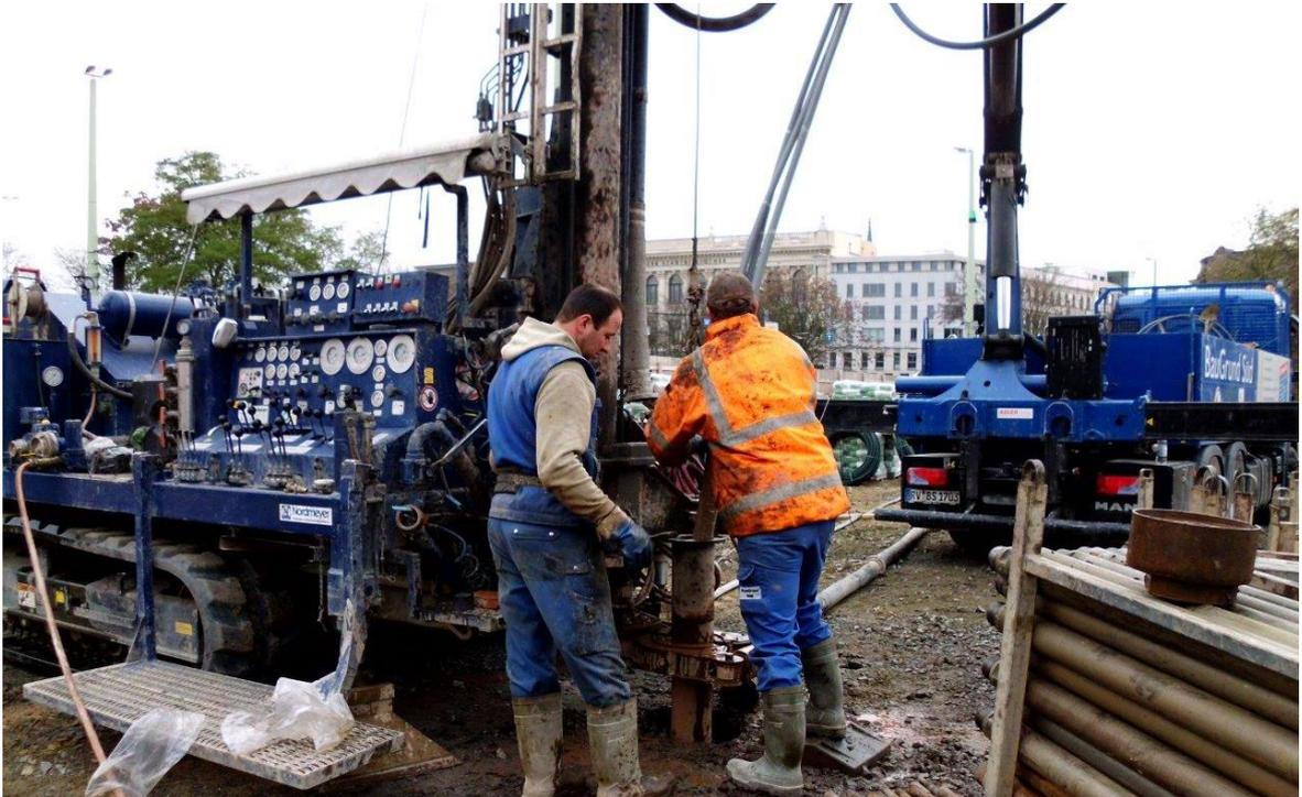
Abb. 26: Einführung der Erdsonden in den Bohrkopf
