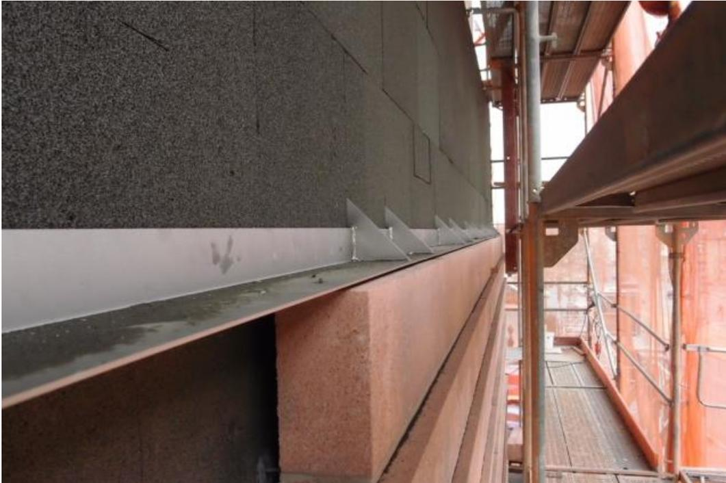
Abb. 25: Aufbringung der Fassadendämmung mit Lastabtragung der Natursteinfassade
