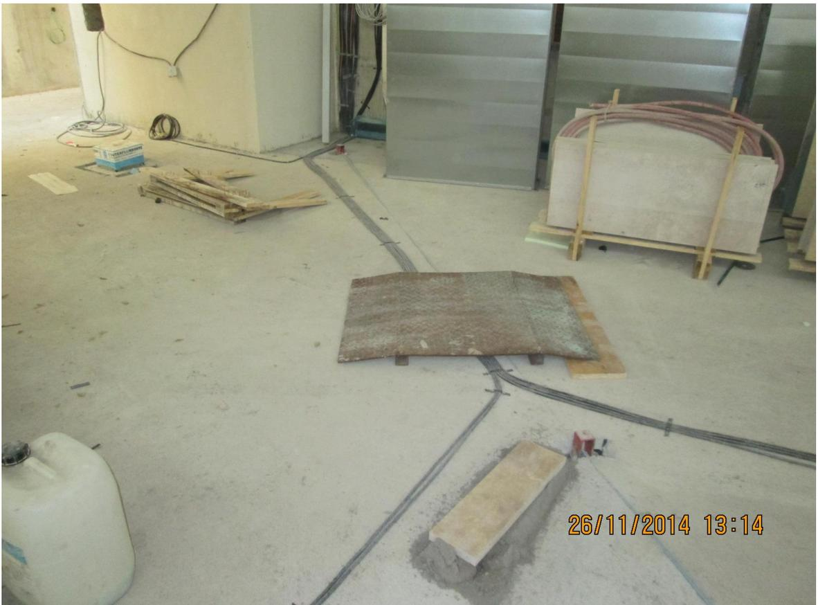
Abb. 30: Installation der Induktionsschlaufen für die akustische Unterstützung
