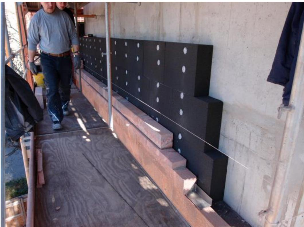
Abb. 24: Aufbringung der Fassadendämmung
