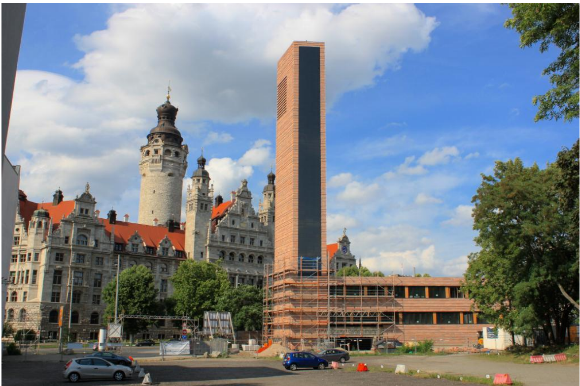
Abb. 18: Südansicht der Propsteikirche mit Lage der PV- Anlage am Turm Quelle: http://www.deutsches-architektur-forum.de Nutzer: Cowboy
