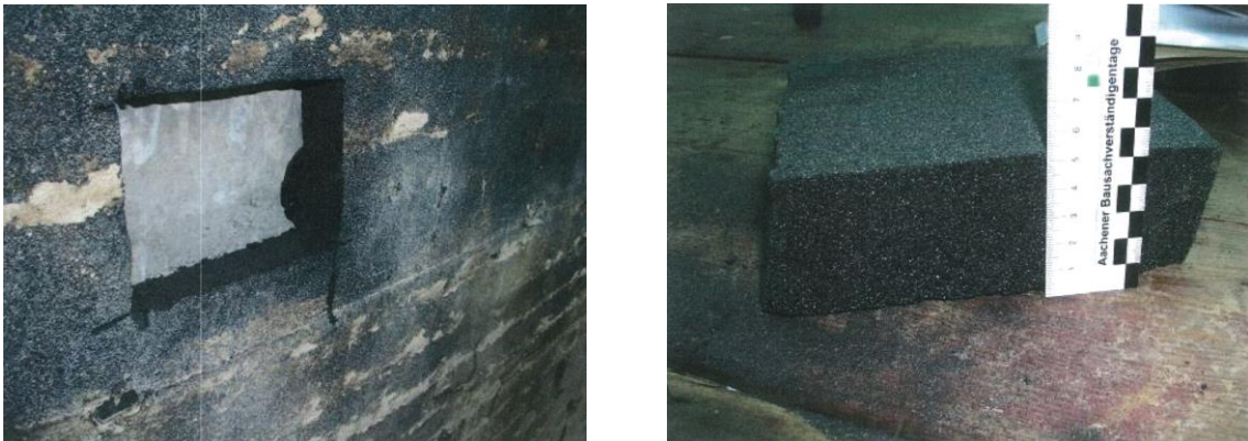
Abb. 24: Probeentnahme am Städtischen Hallenbad Kassel Quelle: Sachverständigenbüro Becker, Gutachten Städtisches Hallenbad Kassel, 2006
