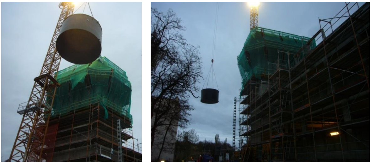
Abb. 69: Baustellendokumentation: Krantransport der Turmzisterne Quelle: Schulz & Schulz Architekten
