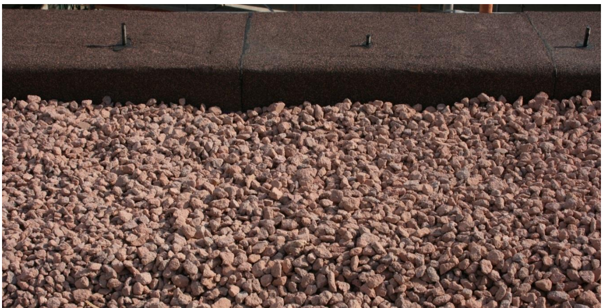
Abb. 30: Baustellendokumentation: Nahaufnahme Dachschtüttung Porphyrbruch Quelle: Schulz & Schulz Architekten
