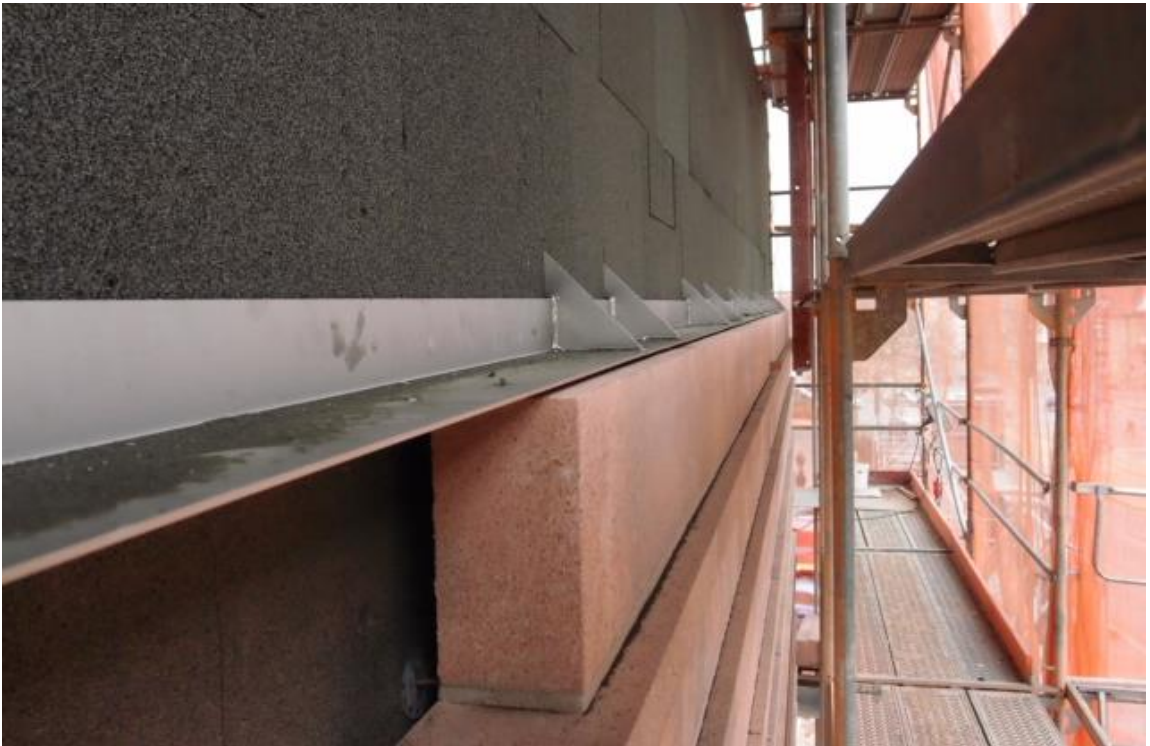
Abb. 28: Baustellendokumentation: Nahaufnahme der Steinfassade und Dämmschicht Quelle: Schulz & Schulz Architekten
