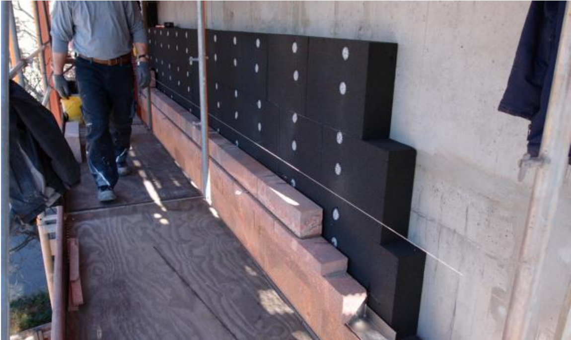
Abb. 27: Baustellendokumentation: Aufbauarbeiten der Steinfassade und Dämmschicht Quelle: Schulz & Schulz Architekten
