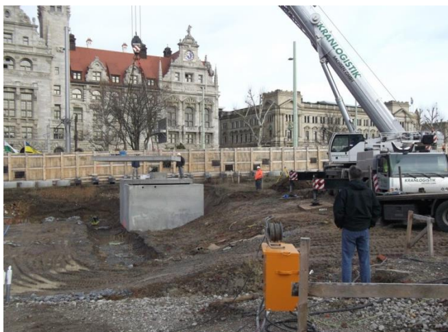
Abb. 71: Baustellendokumentation: Aufbau der Hofzisterne Quelle: Schulz & Schulz Architekten
