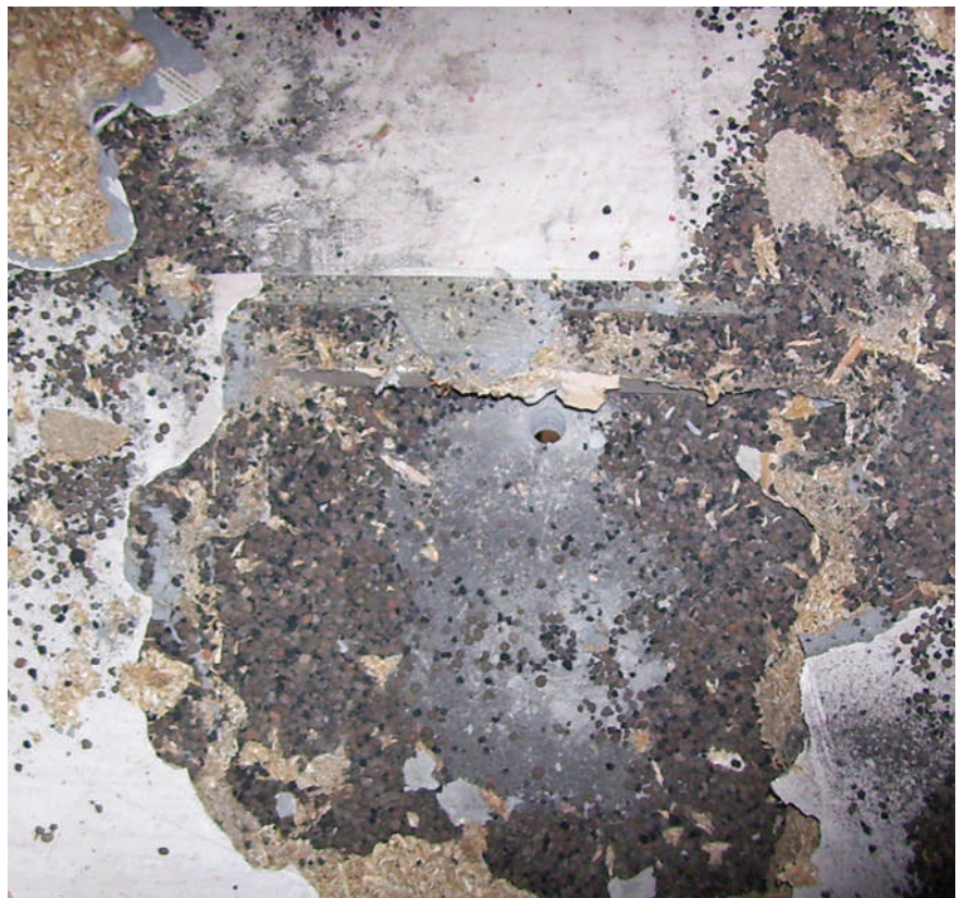
Abb. 42: Prüfbohrung Bestandsdecke
