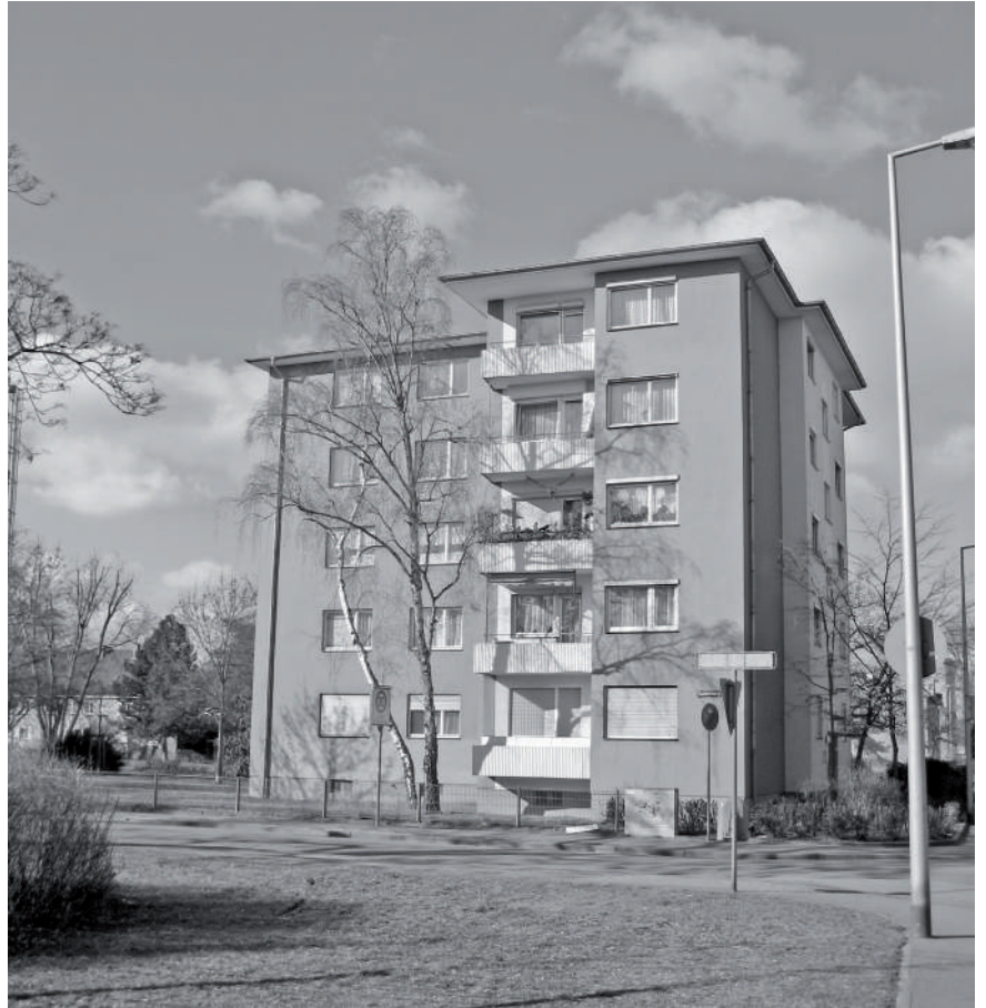
Abb. 5: Bestandsgebäude Ansicht Nordost
