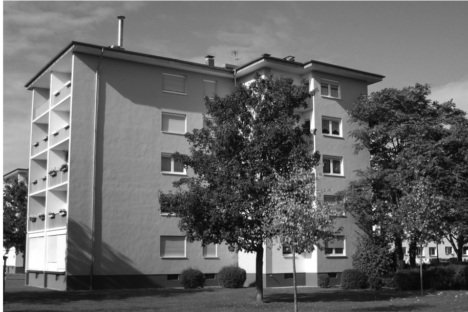
Abb. 1: Bestandsgebäude Ansicht Südwest
