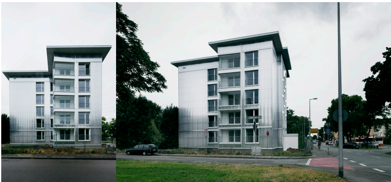
Abb. 2: Punkthaus nach der Sanierung
