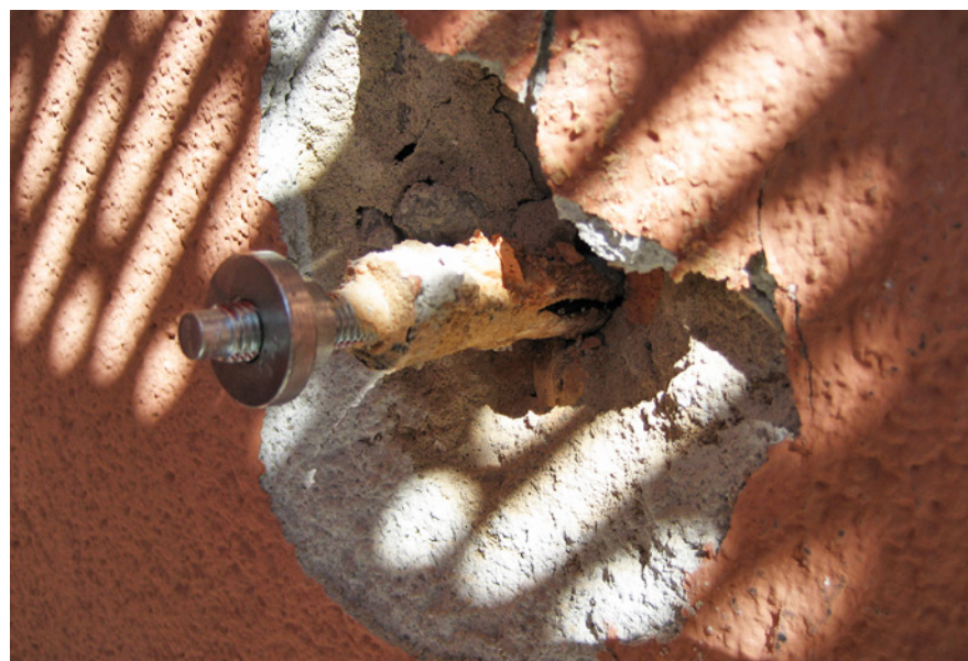
Abb. 41: Dübelauszugsversuche Aussenwand Bestand
