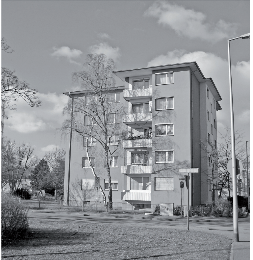
Abb. 5: Bestandsgebäude Ansicht Nordost
