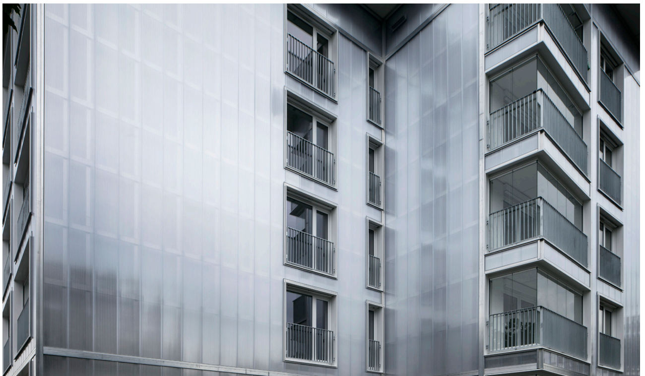
Abb. 45:Fassade des Punkthauses nach der Sanierung
