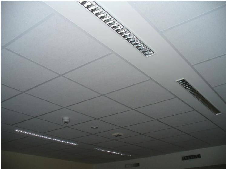
Abbildung 35 Tafelbeleuchtung: Leuchtstofflampe mit speziellem Reflektor
