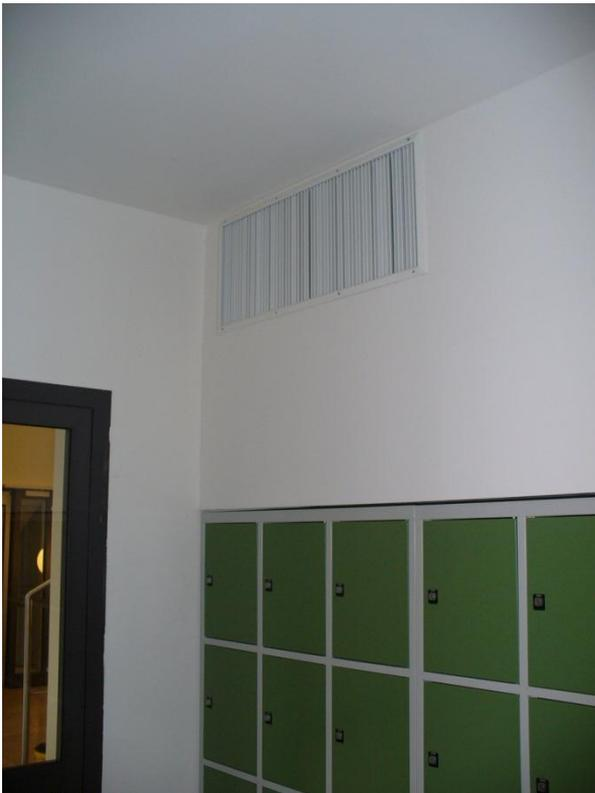
3. Sanitärräume: Diese erhielten aus hygienischen Gründen jeweils eine eigene Zu- und Abluftanlage. Diese ist jeweils mit einem Kreuzstromwärmetauscher ausgestattet.
