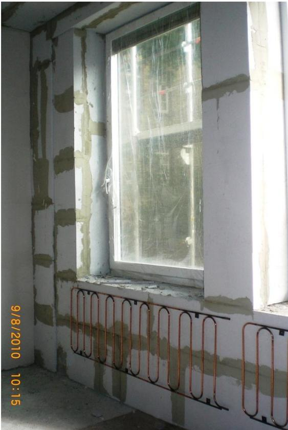
Die Wandheizung erhält die Wärme von der Wärmepumpe (bzw. im Bedarfsfall vom Nahwärmesystem).
