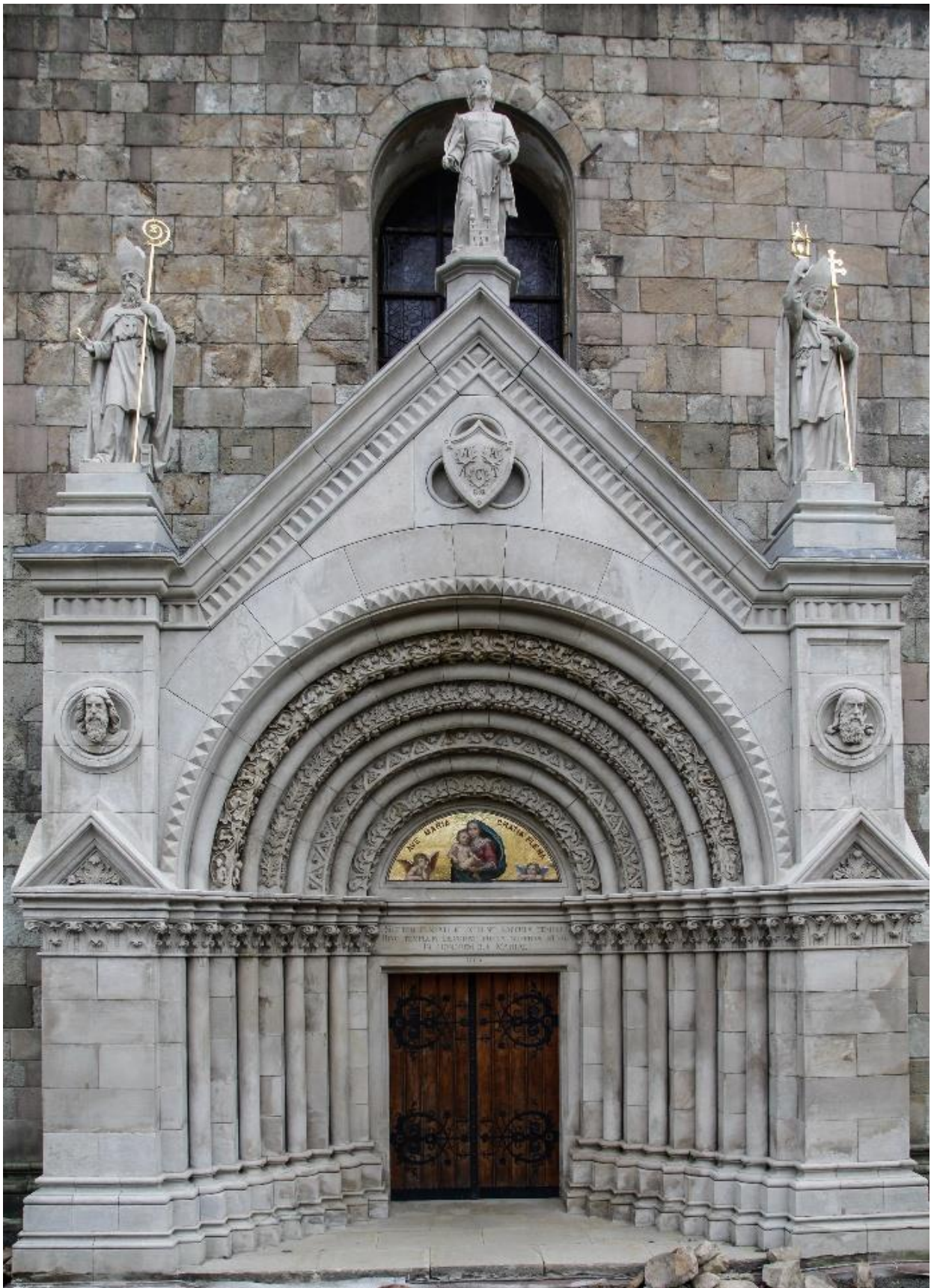
Abb. 33: Nach der vollständigen Konservierung kommen alle Gestaltungselemente des Portals der Stiftskirche von Teplá wieder voll zur Geltung. Foto: M. Novotná.
