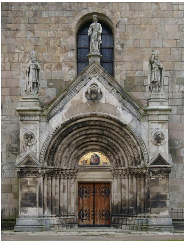
Abb. 1: Das Portal der Klosterkirche von Teplá in Tschechien aus Morley-Oolith vor Beginn des Projektes im Jahre 2010. Es stellt ein bedeutendes Beispiel für die bildhauerische Verwendung von Morley-Oolith dar. Bildhauer Karl Wilfert d. Ä. 1893.
