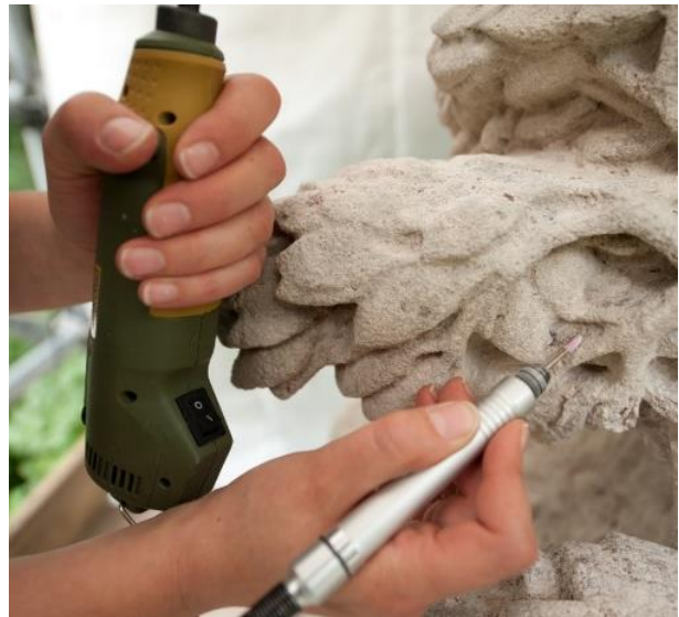
Abb. 31: Mechanische Entfernung der Gipskrusten mit einem Schleifbohrer (Foto H. Leisen).
