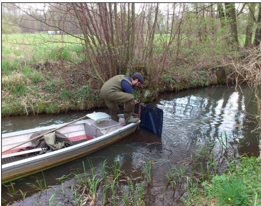
Abb. 21: Anbringen mobiles Schütz an Wasserfahrzeug
