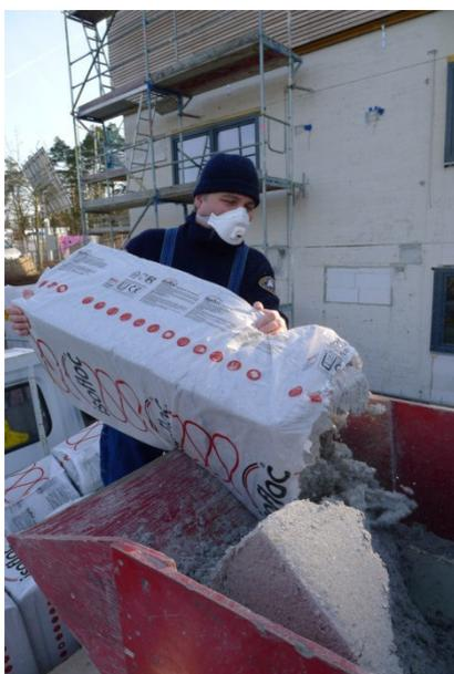
Abb. 4-3: Lehrer Böttiger beim Einfüllen on isofloc-Dämmmaterial
