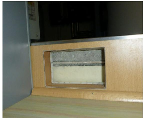
Abb. 7-21: Stufe mit beleuchtetem Sichtfenster zwischen Boden mit Vakuumdämmung und Boden mit konventioneller Dämmung
