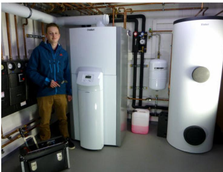
Abb. 7-47: Schüler mit Gasadsorptionswärmepumpe und Solarspeicher
