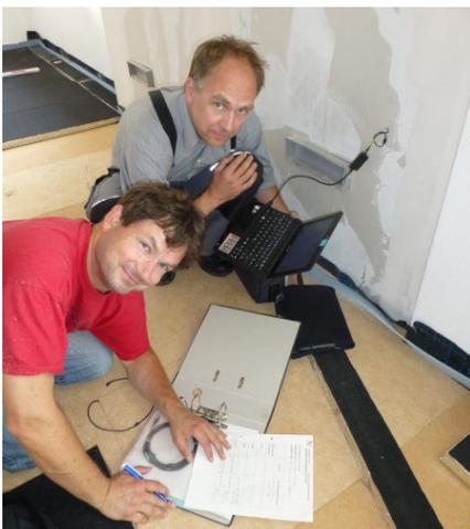
Abb. 7-22: links: Lehrer A. Frankenfeld und J. Happel verlegen Sensoren zwischen allen Ebenen des Fußbodenaufbaus. Rechts: die Vakuumdämmplatten werden passgenau verlegt
