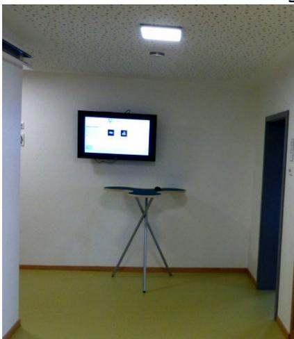
Abb. 7-28: Monitor zur Visualisierung von Zuständen in der Solar- und Heizungsanlage, sowie der Lüftungsanlage
