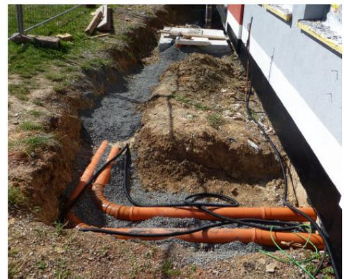
Abb. 6-12: Fundament, Lehrrohre und Kabellehrrohre liegen schon
