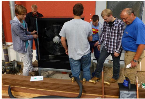
Abb. 6-14: Heizungsbaumeister B. Griesbach bereitet mit ASHK-Azubis das Anschließen der Rohre vor
