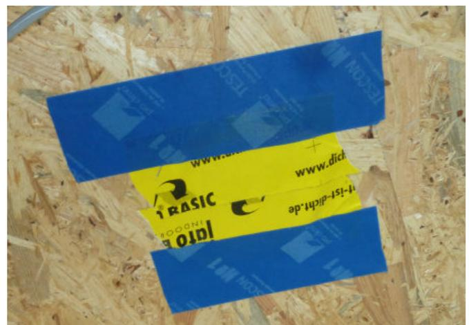
Abb. 7-52: Nachträgliches Ausbessern der nicht dichten Isofloc-Einblasöffnungsverschlüsse
