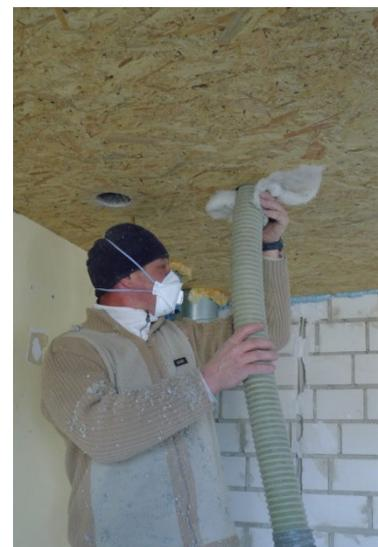
Abb. 4-2: Die Zellulose-dämmung von isofloc wird eingeblasen.
