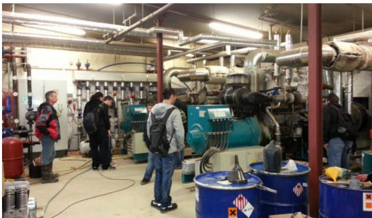
Abb. 6-48: Azubis der Mechatroniker staunen über die zwei großen BHKW-Aggregate in Heinebach, die das Biogas in Strom und Wärme umwandeln
