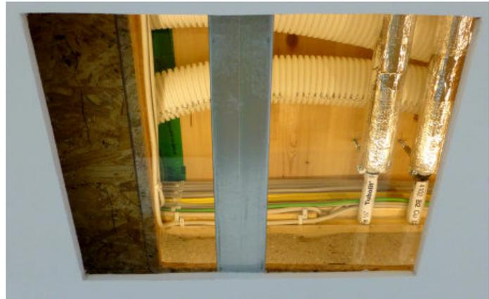
Abb. 7-30: Einblick in gewerkeubergreifende Schnittstellen in der Zwischendecke zwischen Alt- und Neubau
