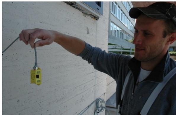
Abb. 6-19: Ein Malergeselle betrachtet kritisch den Sensor, den er gleich unter der Außendämmung verbauen soll
