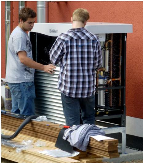
Abb. 6-13: Schüler beim Abnehmen der Verkleidung des Außenwärmetauschers
