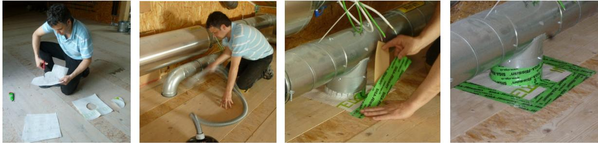
Abb. 7-53: Wenn es keine fertige Manschette gab, musste eine Abdichtung hergestellt werden
