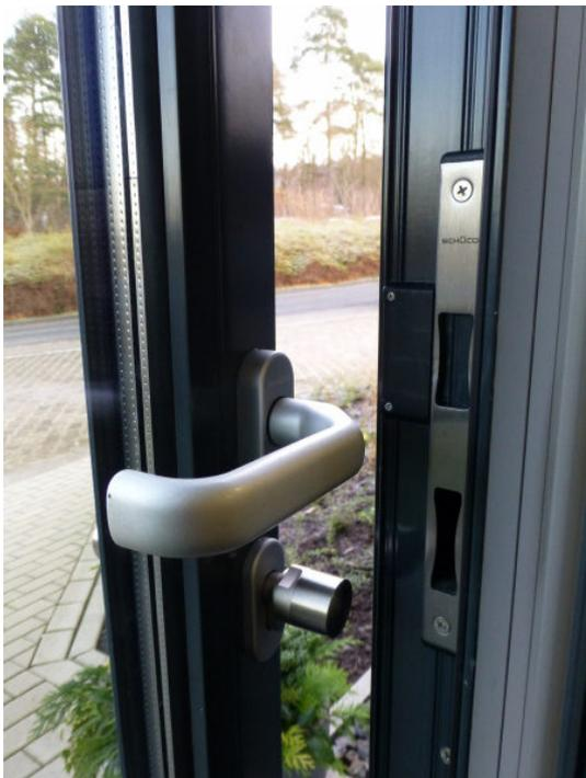
Abb. 7-17: EG-Eingangstür mit Dreischeibenverglasung und Alurahmen
