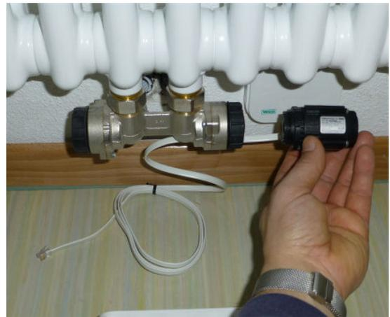
Abb. 7-40: Statt Thermostatventil eine kleine Umwälzpumpe am Heizkörper (Wilo, Geniux)
