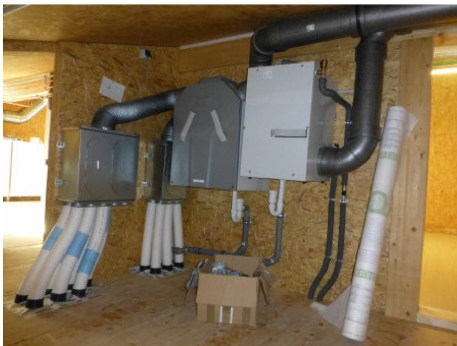
Abb. 7-50: Einfamilienhaus-Lüftungsgerät mit Wärmetauscher zum Einkoppeln von Erdkühlung (Sommer) und Erdwärme (Winter) durch 100m Rohr im Erdreich
