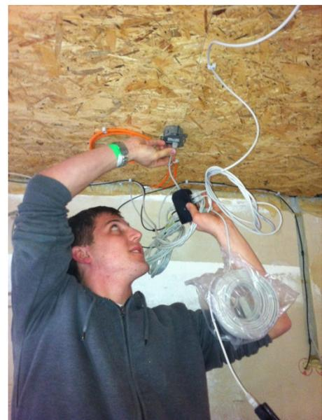
Abb.6-15: Ein Schüler installiert eine Netzwerkdose; über einen Hub werden die Sensoren an den Bus angeschlossen.
