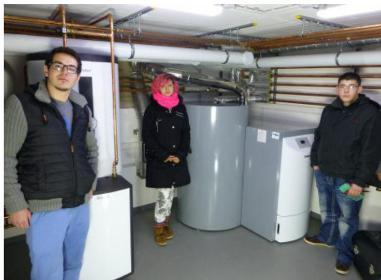
Abb. 7-45: Speicher mit externer Trinkwassererwärmung neben Pelletkessel
