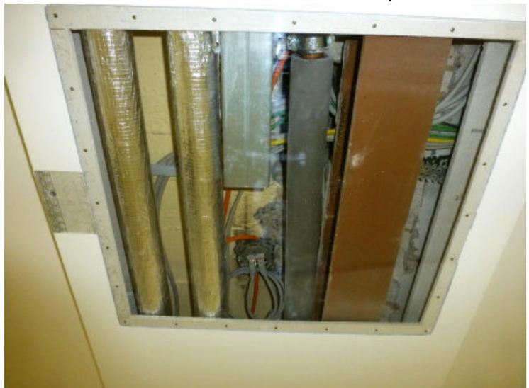
Abb. 7-39: gewerkeübergreifender Deckenunterzug mit Heizungsrohren, Gipskartonunterkonstruktion, Elektroleitungen, Wasserleitung, und Stahlträger
