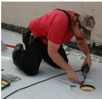
Abb. 7-13: Einschweißen des Bodenablaufes mit der Folie auf der Terrasse
