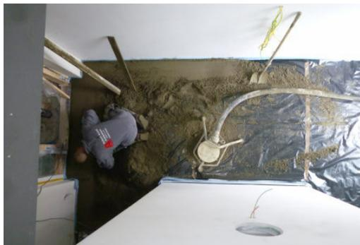
Abb. 7-24: Der Estrichbauer der Firma Arendt bringt den Estrich vom dem Speicher ein. Mit dem Schlauch wird der Estrich hereingepumpt
