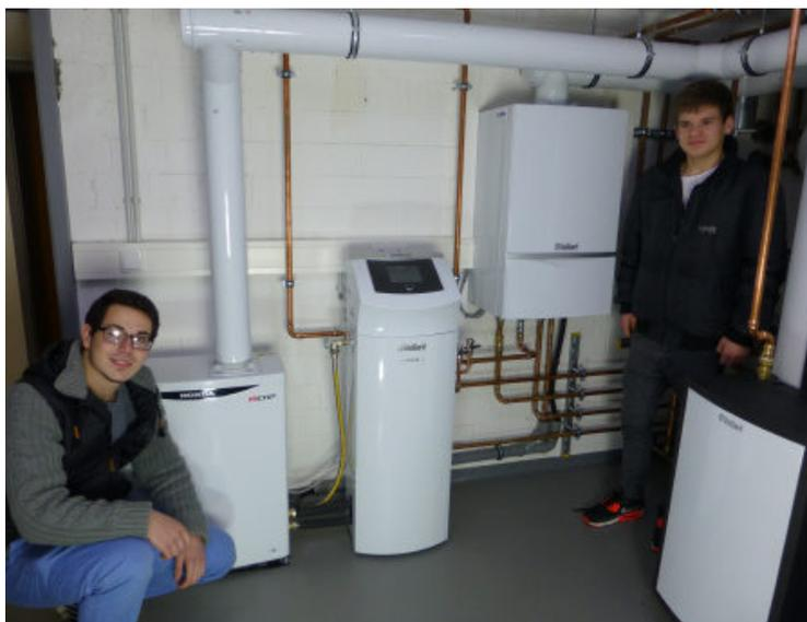
Abb. 7-46: Schüler mit Mikro-BHKW, Koppelungsmodul, Brennwerttherme und Pufferspeicher
