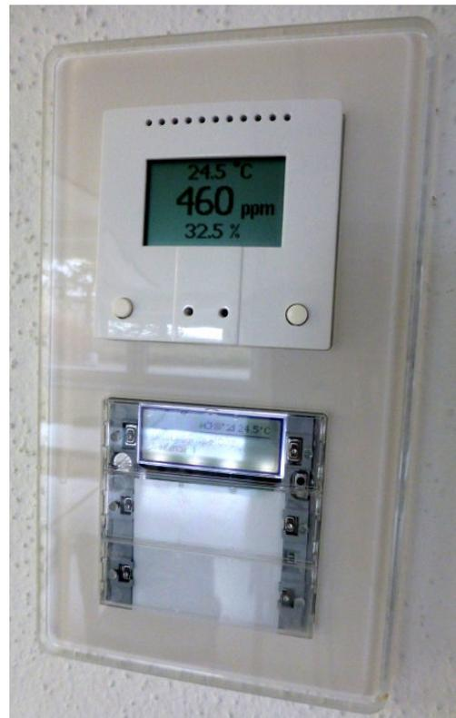
Abb. 7-42: Anzeige von Temperatur, CO<sub>2</sub>-Gehalt und Luftfeuchte mit Tastern zur Bedienung der Lichttechnik und Fensterverschattung (Jalousien) über KNX
