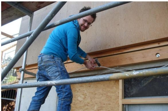
Abb. 6-18: Ein Auszubildender führt die Installation eines Luftfeuchtigkeitssensors an der Außenfassade durch
