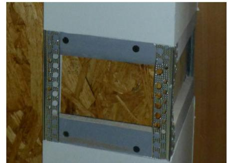
Abb. 7-51: links: Isofloc-Sichtfenster; mitte: Testfeld für Mehrschichtdämmung mit Fühler; rechts: Einblick in Aufbau des Türumrandung
