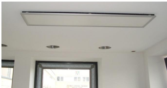
*Abb. 4-5: Flache Bauweise einer LED-Deckenbeleuchtung, besonders vorteilhaft bei niedrigen Räumen.*
