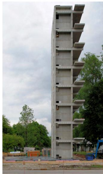
Abb. 40 Montage Betonkern
