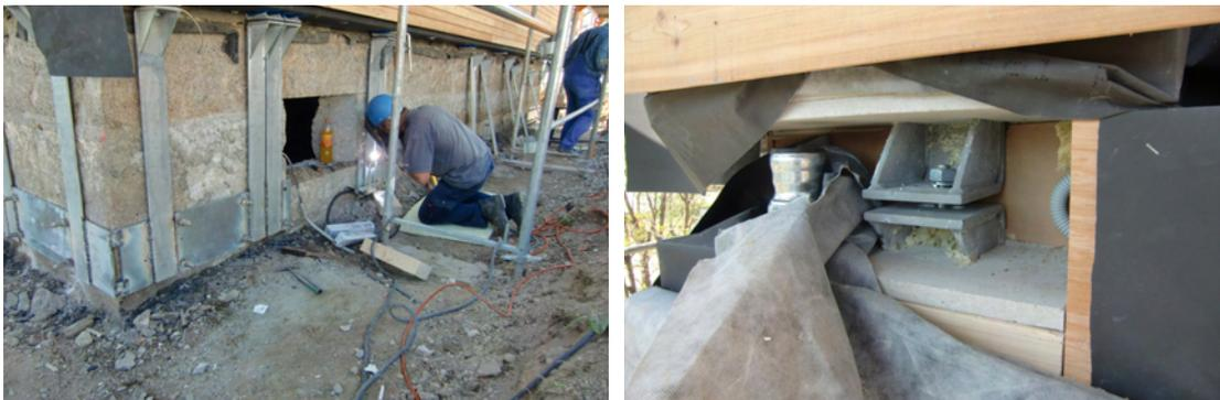
Abb. 21 Anschluss an Stahlzugglieder an den Keller / am Geschoss-Stoß
