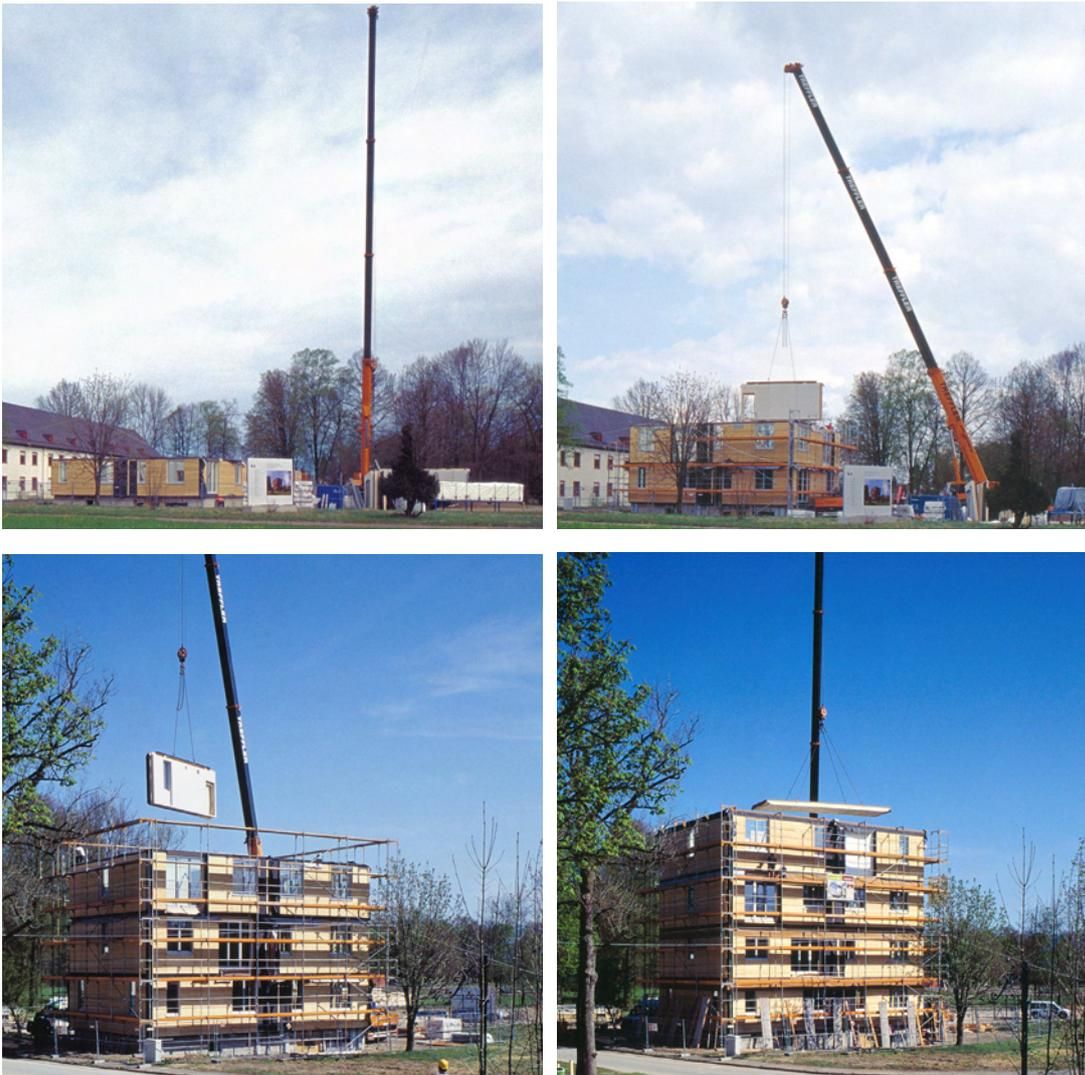
Abb. 16 Montage von einem Geschoss pro Tag
