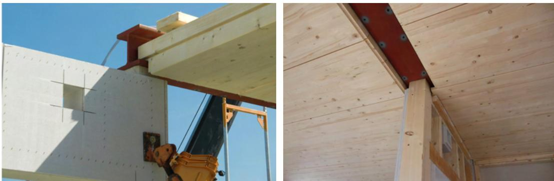
Abb. 20 Deckengleiche Stahlunterzüge
