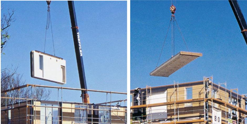
Abb. 17 Montage von Innenwand- bzw. Deckenelementen
