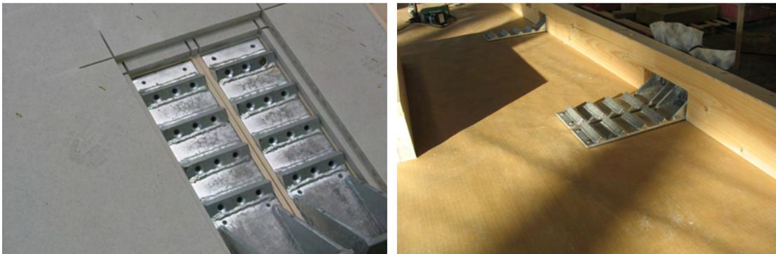
Abb. 22 Einbau der Stahlzugglieder im Werk
