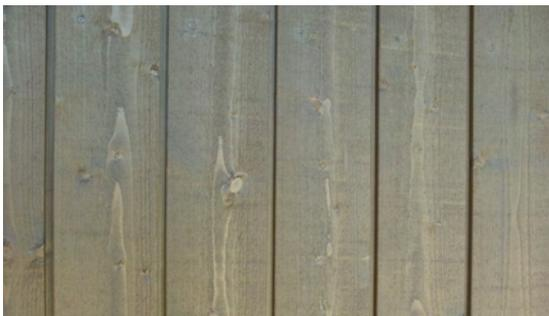
Abb. 30 Holzschalung mit deckender Beschichtung
