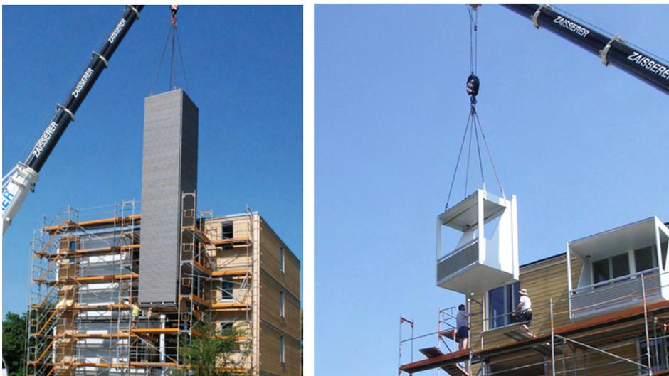
Abb. 18 Montage von Aufzugturm und Balkonen
