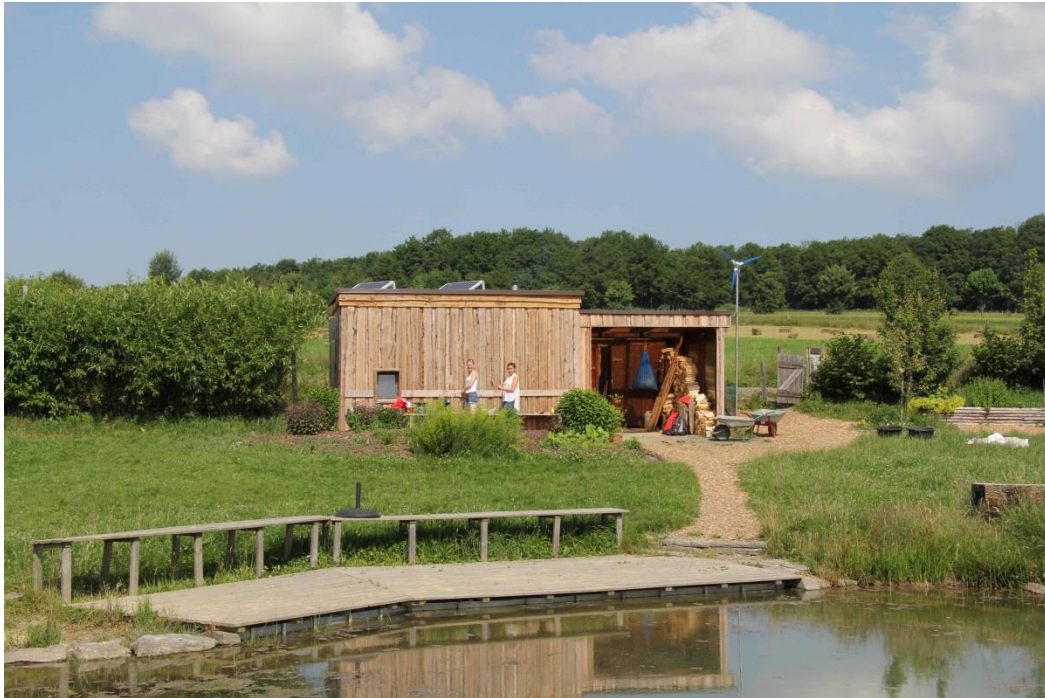
Bild der neu verkleideten Hütte vom Teich aus. Auf dem Dach befinden sich die Solarmodule, daneben das Windrad. Im Vordergrund ist das Beet mit Duft- und Färbepflanzen zu sehen.
