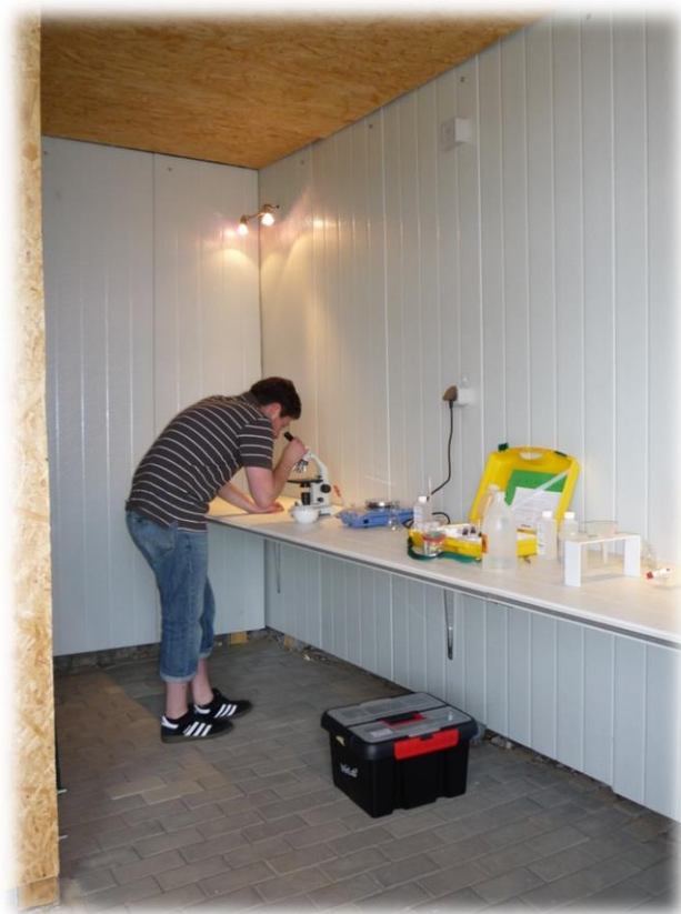
Innenausbau der Hütte
