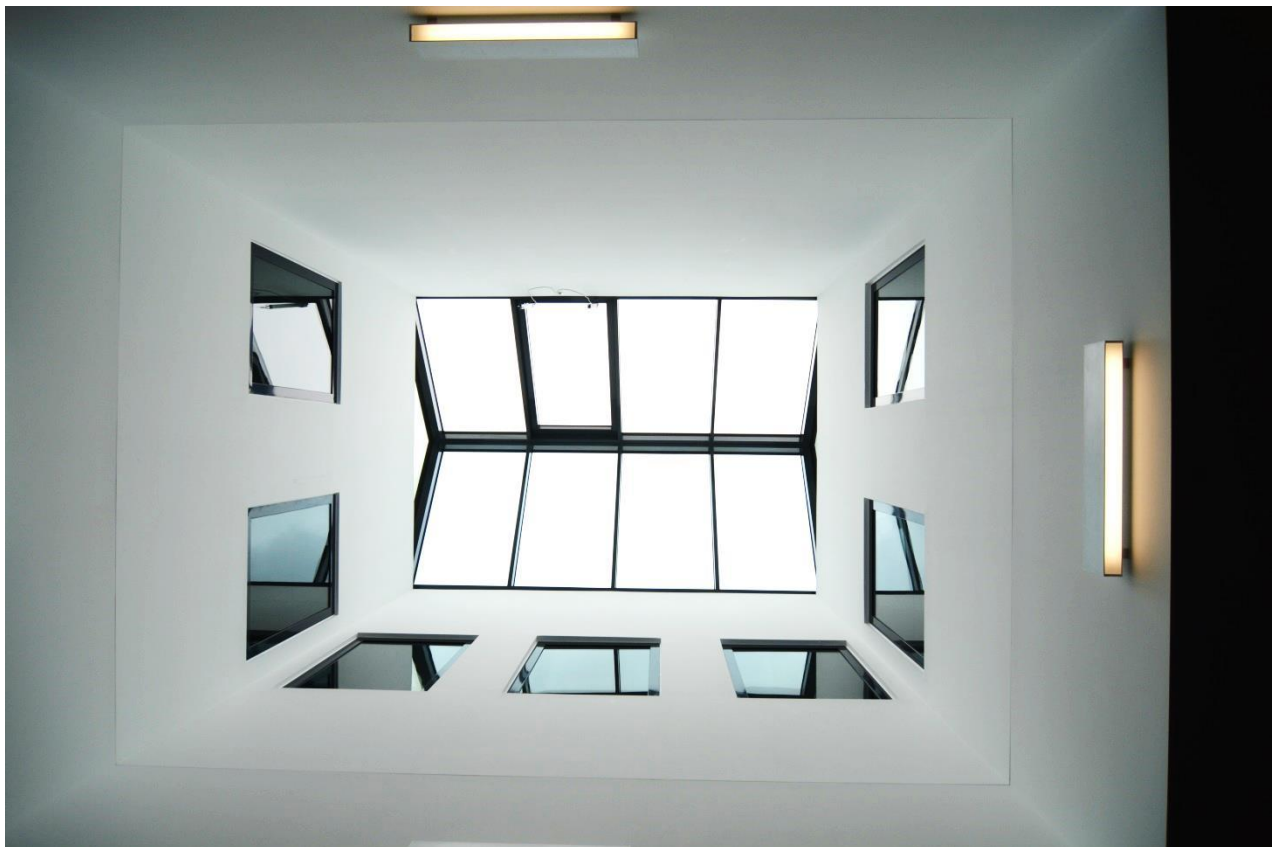
Abbildung 26: Lichtzeldach neu - Quelle: AB Haase
