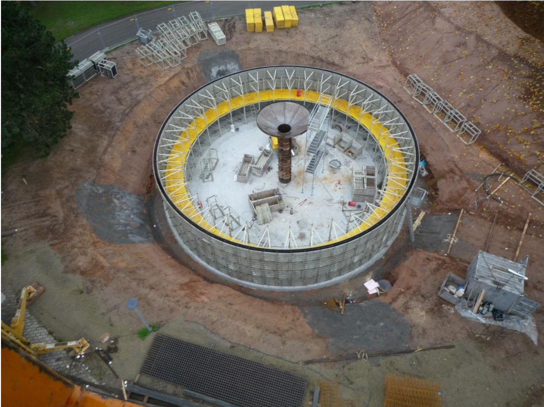
Abbildung 37: Bauarbeiten der Wand des Eisspeichers - Quelle: AB Haase
