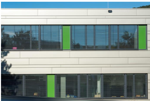
Abbildung 41: Fassadenansicht mit farbigen Elementen für Lüftungsgitter - Quelle: AB Haase
