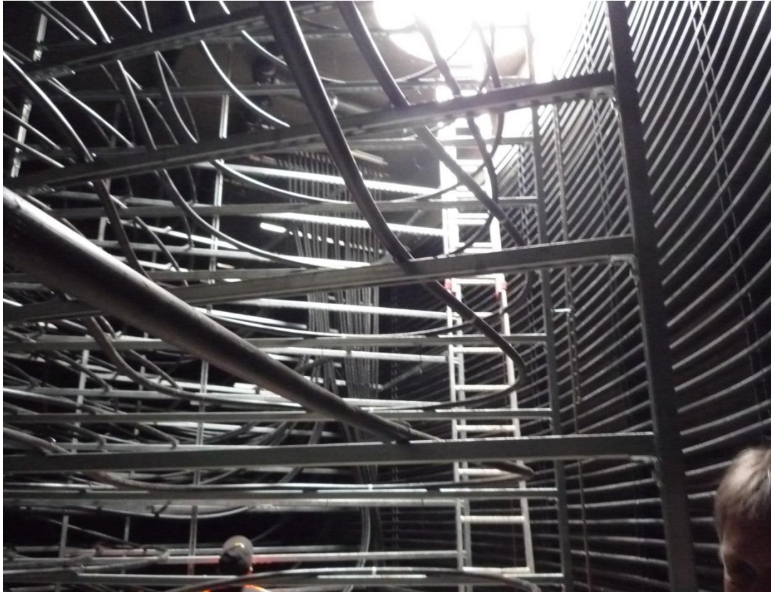
Abbildung 39: "Innenleben des Eisspeichers - Quelle: AB Haase
