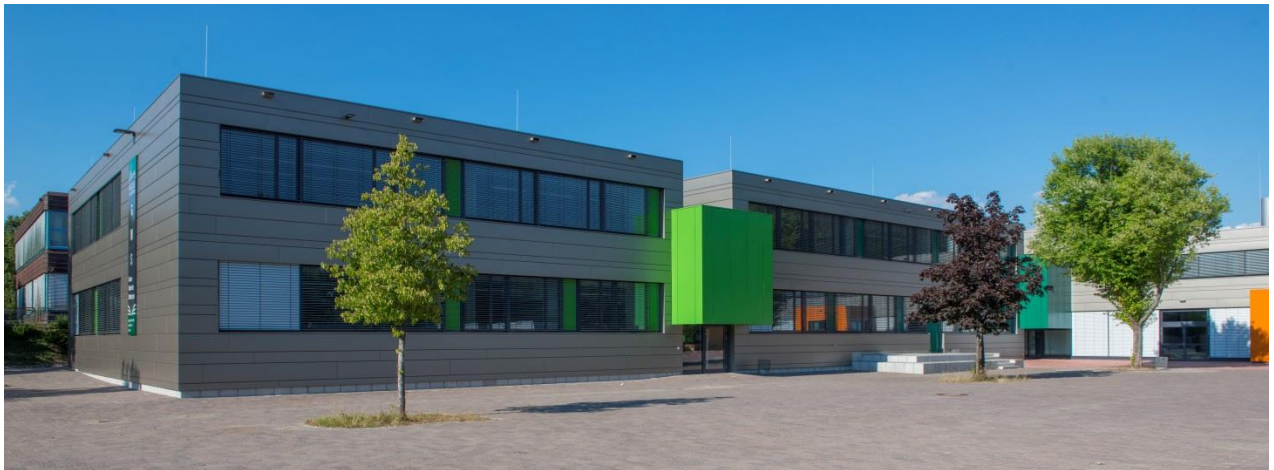
Abbildung 30: Fassade (Quelle: Thyssenkrupp)
