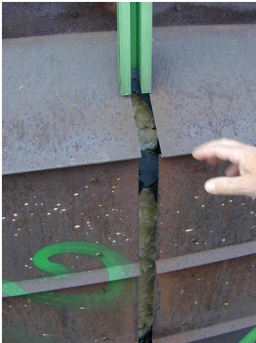
Abbildung 5: verbrauchte Corten-Fassade - Quelle: AB Haase
