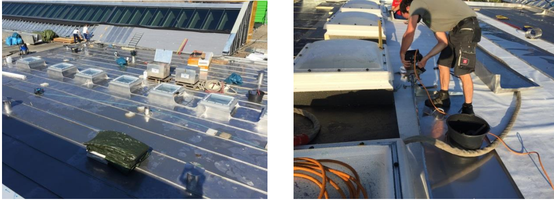
Abbildung 29: Edelstahl Dach in der Erstellungsphase - Quelle: AB Haase
