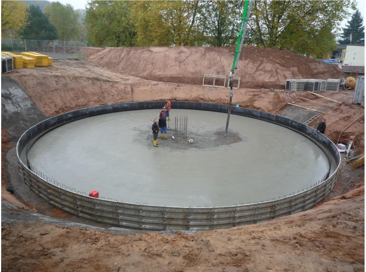
Abbildung 36: Bodenplatte des Eisspeichers - Quelle: AB Haase
