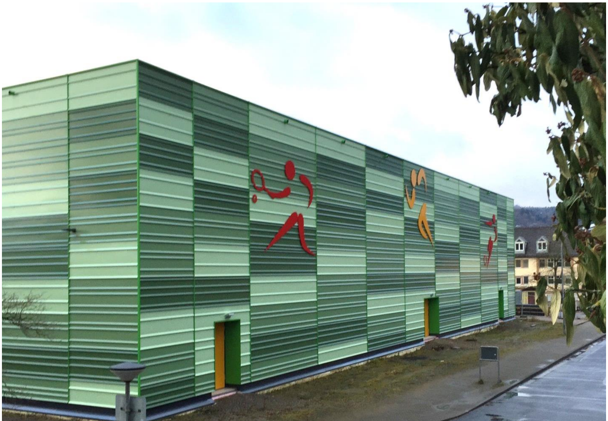
Abbildung 48: Sporthalle Fassade - Quelle: AB Haase
