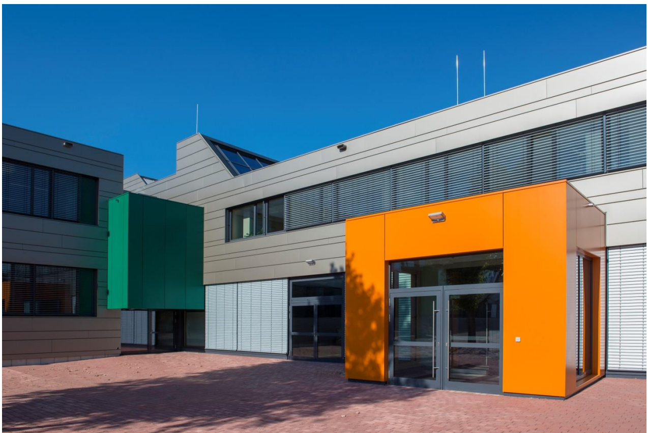
Abbildung 31: Fassade (Quelle: Thyssenkrupp)
