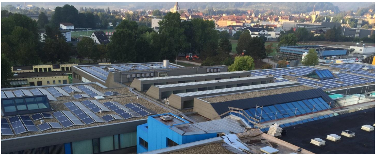
Abbildung 43: PV-Module Ost / West Ausrichtung - Quelle: AB Haase
