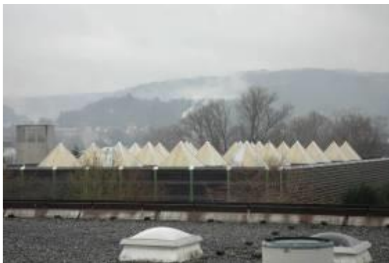
Abbildung 8: Flachdach Sporthalle mit Lichtpyramiden - Quelle: AB Haase
