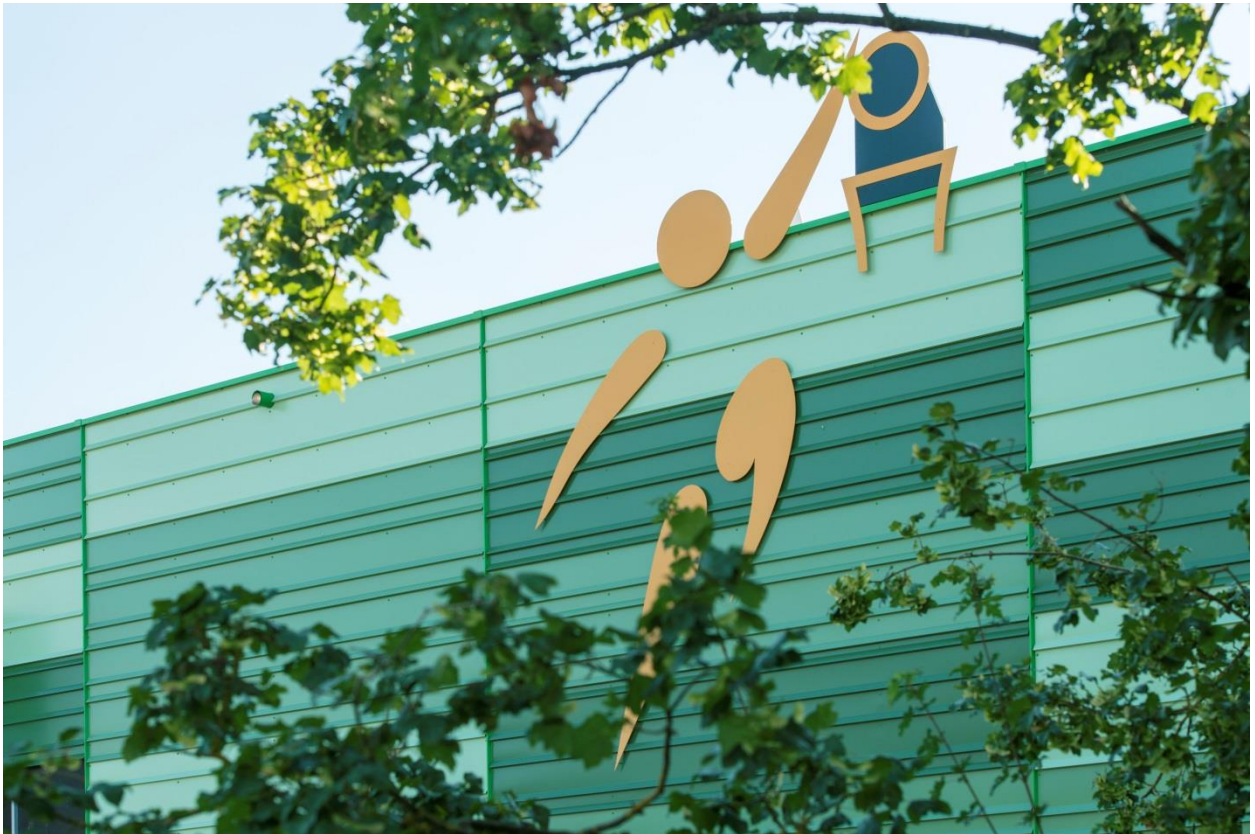
Abbildung 49: Fassade saniert - Quelle: Thyssenkrupp
