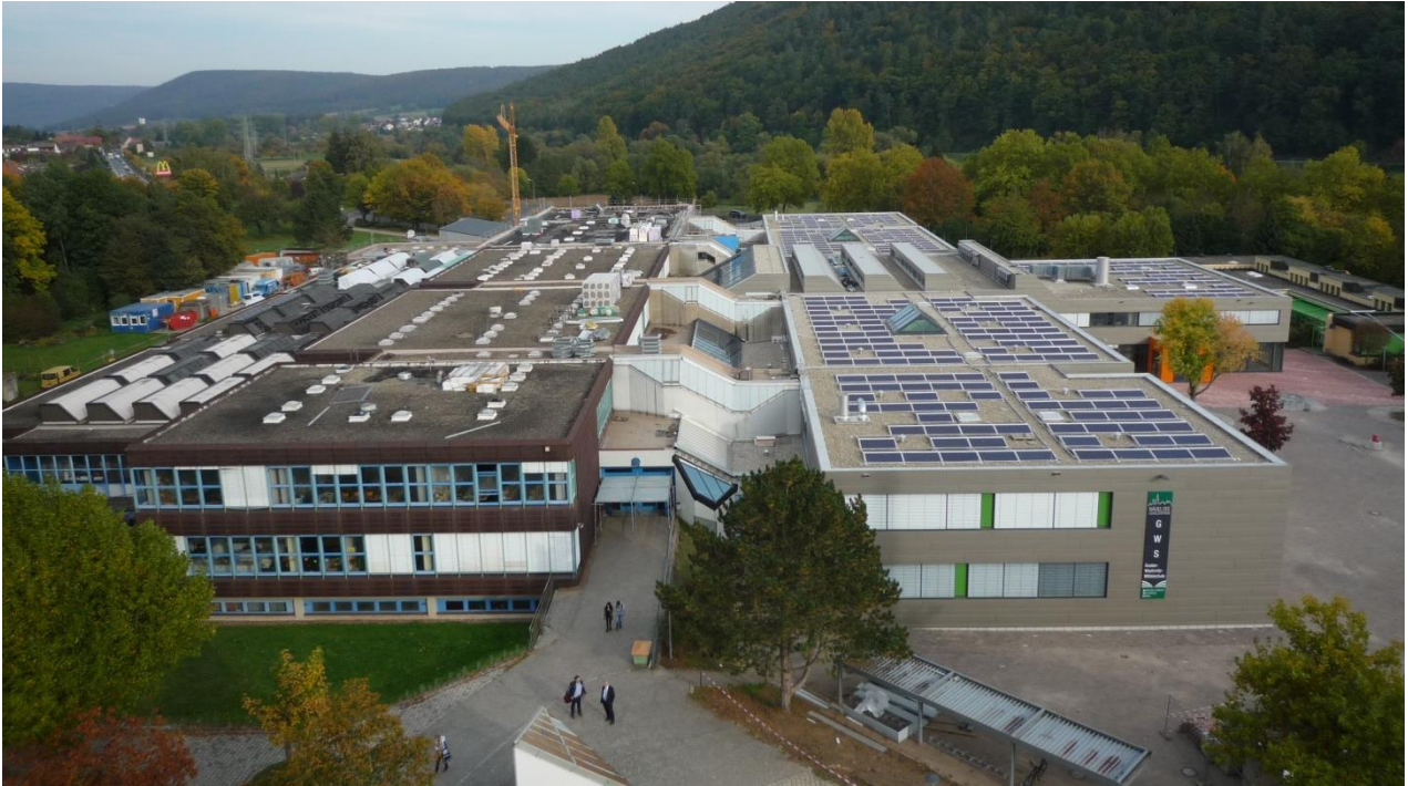
Abbildung 27: Dachlandschaft - Bestand und saniert - Quelle: AB Haase
