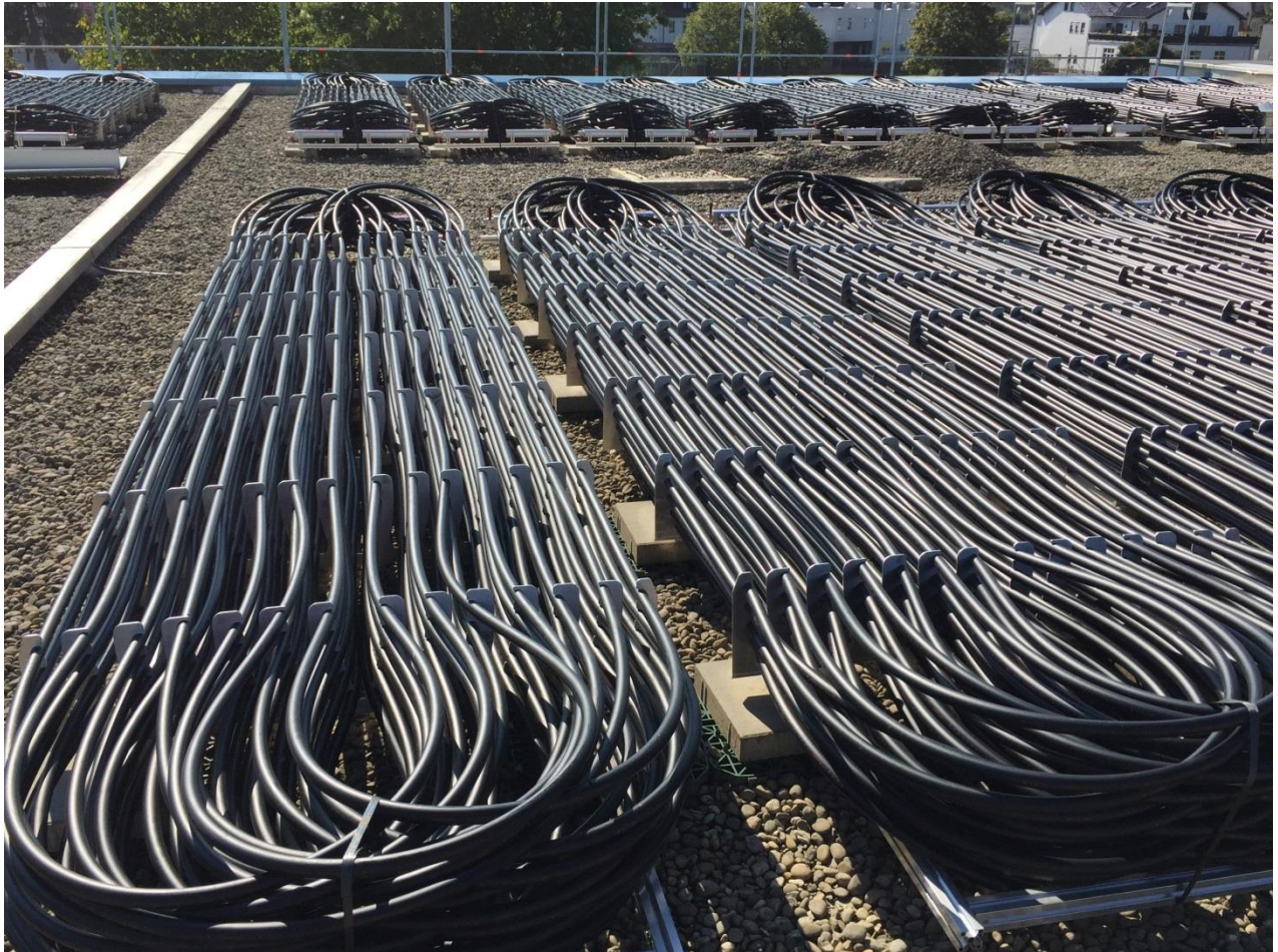
Abbildung 40: Rohrbündel-Absorber - Quelle: AB Haase
