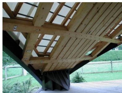
Abb. 183: Auflager Diagonalen [54]
