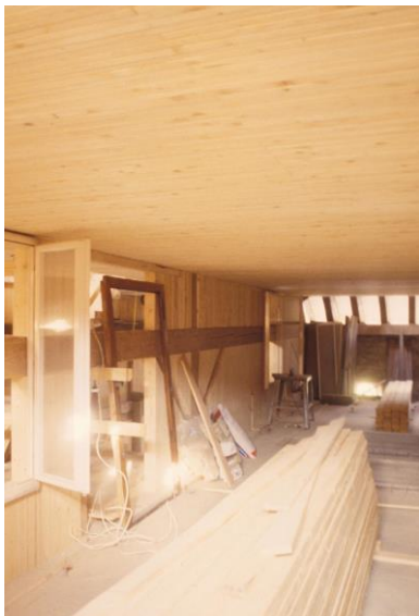
Abb. 56: Innen während Umbau [54]
