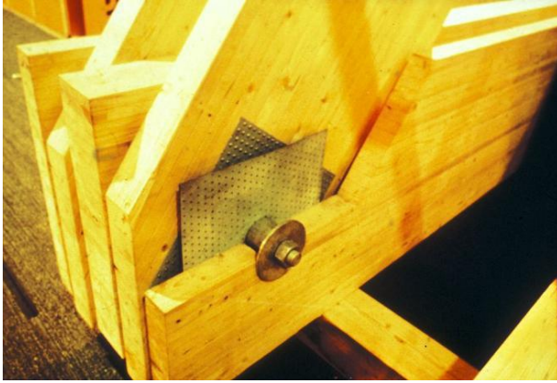
Abb. 3: Gelenkbolzenverbindung [54]
