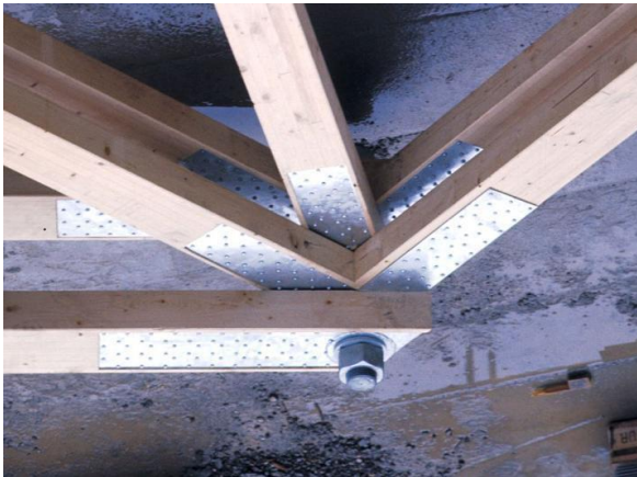
Abb. 5: Gelenkbolzenverbindung [54]
