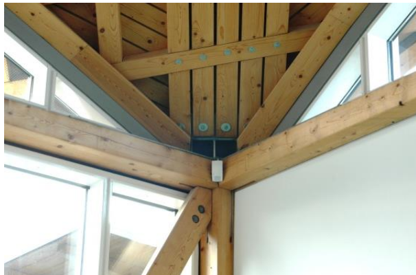
Abb. 179: Detail Eckauflager Rippenschale [52]
