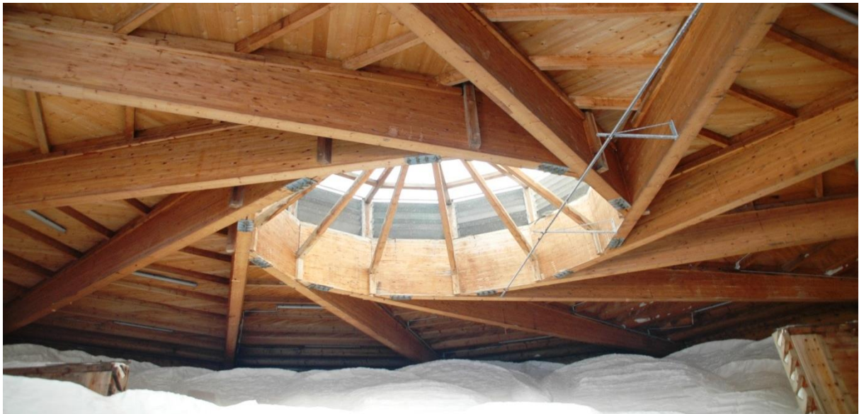
Abb. 230: Dachkonstruktion radialer Rost [52]
