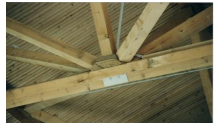
Abb. 256: Detail Strebenanschluss [54]
