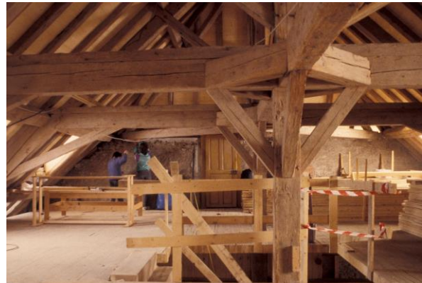
Abb. 55: Innenraum während des Umbaus [54]
