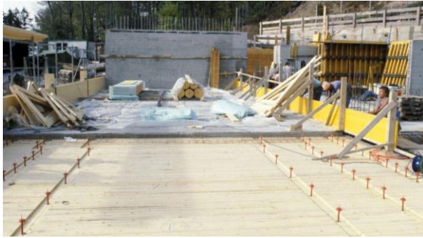
Abb. 81: Brettstapeldecke Bauphase [54]
