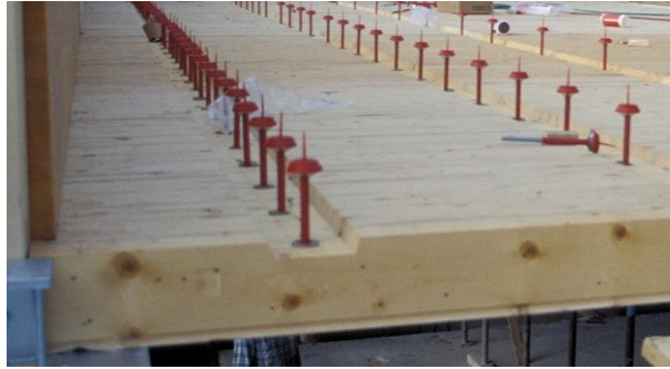
Abb. 82: Brettstapeldecke Kerve [54]
