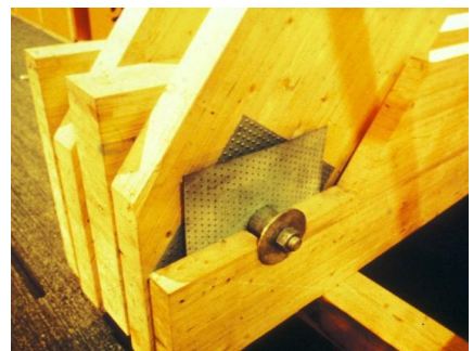
Abb. 194: Gelenkbolzenverbindung [54]
