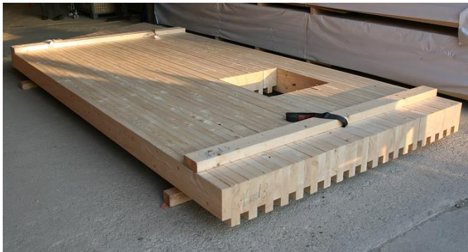
Abb. 27: Brettstapelelement mit Plus-Minus-Profil [53]
