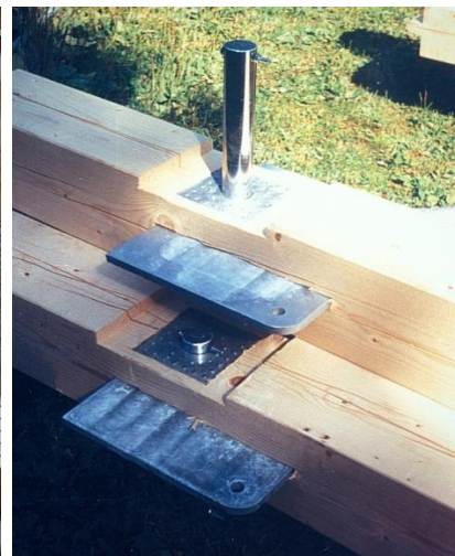
Abb. 107: Detail Gelenkbolzen [54]
