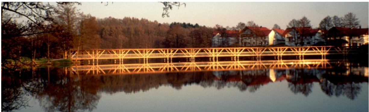
Abb. 300: Ansicht der Brücke über den Ortweiher [54]
