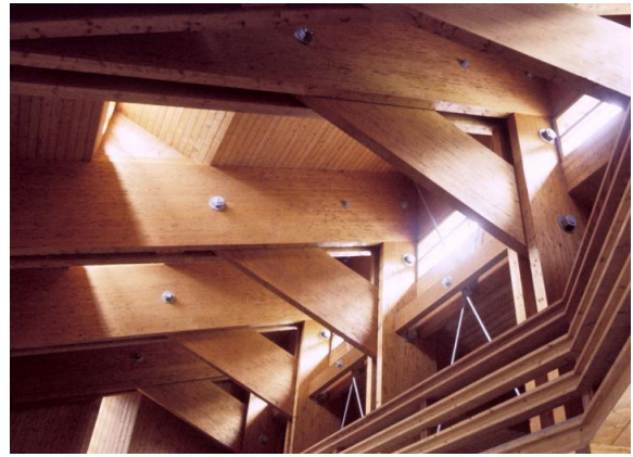
Abb. 4: verdeckte Gelenkbolzenverbindung [54]
