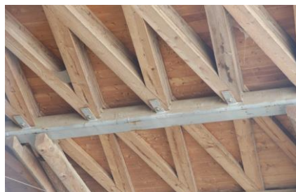
Abb. 253: Rippenanschluss [52]
