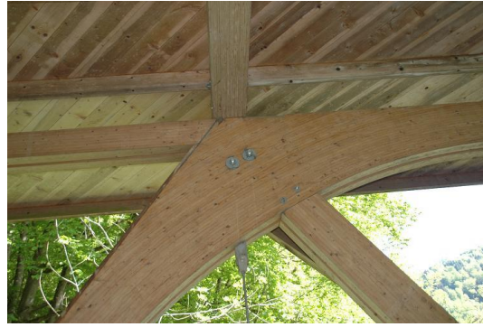
Abb. 278: Detail Rahmenecke [52]
