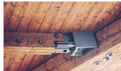
Abb. 317: Rippenanschluss [54]
