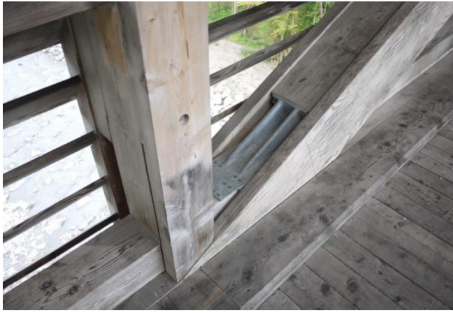
Abb. 292 u. Abb. 293: Anschlussdetail Untergurt-Strebe-Pfosten-Querträger [52][54]
