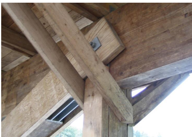
Abb. 290 u. Abb. 291: Anschluss Obergurt-Strebe-Pfosten mit Versatzschuh und Gelenkbolzenverbindung [52][54]
