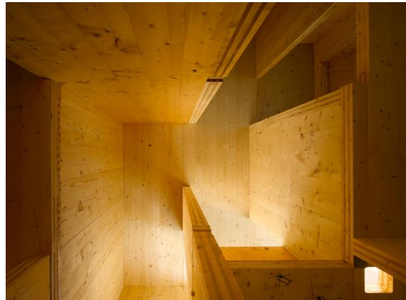
Abb. 754: Verwendung von Brettsperrholz [11]
