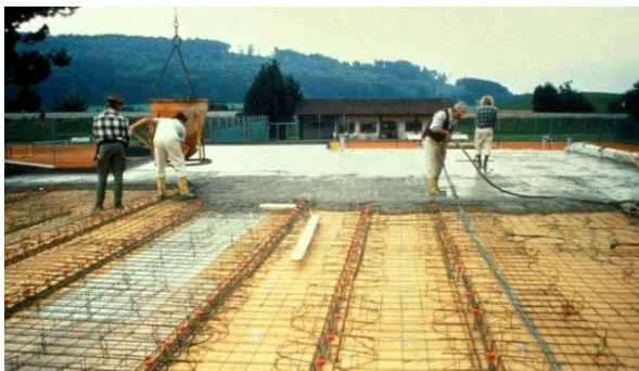
Abb. 91: Bauphase Deckenbetonierung [54]
