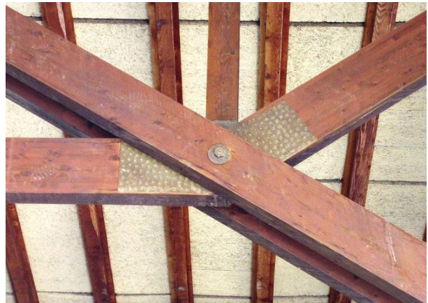
Abb. 6: Gelenkbolzenverbindung [52]
