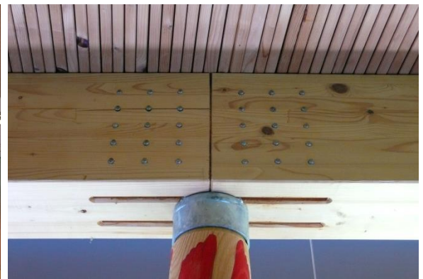
Abb. 71: Detail Auflager [53]
