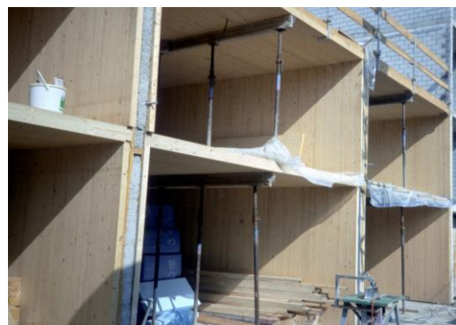
Abb. 28: Schaanwald Rohbau Brettstapel [54]
