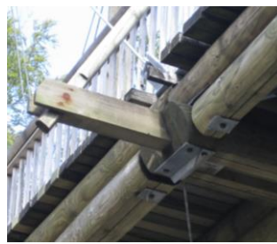
Abb. 285 u. Abb. 286: Balkenanschluss [52][54]
