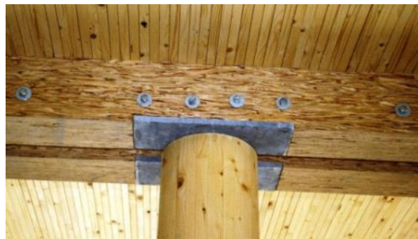
Abb. 92: Detail Auflager [54]
