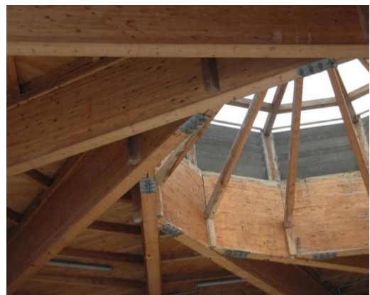
Abb. 232: Detail Trägeranschlüsse [52]
