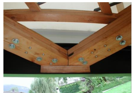
Abb. 184: Detail Rippenanschluss [54]
