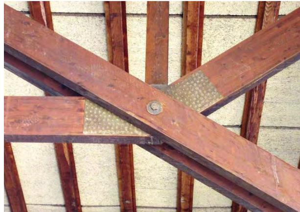
Abb. 6: Gelenkbolzenverbindung [52]
