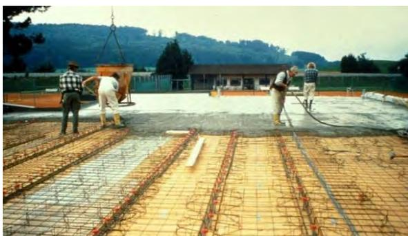
Abb. 91: Bauphase Deckenbetonierung [54]
