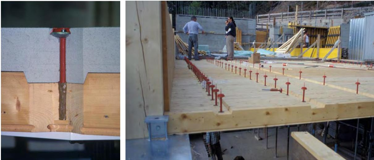
Abb. 757 u. Abb. 758: Holz-Beton-Verbund, Brettstapel mit Kerfe als Verbundelement [54]
