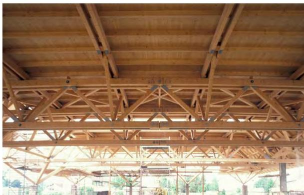
Abb. 219: Innenansicht Tragwerk [54]
