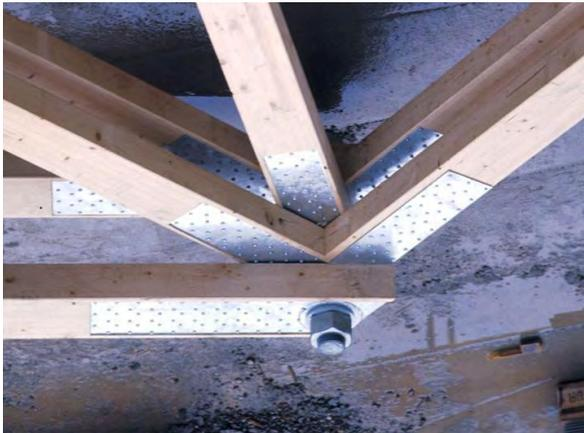
Abb. 5: Gelenkbolzenverbindung [54]
