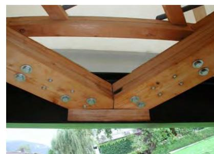
Abb. 184: Detail Rippenanschluss [54]
