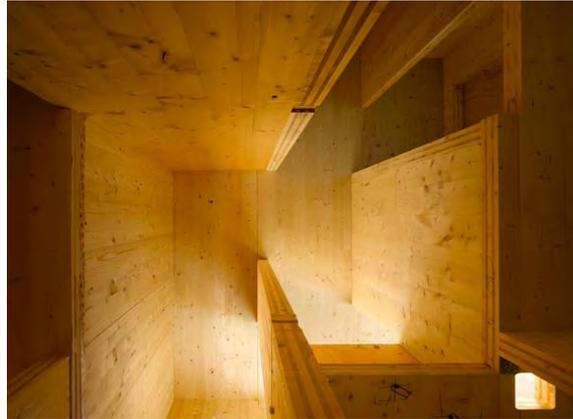
Abb. 754: Verwendung von Brettsperrholz [11]
