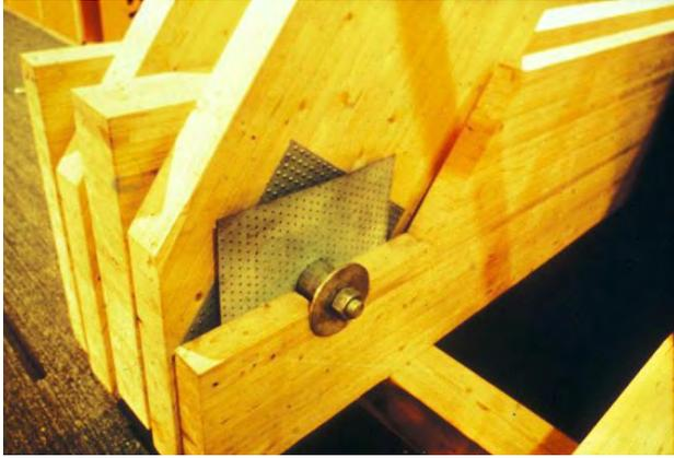
Abb. 3: Gelenkbolzenverbindung [54]
