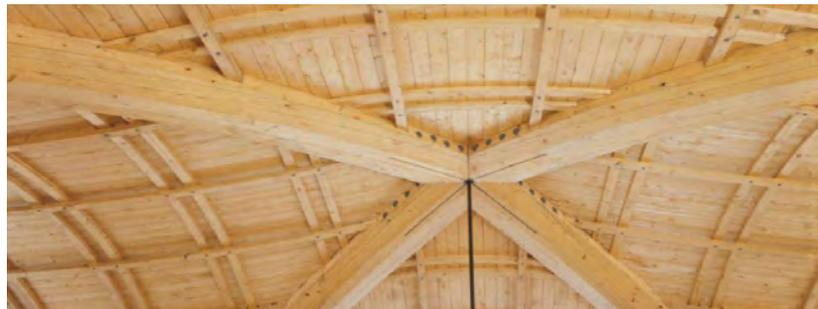
Abb. 307: Mittelpunkt, Zusammenschluss der Teilflächen und Rippen [54]
