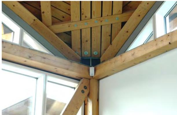
Abb. 179: Detail Eckauflager Rippenschale [52]
