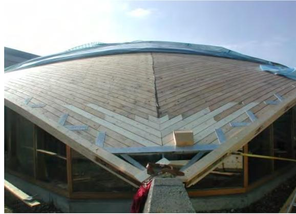
Abb. 235: Auflagerpunkt, Dachschalung [54]
