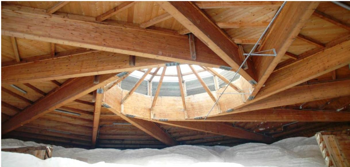
Abb. 230: Dachkonstruktion radialer Rost [52]
