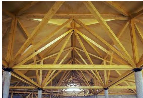
Abb. 170: Strebenbündel Dachkonstruktion [54]
