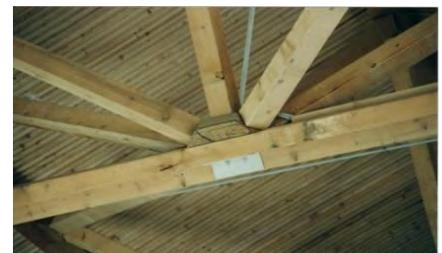
Abb. 256: Detail Strebenanschluss [54]
