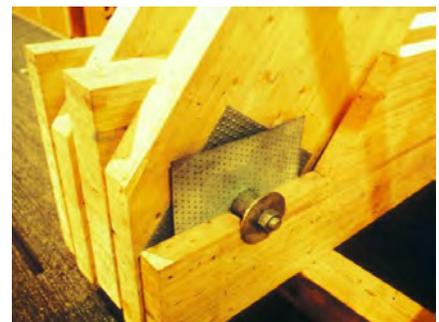
Abb. 194: Gelenkbolzenverbindung [54]
