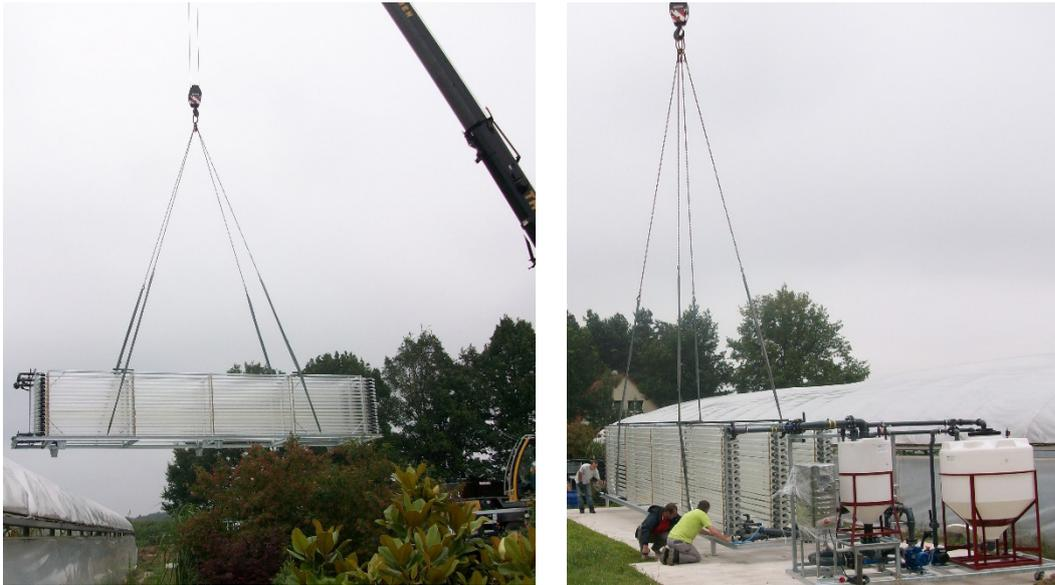
Abb. 31 und 32 Aufbau und Installation des PBR3000 im Außenbereich der Aquakultur- Kreislaufanlage Elsholz
