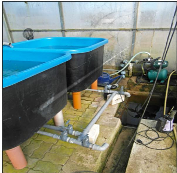
Abb. 5 Fischwasser- Auffangbecken im Innenbereich
