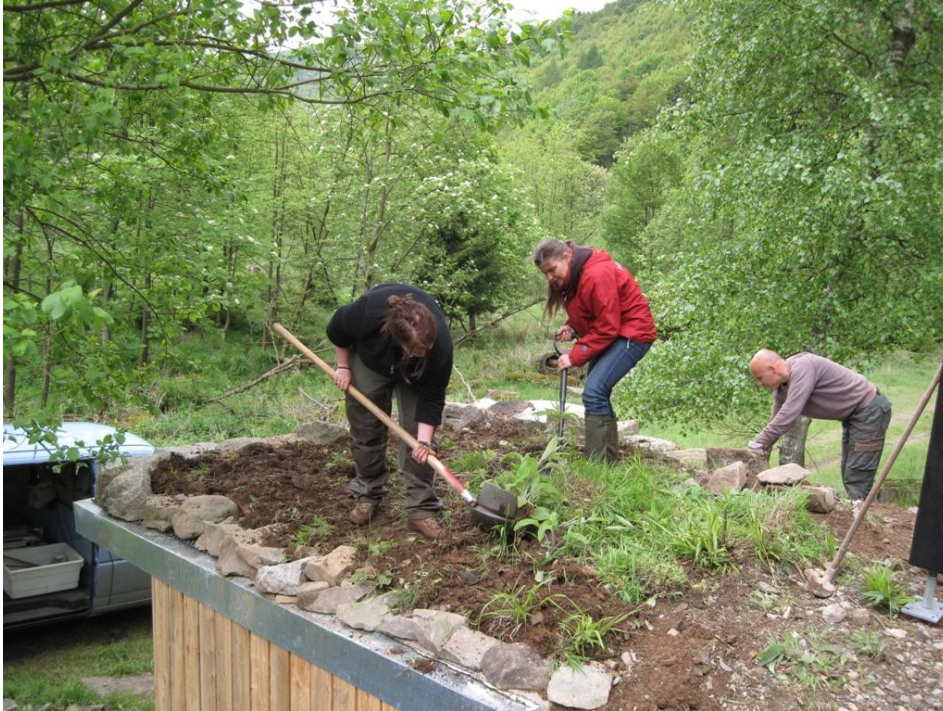
Abb. 9: Freiwillige arbeiten bei der Installation eines Gründachs
