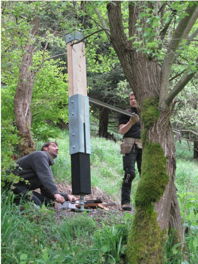
Abb. 11: Freiwilliger unterstützt die Richtarbeiten bei der Ausstellung eines Stützpostens
