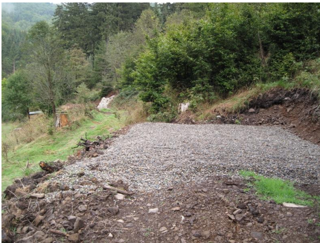
Abb. 8: Kiesbett als Unterlage für einen Schlafshelterplatz zum Schutz gegen Feuchtigkeit im Tal des Nationalpark-Wildniscamps
