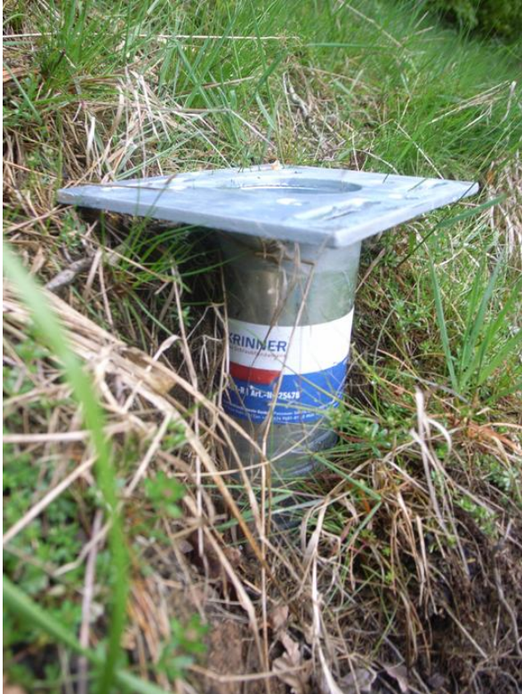
Abb. 7: Schraubfundamente ohne Einsatz von Beton
