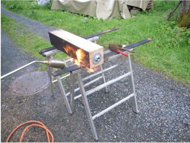
Abb. 3: Schwärzen von Teilen der Holzstützen zur natürlichen Haltbarmachung.
