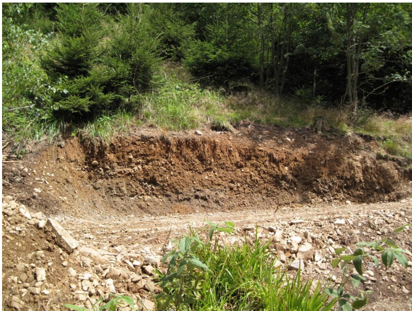
Abb. 6: Erdarbeiten zur Schaffung einer ebenen Fläche für einen Schlafshelterplatz
