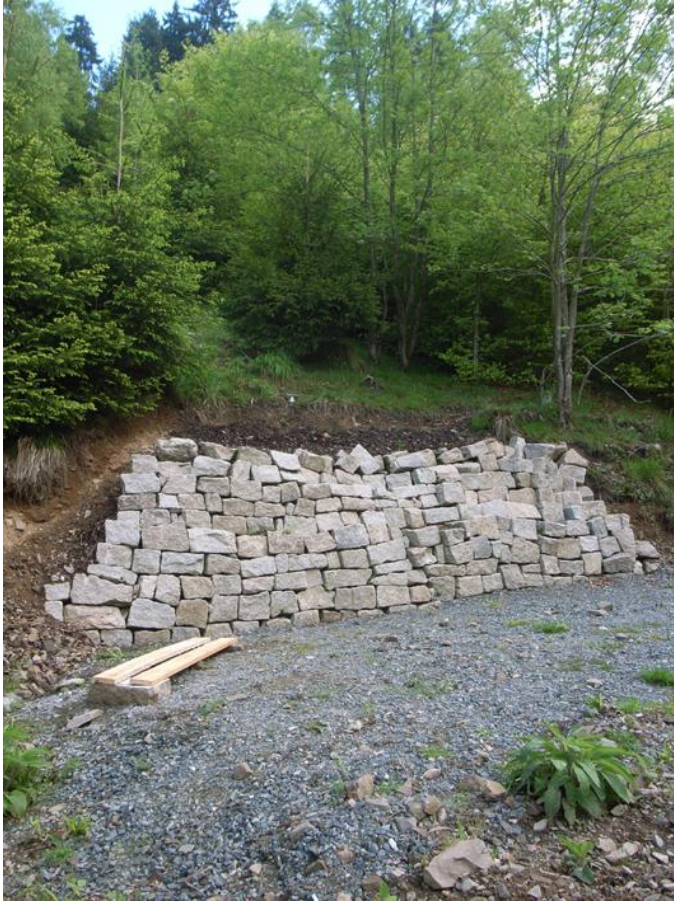
Abb.5: Errichtung einer Natursteinmauer aus Granit zur Hangsicherung für die zukünftige Lehr- und Versammlungseinheit ohne Maschineneinsatz
