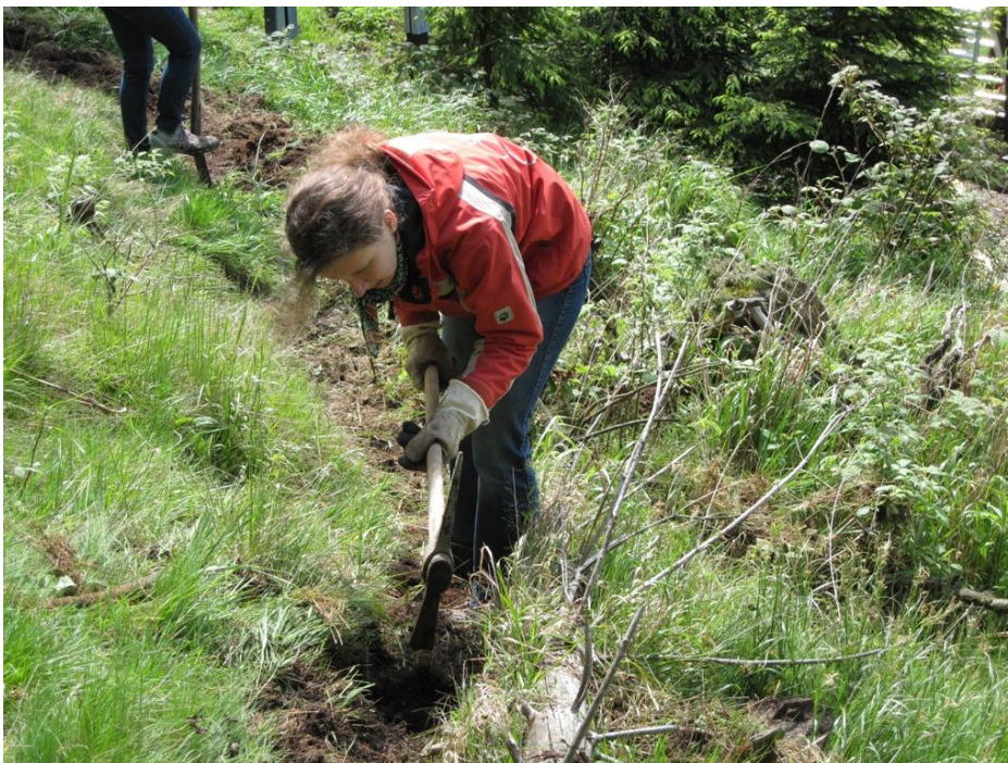
Abb. 10: Freiwillige bei der Anlage eines schmalen Weges zur Trocken-Trenntoilette
