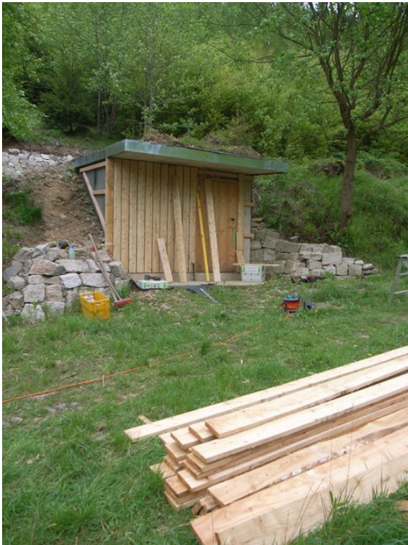
Abb. 4. Gesägte Lärchenholzbretter für das Lagergebäude (das Holz stammt aus dem Nationalpark Harz)
