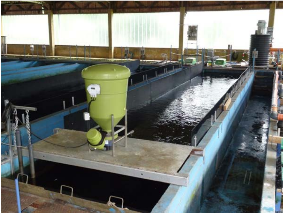
Abb. A2.1: Futterautomat und Fischhaltungsrinne (vor Installation der seitlichen Vorhänge aus PVC-Planen)
