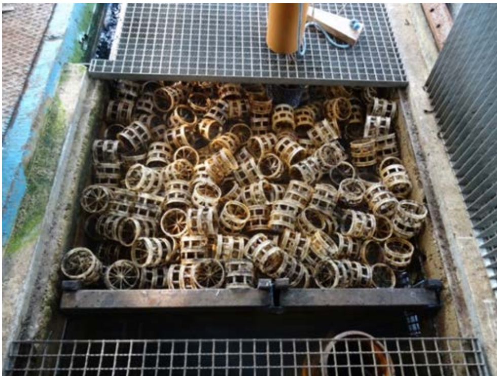
Abb. A2.4: Grobfilter als Festbettfilter mit Füllkörpern großer Abmessungen
