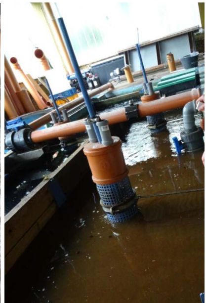
Abb. A2.8: getauchter Festbettfilter, links: Auflagegitter für die Füllkörper mit darunter liegenden Druckluftleitungen und Reinigungswasserabflüsse für das Rückspülen des Filters, Mitte: Expansion des Betts und Lösung der Feststoffe durch Drucklufteinpeisung, rechts: Ablauf des Reinigungswassers bei angehobenen Verschlussstopfen der Reinigungswasserabflüsse
