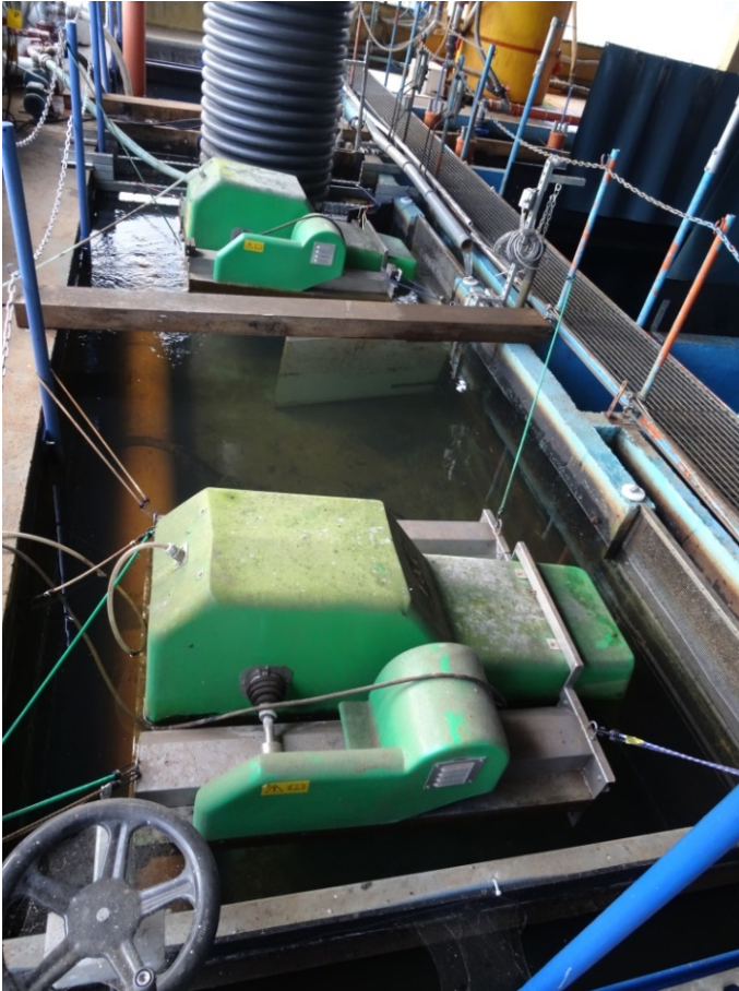
Abb. A2.11: Sauerstoffbegasungsbecken mit den zwei schwimmenden O 2 -Niederdruckbegasern, rechts Rinnenzuläufe mit Sieben (rechts), Sauerstoffschalttafel (links)
