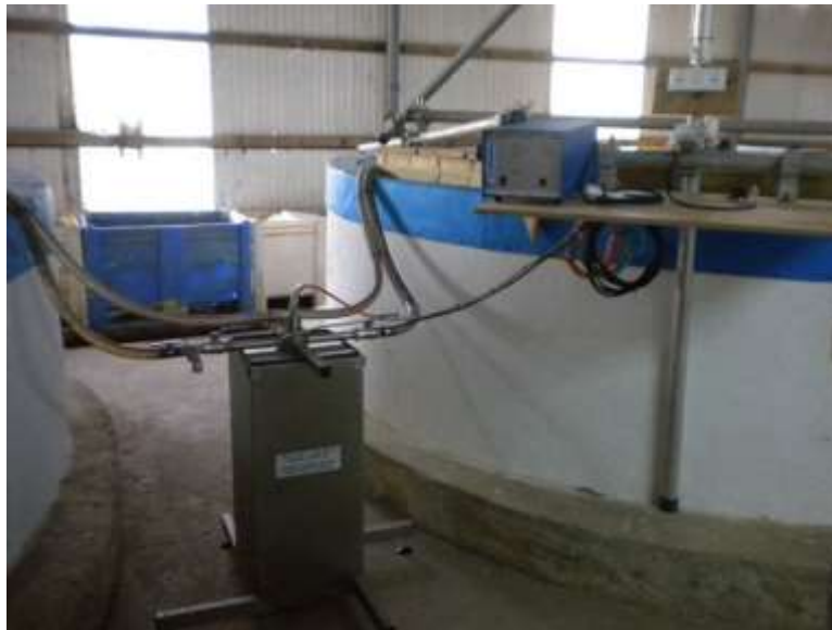
Bild 6: Eingebauter Gegenstromreaktor im Labor bei AquaVet/Israel
