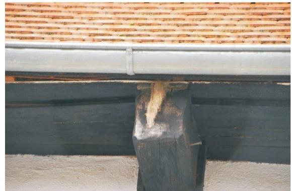
In der Dach- und Fassadendämmung des Gutsgebäudes haben sich Haussperlinge niedergelassen. Ein Verschluss der Einflugöffnungen könnte eine weitere Zerstörung der Dämmung verhindern, würde aber auch die Gefahr des Einschusses von Tieren mit sich bringen. Zu empfehlen ist die Anbringung einer Ausweichmöglichkeit und die anschließende Sanierung der Dämmungsschäden.
