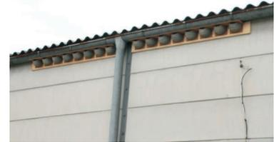
Mehlschwalbennisthilfe wird im Traufbereich angebracht und mit Kotbrett versehen, um so Verschmutzungen der Fassade zu vermeiden. wartungsfrei
