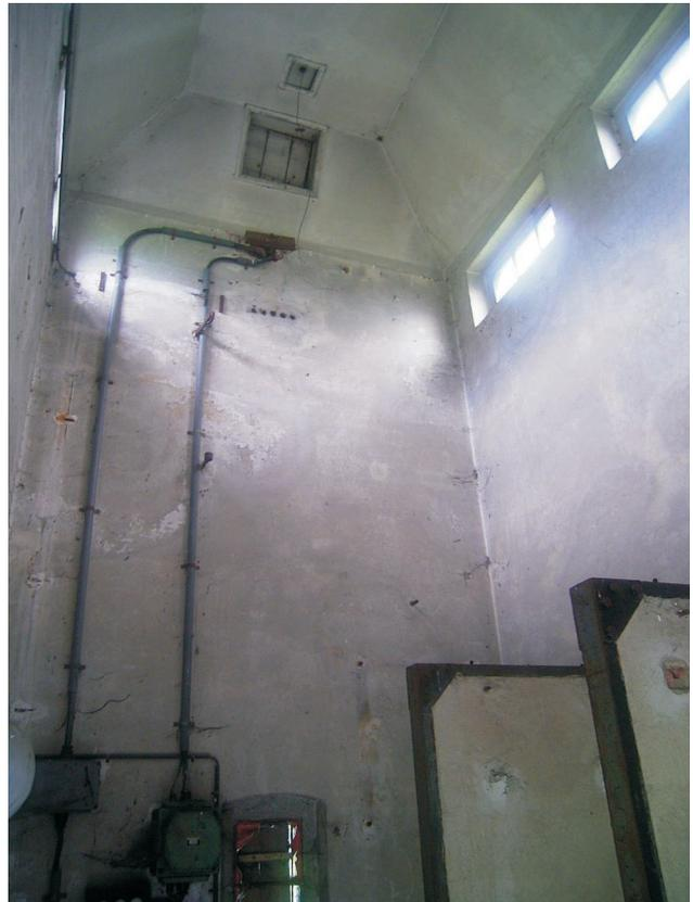
Das nicht mehr genutzte Trafostation in der Ortslage Mittelherwigsdorf wurde bereits im Rahmen eines Vorprojektes baulich ertüchtigt (Dachinstandsetzung, Ausbau der Trafotechnik, Fassadenanstrich). Ebenso wurden bereits konventionell Nistkästen in verschiedensten Bauformen installiert.
