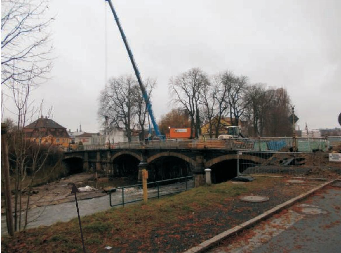
Im Rahmen der Sanierungsarbeiten an der Zittauer Mandaubrücke wurden die Unterkonstruktion sowie der Zulauf des Goldbaches baulich ertüchtigt. Da durch die Stahlbetonbauweise viele Strukturen verloren gehen, bietet es sich hier an, Nisthilfen für die Wasseramsel direkt über dem Bachlauf und im Schutz des Brückenbauwerkes zu installieren.
