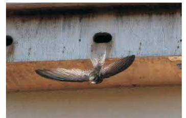
Mauerseglerkasten, angepasst an die Dachrundung, schräg im Traufbereich des Turmes montiert. leicht demontierbar, wartungsfrei
