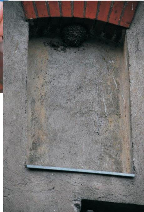
Im Rahmen des Vorhabens wurde der Schwalbenkot entfernt und ein als Fensterbank ausgefertigtes Kotbrett montiert, welches sich bei Bedarf leicht reinigen lässt. Auch werden so Feuchtigkeitsschäden bei Regen verringert.
