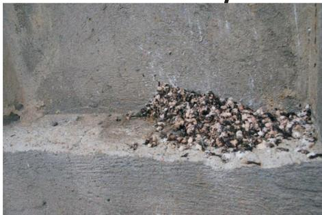
Die durch Schwalbennester in den zugemauerten Fensteröffnungen aufgetretenen Verschmutzungen schädigen die Bausubstanz und stellen ein Problem an der als Veranstaltungsgebäude genutzten Scheune dar.
