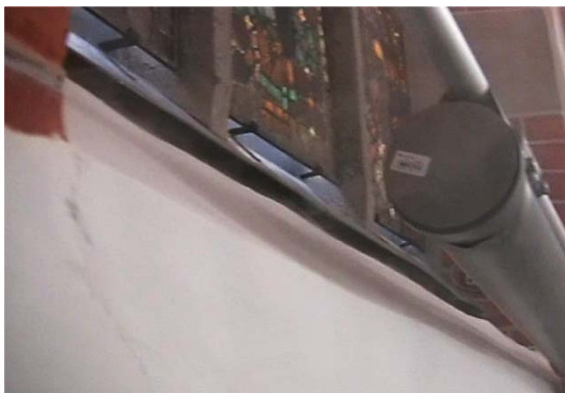
Abb. 20 Hussitenfenster mit Spalt zwischen Schutzverglasung und historischer Verglasung Quelle: Frei, Stefan (2011)
