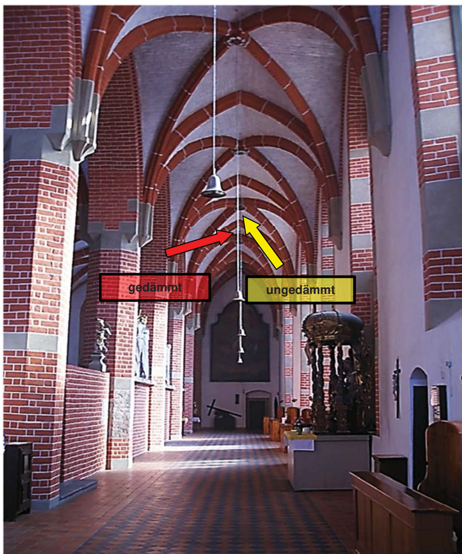
Abb. 88 Oberer Kirchgang mit Kennzeichnung der Messgewölbe; (23.02.2011) Quelle: N. Lange
