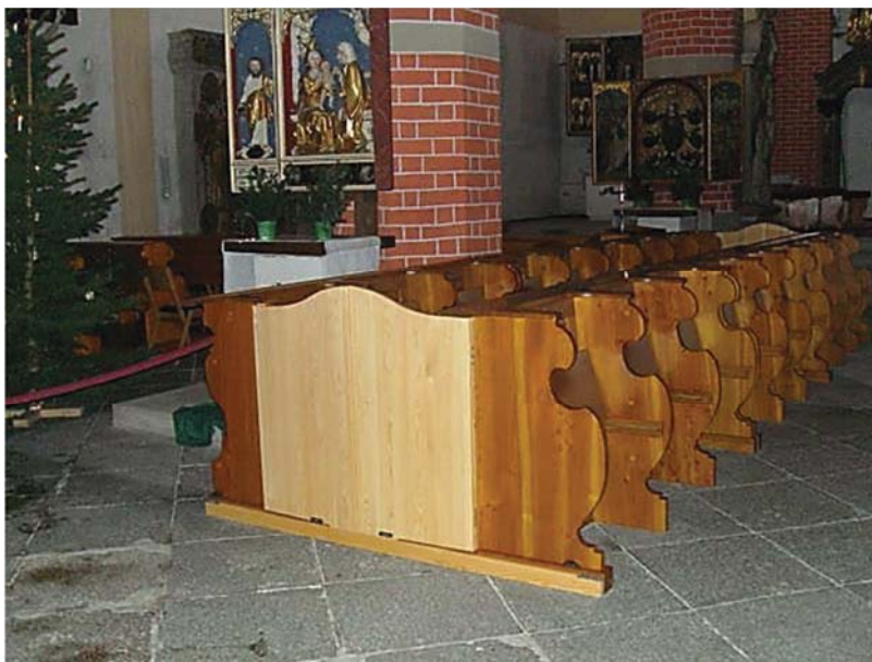
Abb. 6 Klapptüren an den seitlichen Zugänge zur Reduzierung von Luftströmungen im Fußbereich des Chorgestühls Quelle: IDK e.V.
