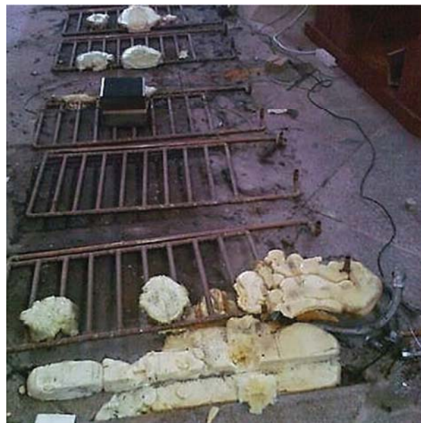
Fußbodenheizung unter Chorgestühl
