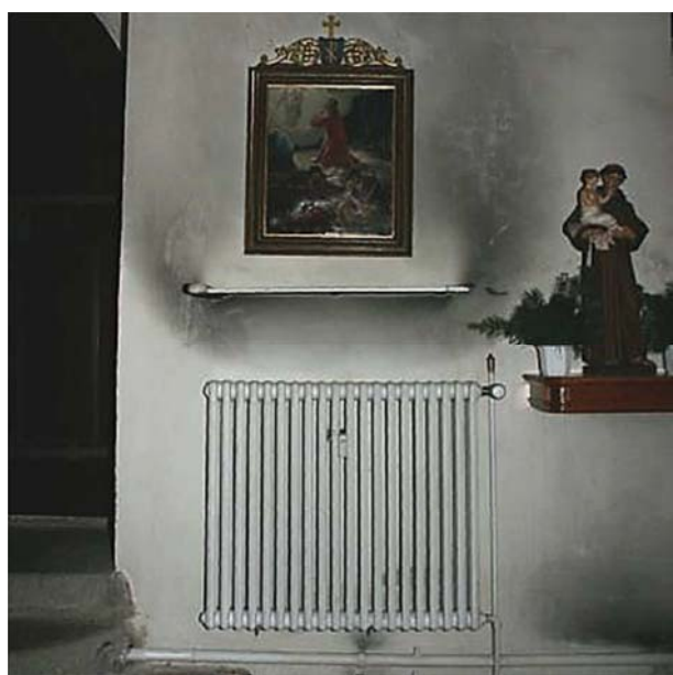
Heizkörper an Wandfläche
