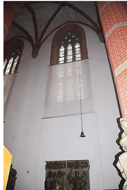
Abb. 29 aufgezogene Stoffwindschotte an den nördlichen Maßwerkfenstern der Klosterkirche Quelle: IDK e.V.
