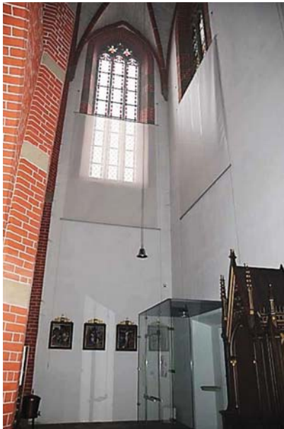
Abb. 29 aufgezogene Stoffwindschotte an den nördlichen Maßwerkfenstern der Klosterkirche Quelle: IDK e.V.
