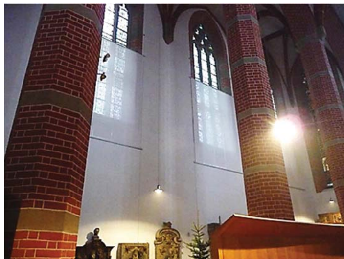
Abb. 30 aufgezogene Stoffwindschotte an den nördlichen Maßwerkfenstern der Klosterkirche Quelle: IDK e.V.
