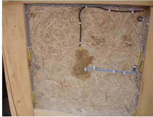
Bild 16: Äußere Sensorik an der Grenzschicht 1, unterhalb des Außenputzes, Foto IBP
