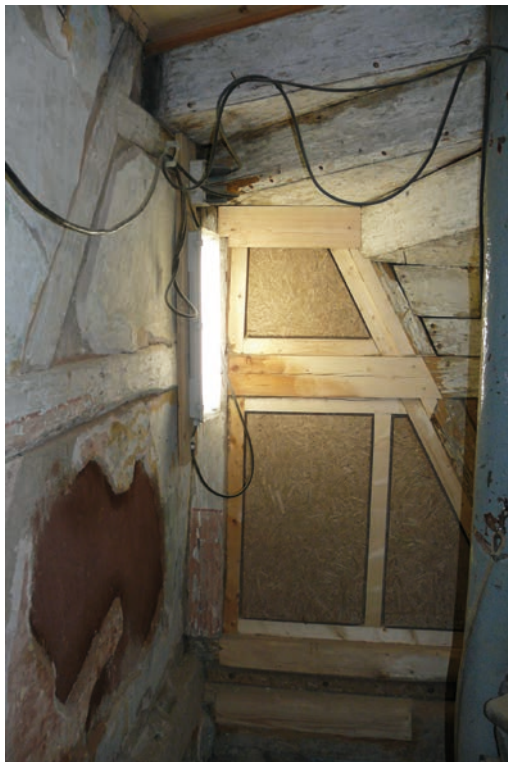
Ausfachtung der Kommunwand mit Typha-Platten, Foto Helmut Knodt
