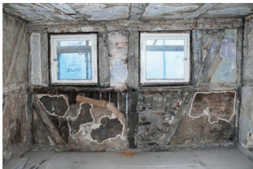
Bild links unten: Mischung von Reparatur- materialien schädigten das Baugefüge, Foto Alexand- ra Fritsch
