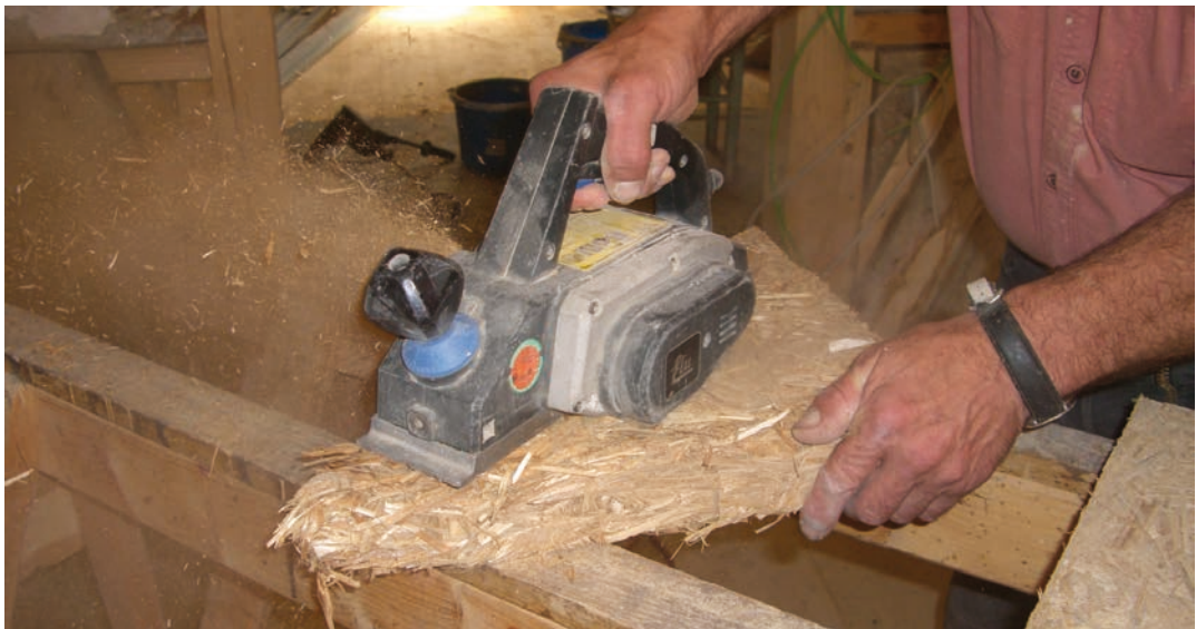
Anpassen und Zurichten an die Bestandskonstruktionshölzer, Foto Architekturbüro Fritsch+Knodt&Klug
