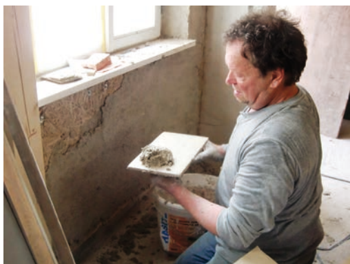
Innendämmung und Lehmputz an Sandsteinwand, Foto Alexandra Fritsch
