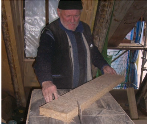
Zuschneiden der Typha-Platte, Foto Alexandra Fritsch
