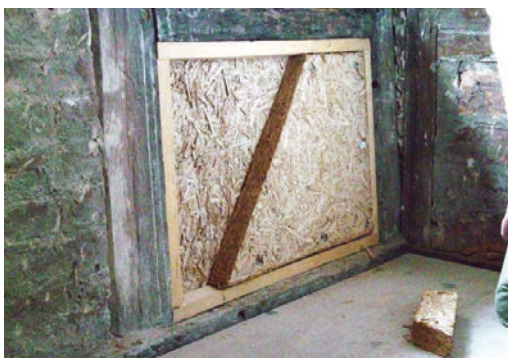
Einbau und Verschraubung der inneren Typha-Platte mit umlaufender Verleistung und Ausbildung einer Fuge zum Fachwerk, Foto Alexandra Fritsch
