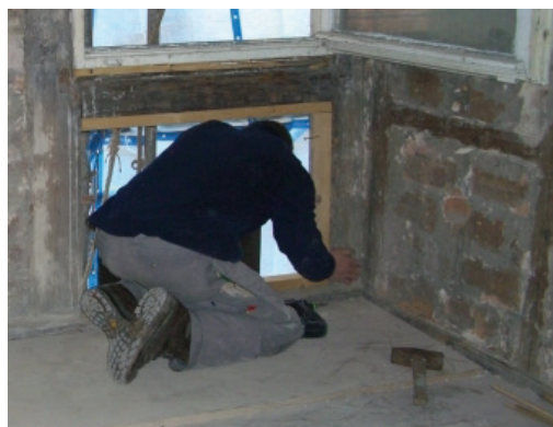
links: zimmermannsmäßige Sanierung des Fachwerks, Foto Architekturbüro Fritsch+Knodt&Klug
