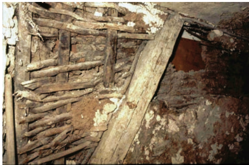
Bild links oben: originale Ausfachung mit Lehmflechtwerk, Foto Alexandra Fritsch
