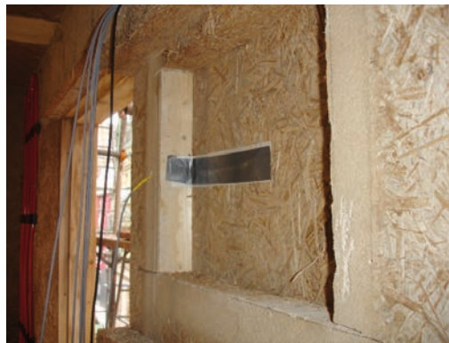
Bild 17: Temperaturfühler an der Grenzschicht 2, zwischen den beiden Dämmstoffplatten im Gefach, Foto IBP
