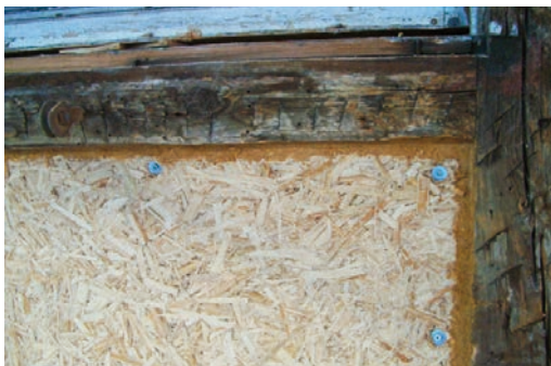
Einbau und Verschraubung der äußeren Typha-Platte mit Ausbildung einer Fuge zum Fachwerk, Foto Alexandra Fritsch
