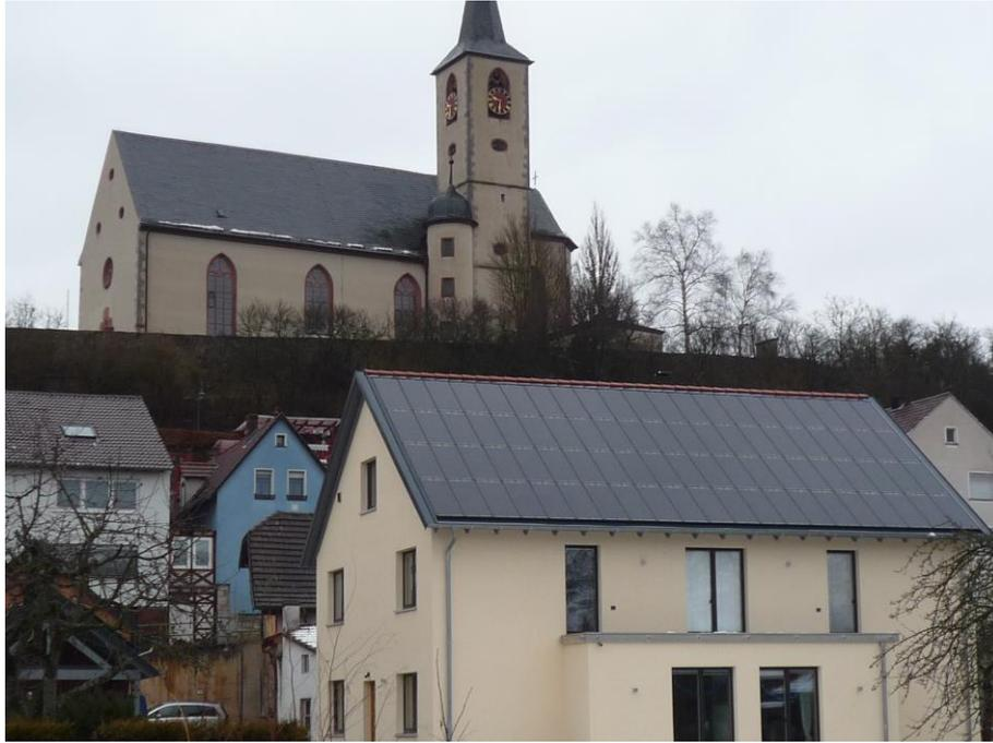
Bild 14.: Dachintegrierte PV-Anlage bei einem EFH in Eußenheim
