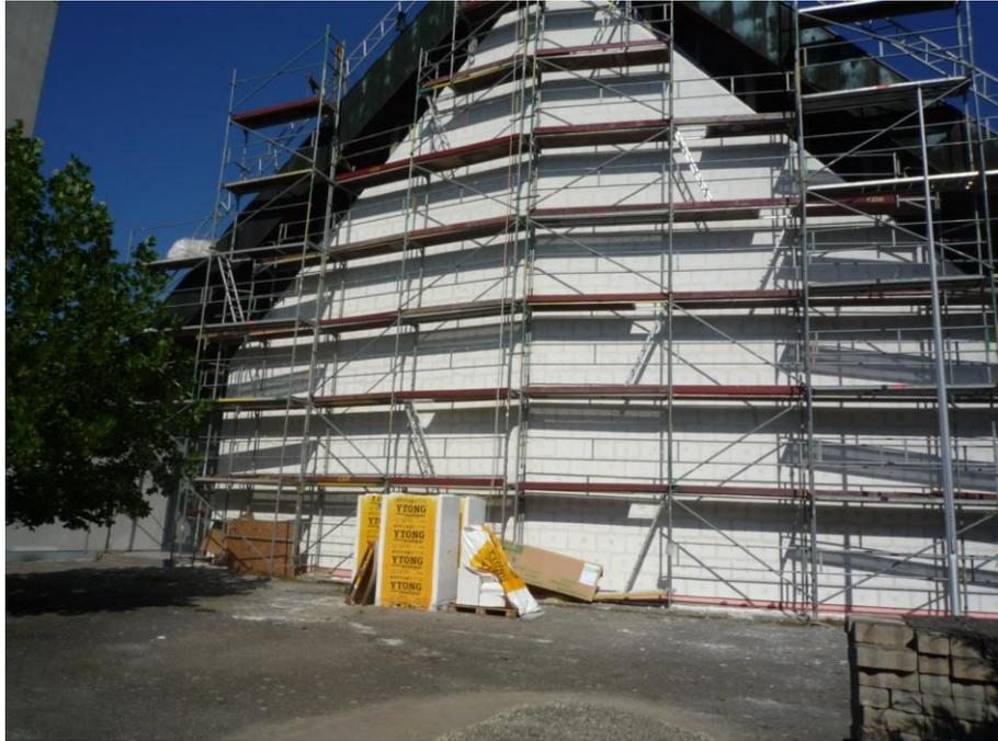
Bild 5: Außendämmung 20cm Mineralschaum, mineralisch verputzt
