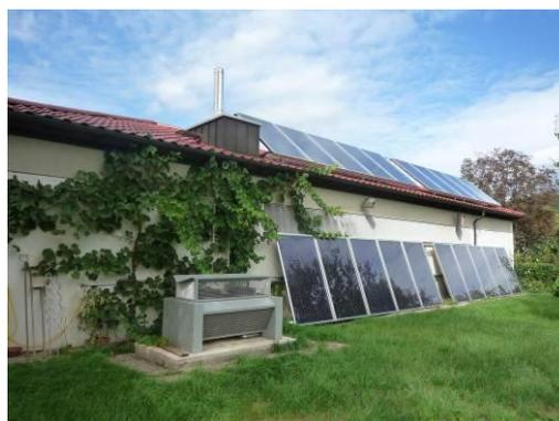
Bild 9: Hybrid - Kollektoranlage mit Luft-Wärme-Pumpe
