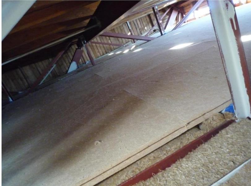
Bild 6: nachträgliche Dämmung der Dachkonstruktion auf der Rauminnenseite
