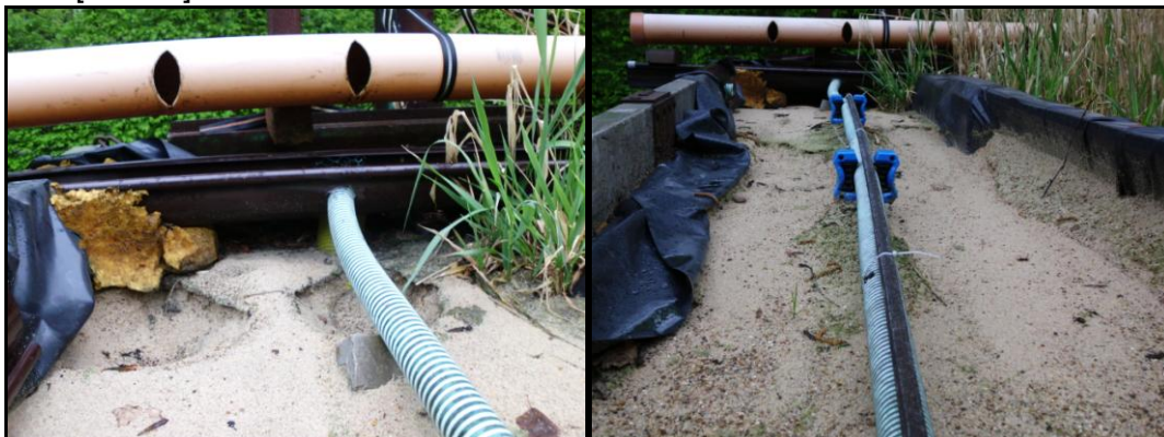
Abbildung 32: Erosionsschäden im sandigen Substrat des Filters „S“ nach Verstopfung des Schutzgitters.
