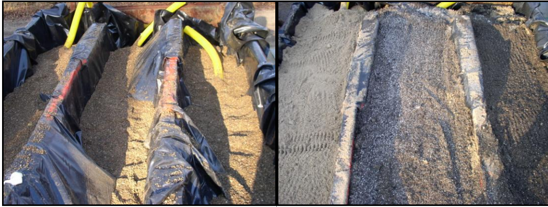
Abbildung 7: Einbau basale Kiesdrainage (2/8 mm) mit DN-80 Drainrohren (li.), fertiggestellte und nivellierte Filtersubstrate „S“, „1F“ und „2F“ (v.l.n.r.) vor Bepflanzung (27.01.2011) (re.).
