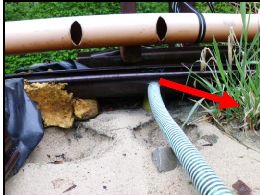
Abbildung 23: Starke Wassererosionsschäden im unbepflanzten Filter „S“ und einsetzende Einwanderung durch Phalaris rhizome (Pfeil re.).
