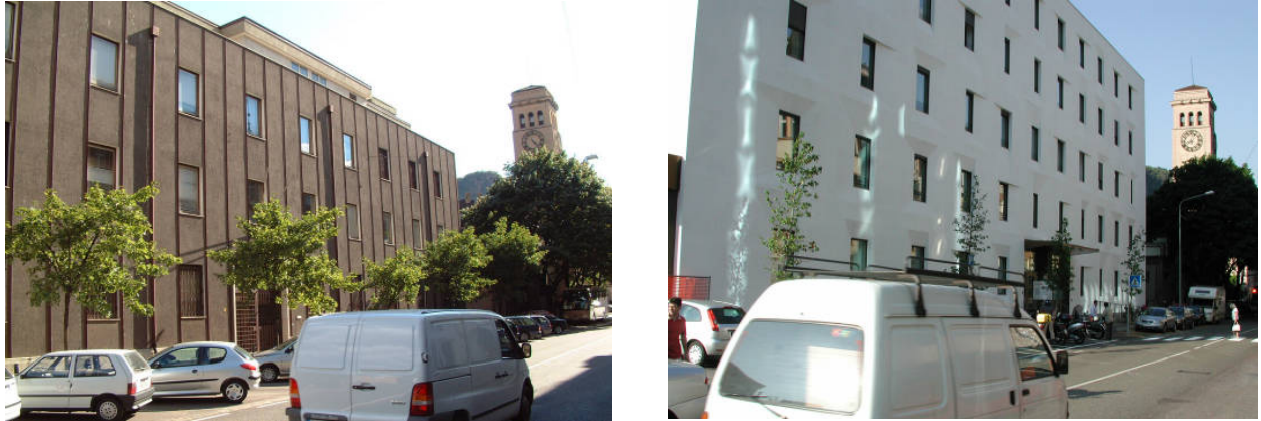
Abbildung 60: Expost Bozen -Straßenansicht vor und nach der Sanierung
