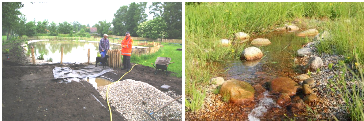
Abb. 34 + 35: Bauarbeiten und Fertigstellung des Grabens
