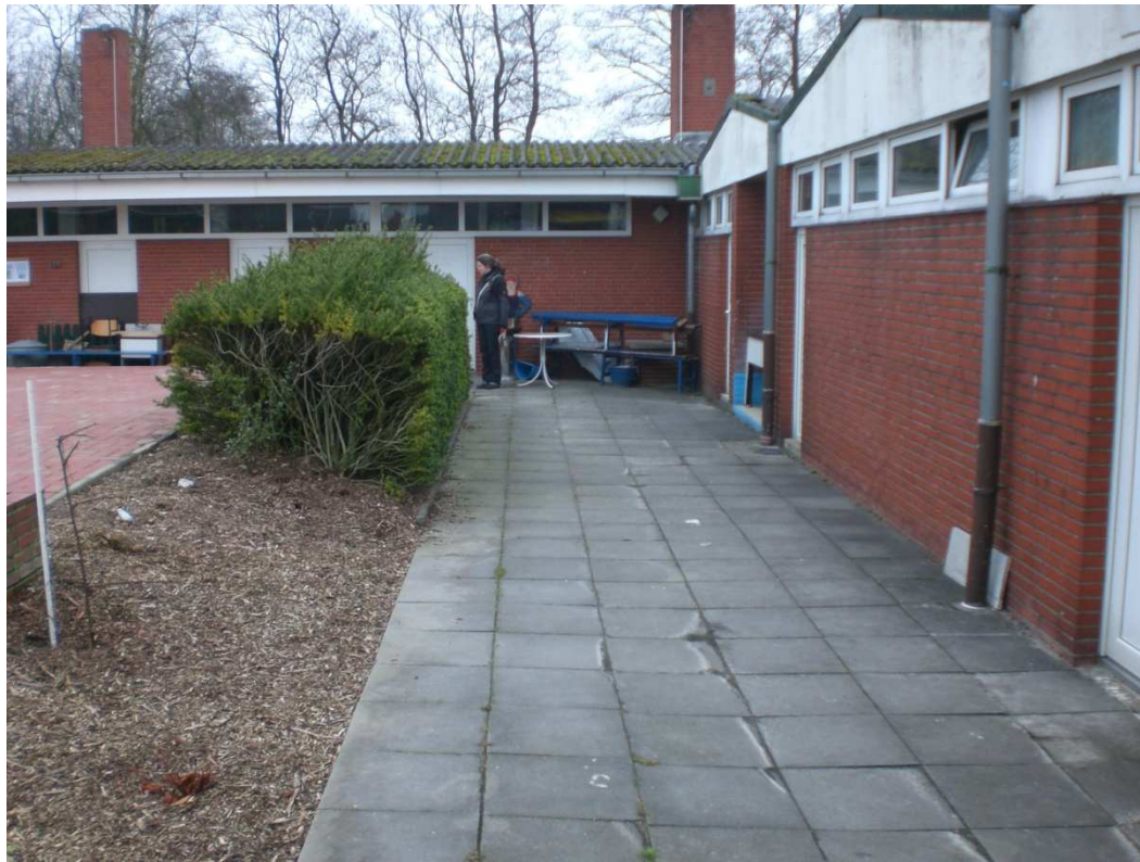
Abb. 7: Umkleide- und Duschräume des ehemaligen Freibades.
