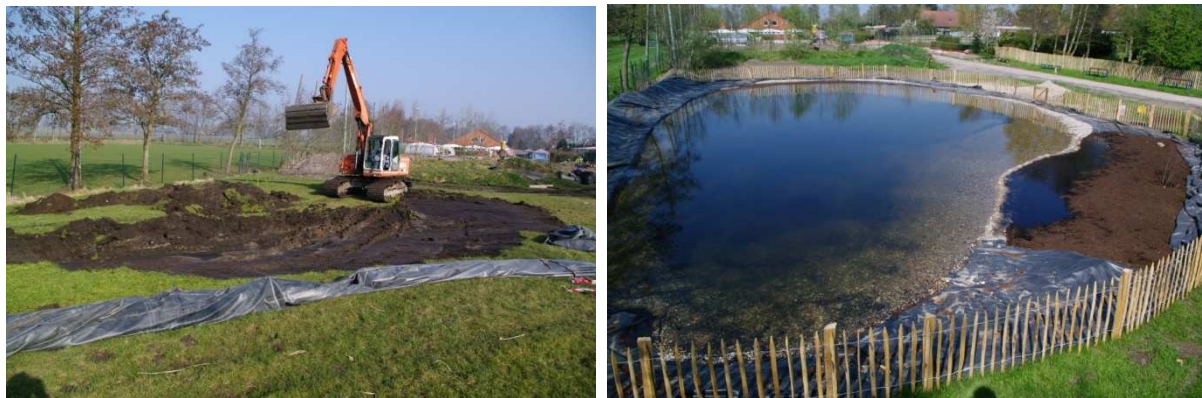
Abb. 32 + 33: Beginn der Baggerarbeiten und Fertigstellung des Teiches
