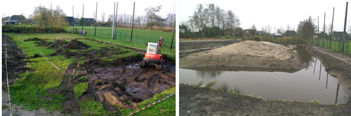
Abb. 30 + 31: Beginn der Baggerarbeiten und Fertigstellung
