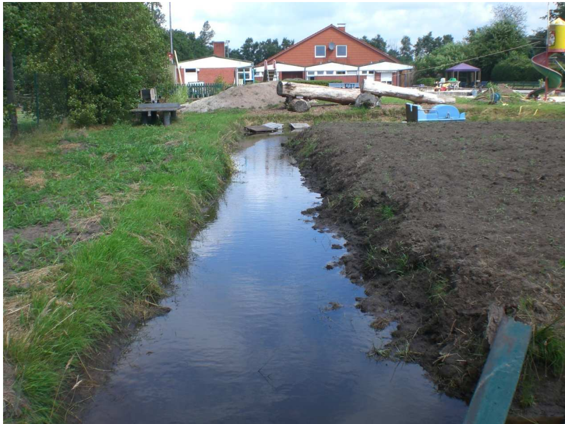
Abb. 11: Im nördlichen Gelände wurden bereits versuchsweise Gewässer ausgehoben, um die Höhe des Grundwassers zu ermitteln.
