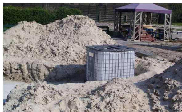
Abb. 28 + 29: Gründungsarbeiten und Wassertank der Wassermatschanlage
