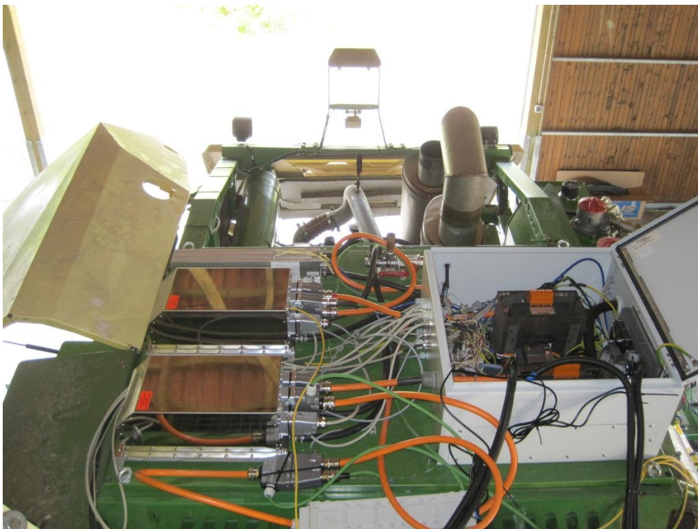
Anhang 4: Schaltschrank, Wechselrichter und Bremswiderstand während der Prüfstandsversuche (Foto: M. Heckmann)
