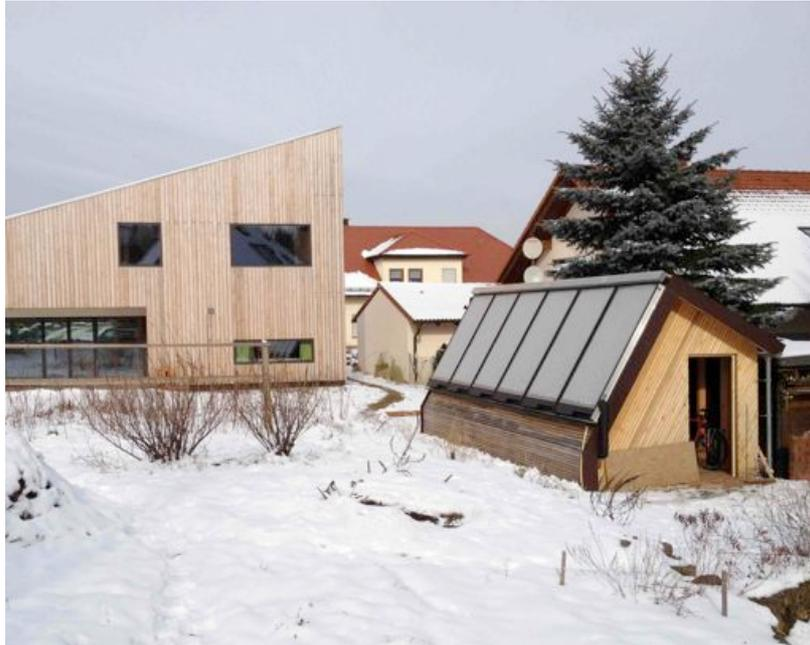
**Abbildung 13: Hybridkollektoren schneesicher auf Gartenhütte montiert**
