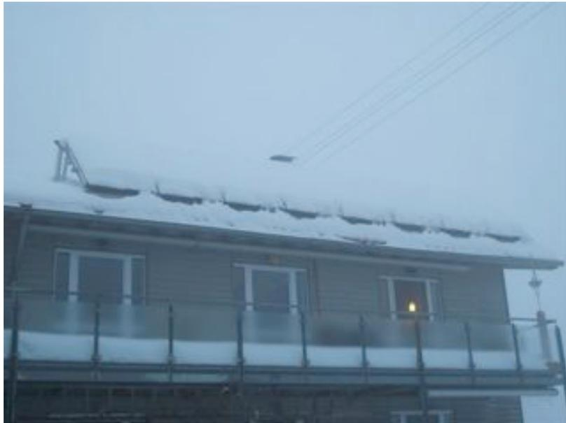
**Abbildung 7: Mit Schnee bedeckte Kollektoren. Der Luftaustritt ist frei**
