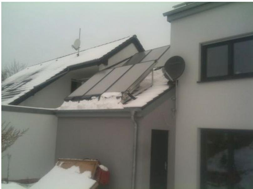
**Abbildung 10: Kollektoren am Nachmittag nach Auslösen der Abrutschfunktion**
