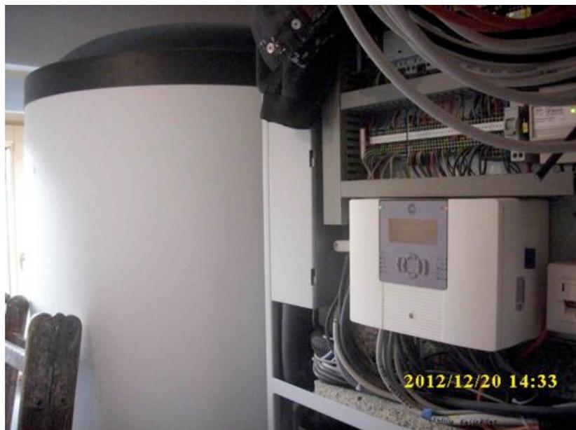
**Abbildung 24: SOLAERA mit neuem Regler CONTROL 702 SWP im Feldtest**
