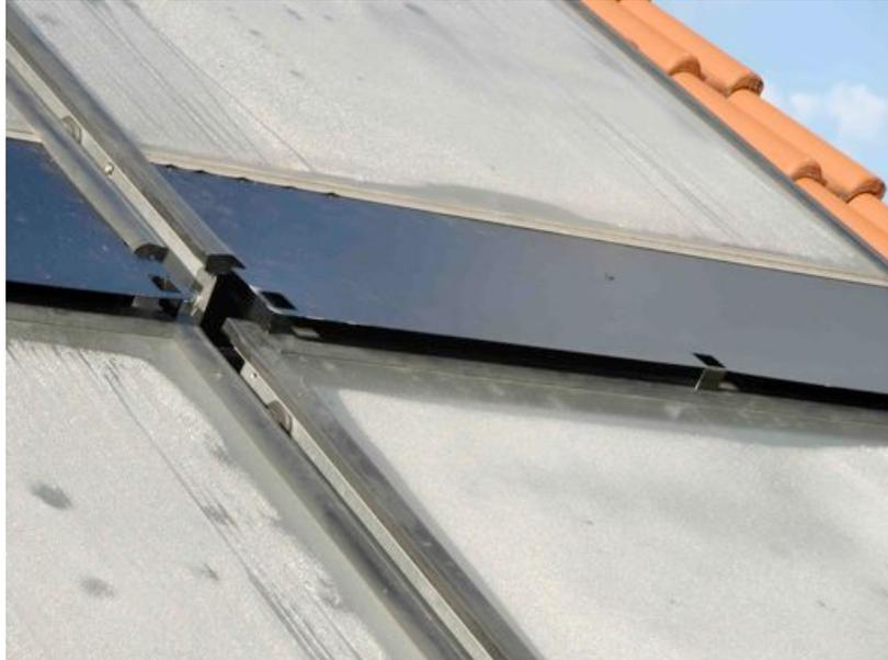
**Abbildung 11: Schneebleche zwischen oberer und unterer Kollektorreihe**
