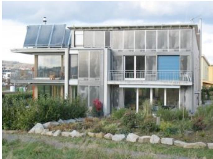
**Abbildung 16: Testanlage (linke Haushälfte) mit zwei verschieden ausgerichteten Kollektorfeldern: auf dem Dach mit 60° Neigung und an der Fassade**
