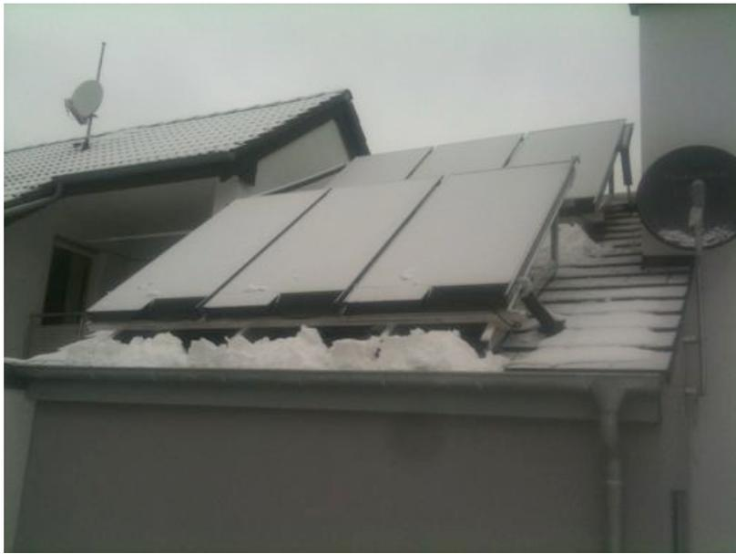
**Abbildung 9: Kollektoren am Vormittag vor Auslösen der Abrutschfunktion**
