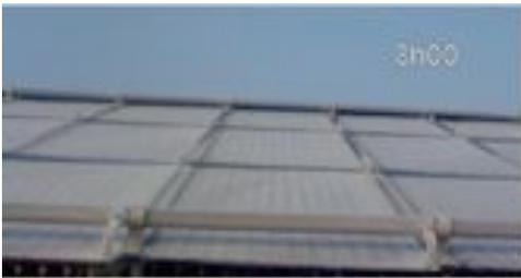
In dieser Kombination können nach den ersten Ergebnissen die Systemkosten um 10 – 20 % reduziert werden. Offen ist noch das Schneeverhalten: bei der Testanlage sind die Sammlerrohre so montiert, dass sie als Schneefänger wirken. Schnee wurde vom Hausherrn daher wenige Male von Hand entfernt. Bei steileren Winkeln und ohne Schneefänger könnte die entwickelte Antaufunktion auch hier wirksam eingesetzt werden.
