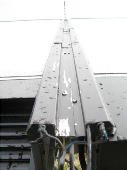
*Abbildung 4: Elektrische Schneeschmelzbleche, zwischen den Kollektoren zum Anschmelzen*
