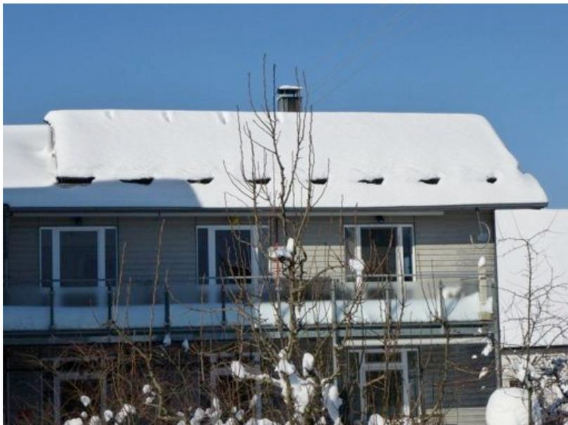
**Abbildung 8: Mit Schnee bedeckte Kollektoren. Der Luftaustritt ist behindert.**
