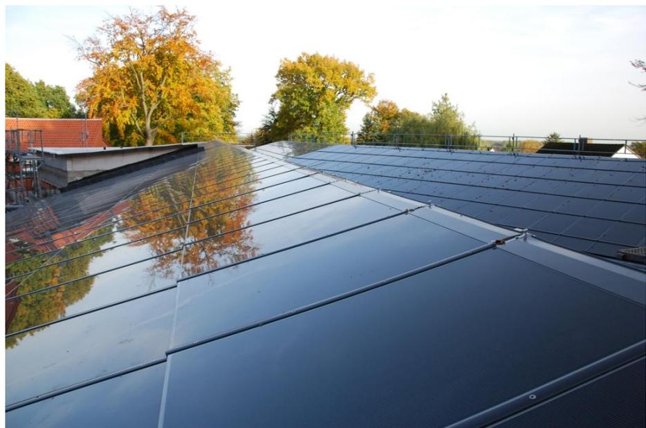
Abb.: realisierte InDach-Anlage
