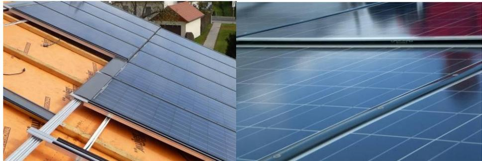
Die rahmenlosen Module sind frei von störenden Schmutzkanten und bleiben dadurch nachweislich sauberer und leistungsfähiger. Das Indachsystem besitzt eine hagelschlagsichere und nahezu verwitterungsfreie Glasoberfläche. Die Lebensdauer von Glas und der Alu-Edelstahl-Halterung ist fast unbegrenzt. Dieses Photovoltaiksystem trägt somit zum dauerhaften Erhalt der Bausubstanz bei.
