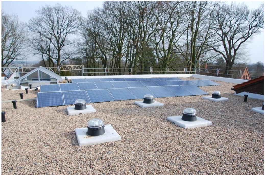
Abb.: Kuppeln der Lichtkamine auf dem Flachdach des Bestandsgebäudes
