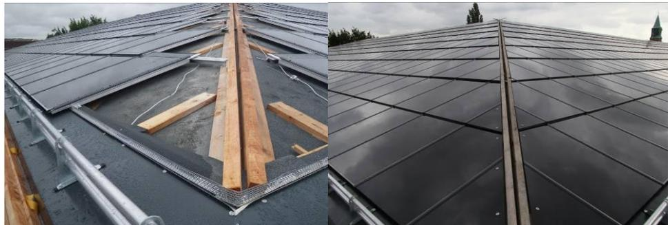
Die Dichtigkeit der Dacheindeckung basiert auf dem altbewährten Überschuppungsprinzip. Der waagrecht verlaufende Modulüberstand ist mit einem 8–15mm hohen Spalt und einem Verlängerungsblech versehen. Dadurch bleibt der Modulscheibenübergang regendicht, und Stauwärme kann reduziert werden, weil das PV-Modul durch die Spaltöffnungen direkt entlüftet und gekühlt wird.
