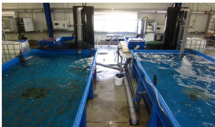
Abb. 22: Blick auf zwei technisch identischen Fluid-Kreisläufe in der Forschungshalle Völklingen (HTW). Links: Fluid-Kreislauf vom Landmark-Projekt. Rechts: Fluid-Kreislauf der Halophyten-Anlage. Während der Automatisierungsphase war zunächst immer nur ein Fluid-Kreislauf besetzt, während der unbesetzte Fluid-Kreislauf für die Funktionsprüfungen und Stresstests verwendet wurde.
