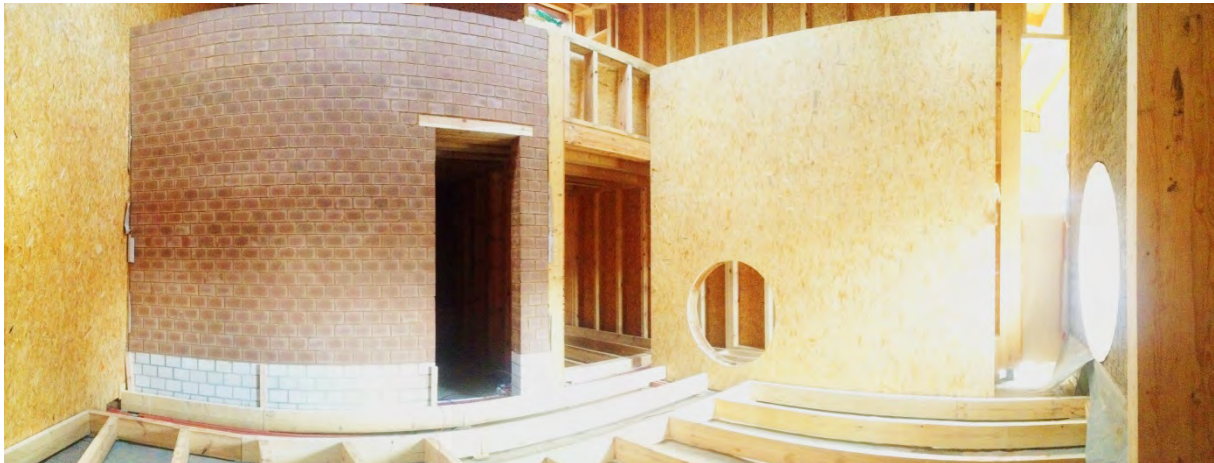
Abb.19 Gruppenraum in der Bauphase – schwere Innenlehmwände und Holzkonstruktion des Bodens
