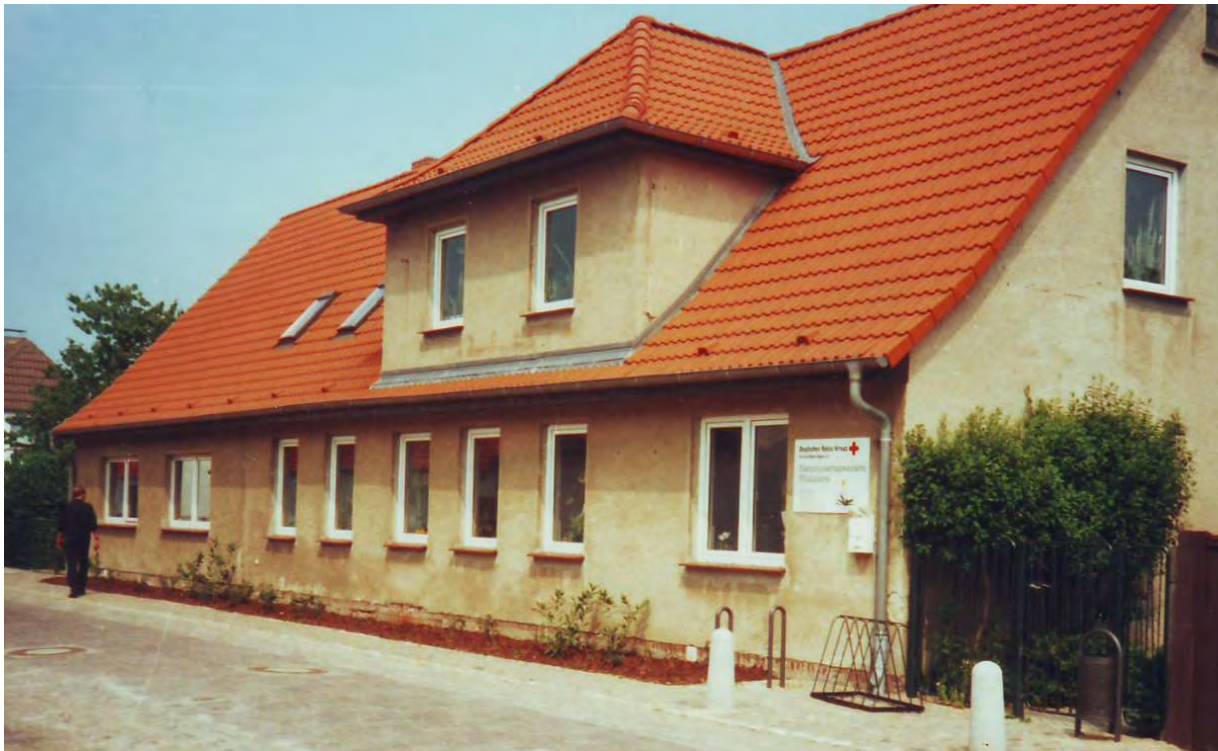
Abb.2 Südwestansicht des Bestandsgebäudes
