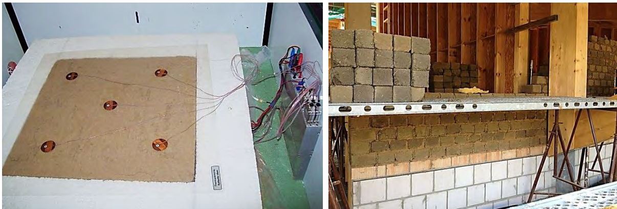
Abb.20 Die Leichtlehmwand wurde im Vorfeld detailliert untersucht, Abb.21 Bau der Außenlehmwand
