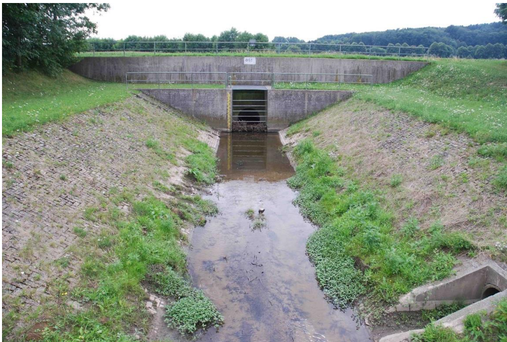
Abb. 108: Lecker Mühlbach: Düker am Mittellandkanal.
