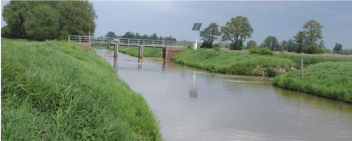
Abb. 362: Grawiede-Stauwehr mit Fischpass.
