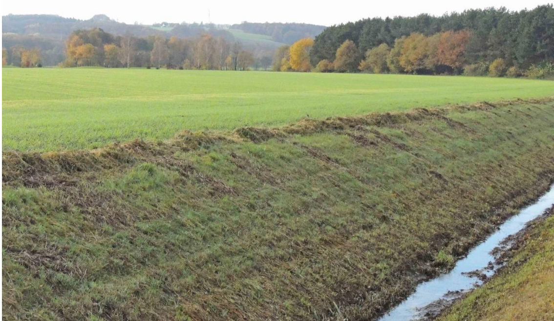
Abb. 116: Venner Bruchkanal am Lutterdamm. Tief eingeschnittener Entwässerungskanal ohne Gewässerrandstreifen. Im Hintergrund das Wiehengebirge.
