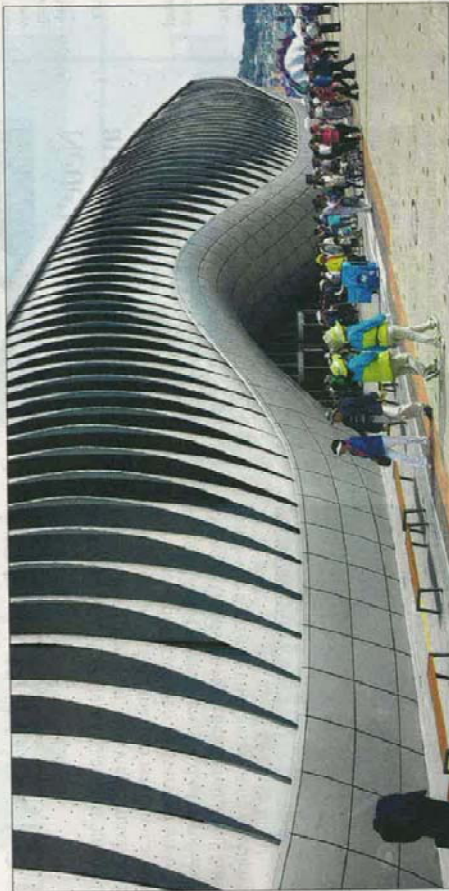
Die diesjährigen Gewinner des International Bionic-Awards, inspirierten bereits die Ingenieure des Themenpavillons der Expo 2012 in Südkorea mit ihrer Idee einer durch Strukturversagen verformbaren Fassadenbeschattung. Foto: Riccardo La Magra/VEB
