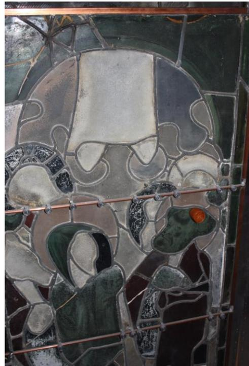
Abb. 310, 311: Staubprobenahme auf der Rückseite der Felder nIV 1c und nIV 4c von der Oberfläche unverwitterter Gläser
