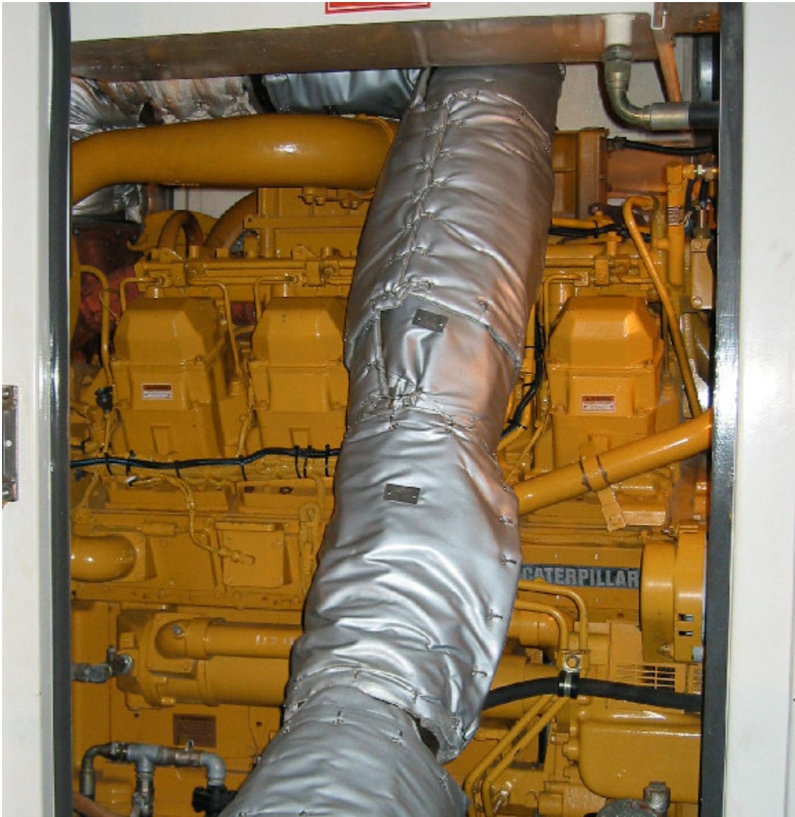
Abbildung 15: Abstand vom Abgasaustritt bis zur Abgasanlage, l_a
