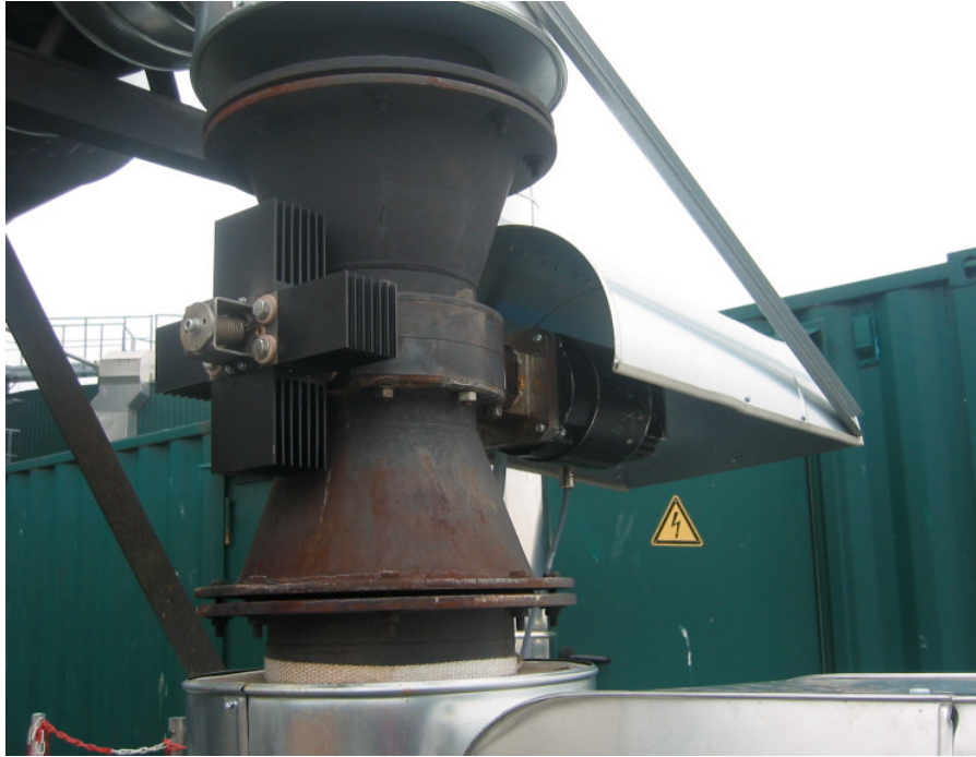
Abbildung 48: Foto der aktiven Abgasklappe im eingebauten Zustand
