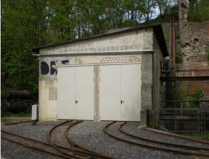
Ehemaliges Pumpenhaus der Steinindustrie, zum Lokschuppen umgebaut
