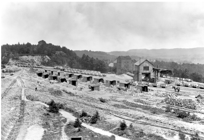
Steinbruch Piesberg mit Feldbahnen und Bremsberge. Im Hintergrund das Haseschachtgebäude (heute Museum Industriekultur Osnabrück)
