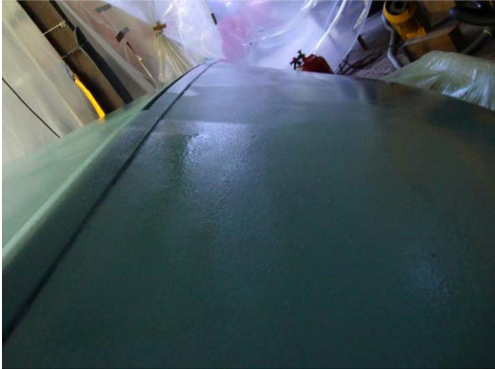
Abb. 8: Oberflächenfinish mit temperaturbedingt variierendem Glanz
