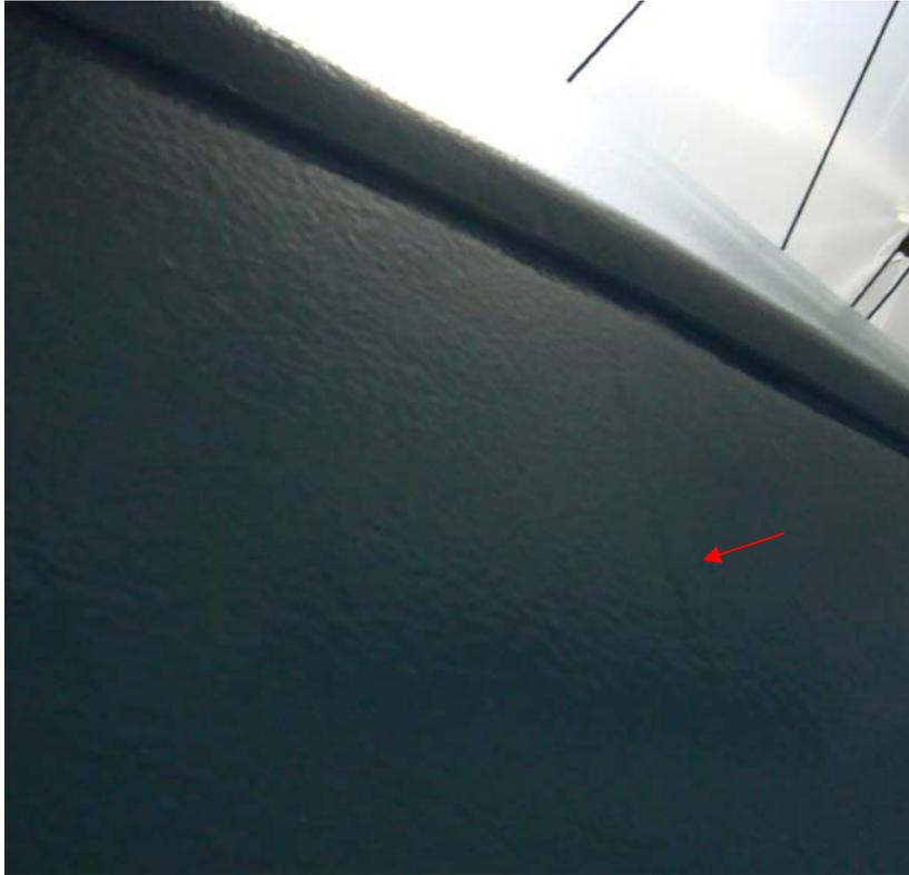
Abb. 15: Gut eingebnete „Naht“ (siehe Pfeil) der ausgebesserten Reparaturfläche
