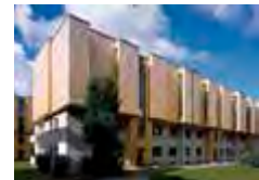
Aufstockung Siedlung Hamburg_2.jpg
