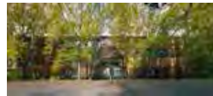
Fassadensanierung Bibliothek Berlin_1.jpg
