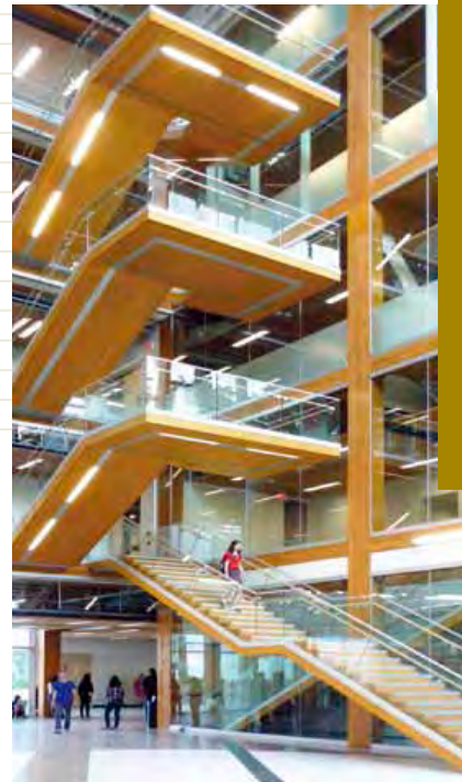
Freitragende und auskragende Treppe an der Universität in Vancouver (CA). Die biegesteifen Anschlüsse der Treppen- läufe an die Geschossebenen und die Podeste bestehen aus Holz-Lochblech-Verklebungen.
