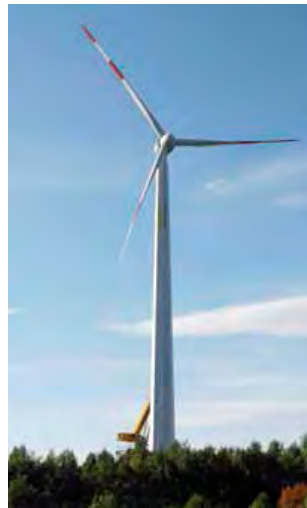
TimberTower in Hannover: Alle eingesetzten Holzelemente sind in den Horizontalstößen über eingeklebte Lochbleche miteinander verbunden.
