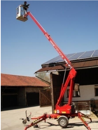
Abbildung 9: Durchführung einer IR-Übersichtsaufnahme einer PV-Dachanlage von einer mobilen Hebebühne
