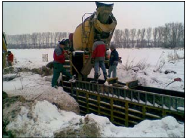
Abb. 4: Der Sockel für einen variablen Schiebern wird aus Beton geschüttet.
