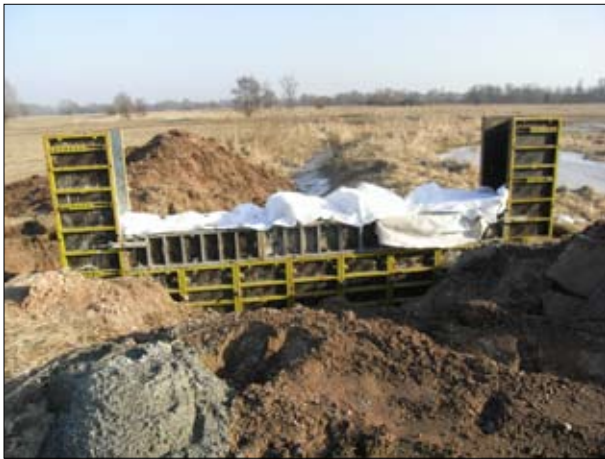
Abb. 3: Verschalung für einen variablen Stau.
