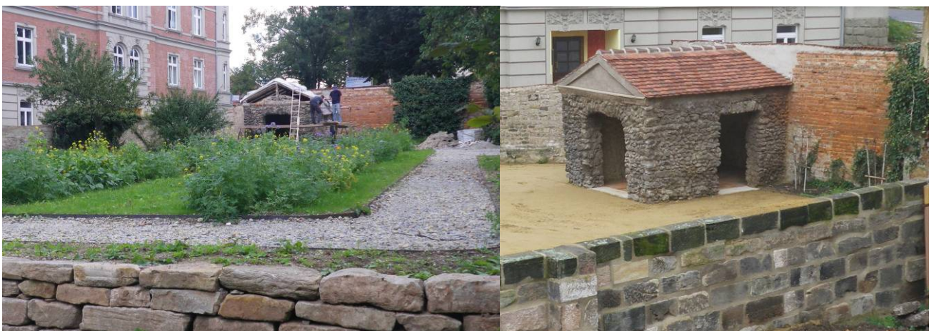
Nach baudenkmalpflegerischem Gutachten 2010 wiederhergestellte Tuffsteingrotte im Küchengarten Kurie ‚Levini‘
