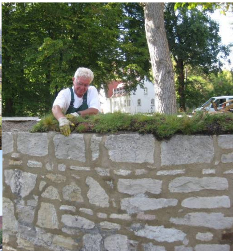
2010 Aufbringung der Mauerkronenbegrünung (Foto rechts oben) und Fertigstellungspflege Foto links oben)
