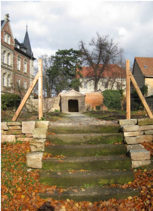
Neue Treppe im Übergang vom Wandelgarten zum Küchengarten und in Bauflucht der Grotte, November 2010
