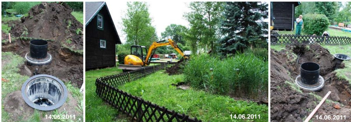
**Abbildung 4.3: Umbaumaßnahmen im Sommer 2011 zur Implementierung der autotrophen Stickstoffelimination**
