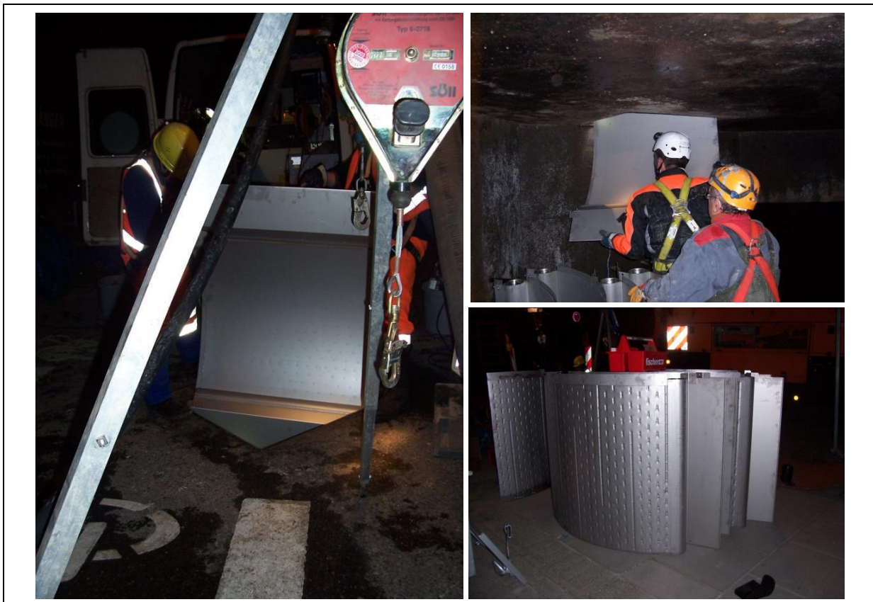
Abbildung 15: Einbringung der Wärmetauscher-Elemente in den Abwasserkanal
