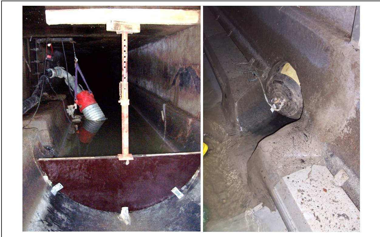
Abbildung 16: Wasserhaltung und Umfahrung seitlicher Einlauf im Bereich Wärmetauscher
