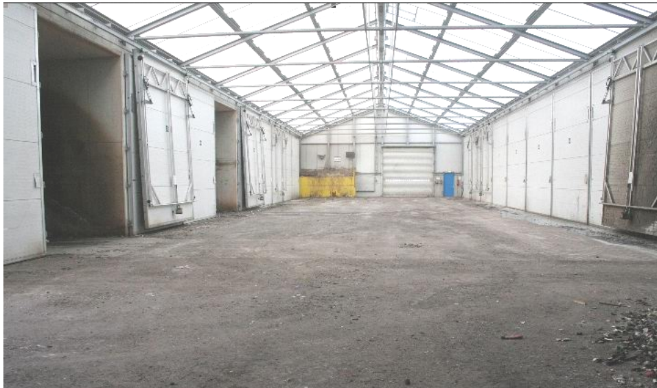
Abbildung 8: Rottetunnel mit Fahrgasse in der MBA Havelland
