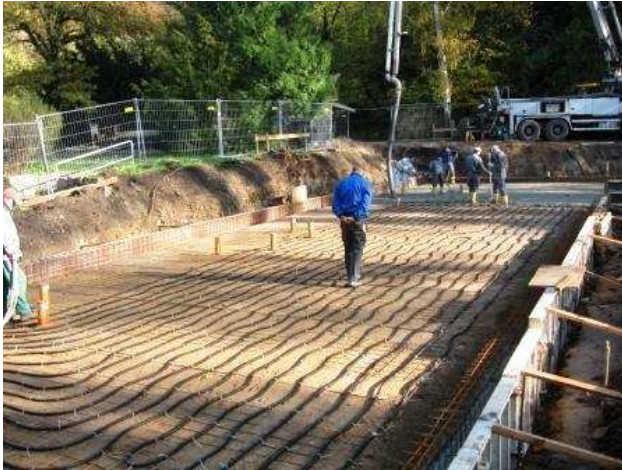
Abb. 2.1: Fundamentspeicher
