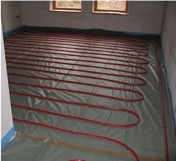
Abb. 2.6: Rohrleitungen Fußbodentemperierung
