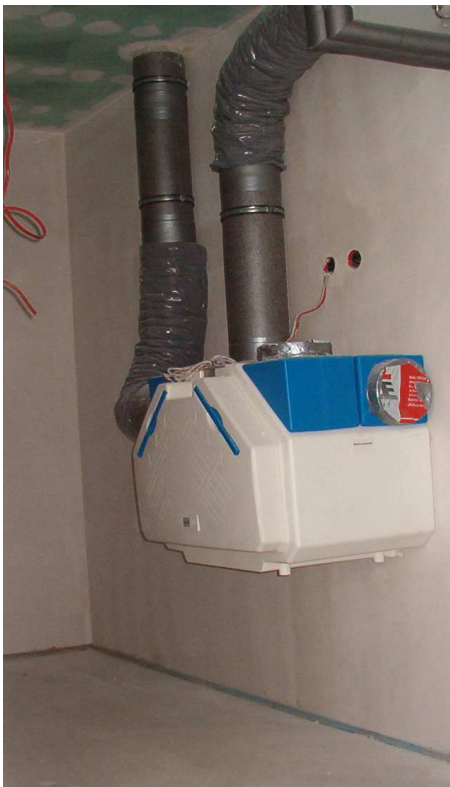
Abb. 2.7: Lüftungsaggregat WRA 400
