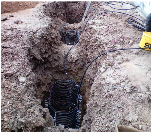
Abb. 2.2: Erdwärmekörbe
