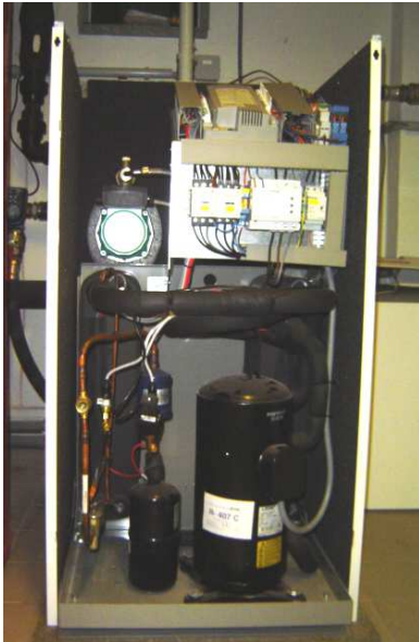
Abb. 2.3: Wärmepumpe (Innenansicht)
