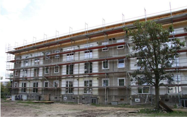
**Abb. 144:** Anbringen der Wärmedämmung – Vorbereitung (li.), Giebel mit Wärmedämmung (re.) (08/2011)
