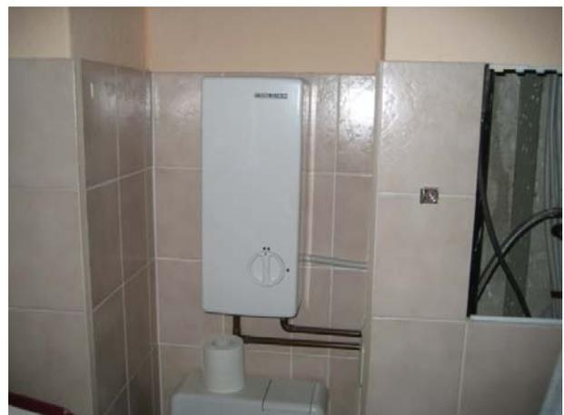
**Abb. 30:** Verteilung der Heizleitungen im Kellergeschoss (li.), Elektrischer Durchlauferhitzer Bad (re.)
