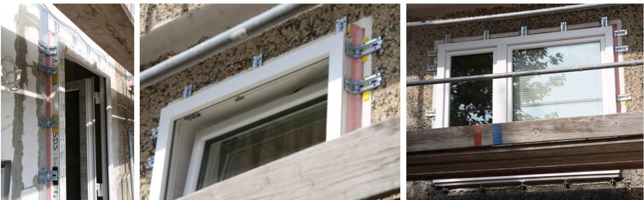
**Abb. 143:** Eingebaute Fenster und Hauseingangstüren gemäß Passivhaus-Standard (3-fach Verglasung)
