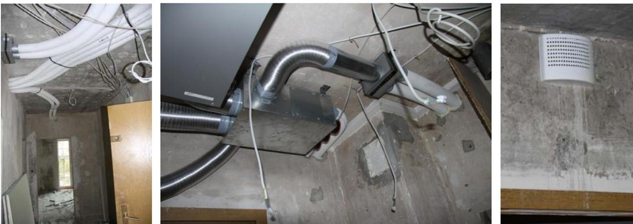
**Abb. 146:** Anlagentechnik Lüftungsanlage – Wohnungsflur (li.), Bad (Mi.), Abluftfilter Wohnraum (re.)
