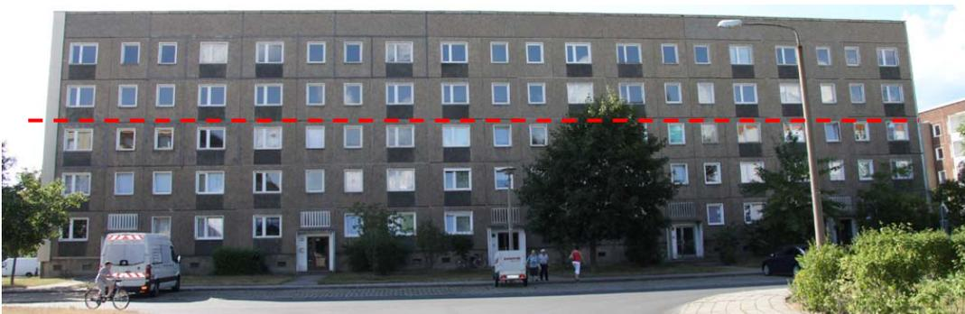
**Abb. 134:** Gebäudebestand Heinrich-Hertz-Straße 26 – 30 (2010) / rote Linie Teilrückbau 3. und 4. OG
