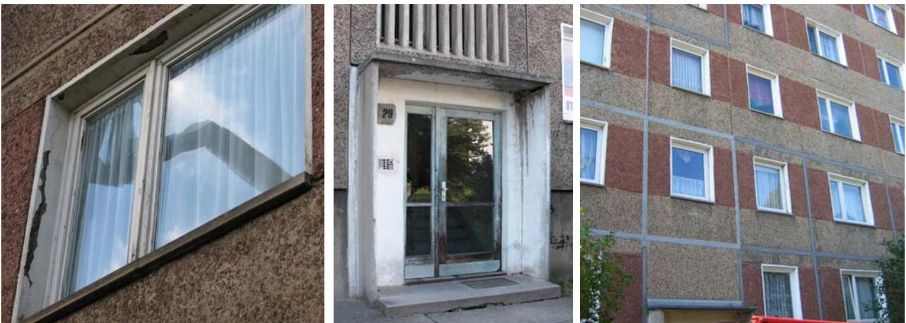
**Abb. 28:** Sichtbare Mängel an Fensterlaibungen und Fenstern (li.) sowie im Eingangsbereich (mi.), Abgedichtete Außenwandfugen (re.)
