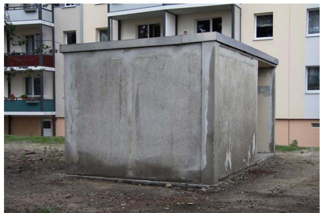
**Abb. 154:** Rohbau „Fahrradgaragen“ aus rückgebauten Betonelementen - Parkplatzanlage im Innenhof (06/2012)
