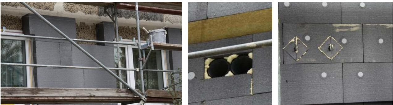
**Abb. 145:** Anbringen der Wärmedämmung (Polystyrol-Hartschaumplatte, 26 cm) - Verkleben und Verdübeln (09/2011)
