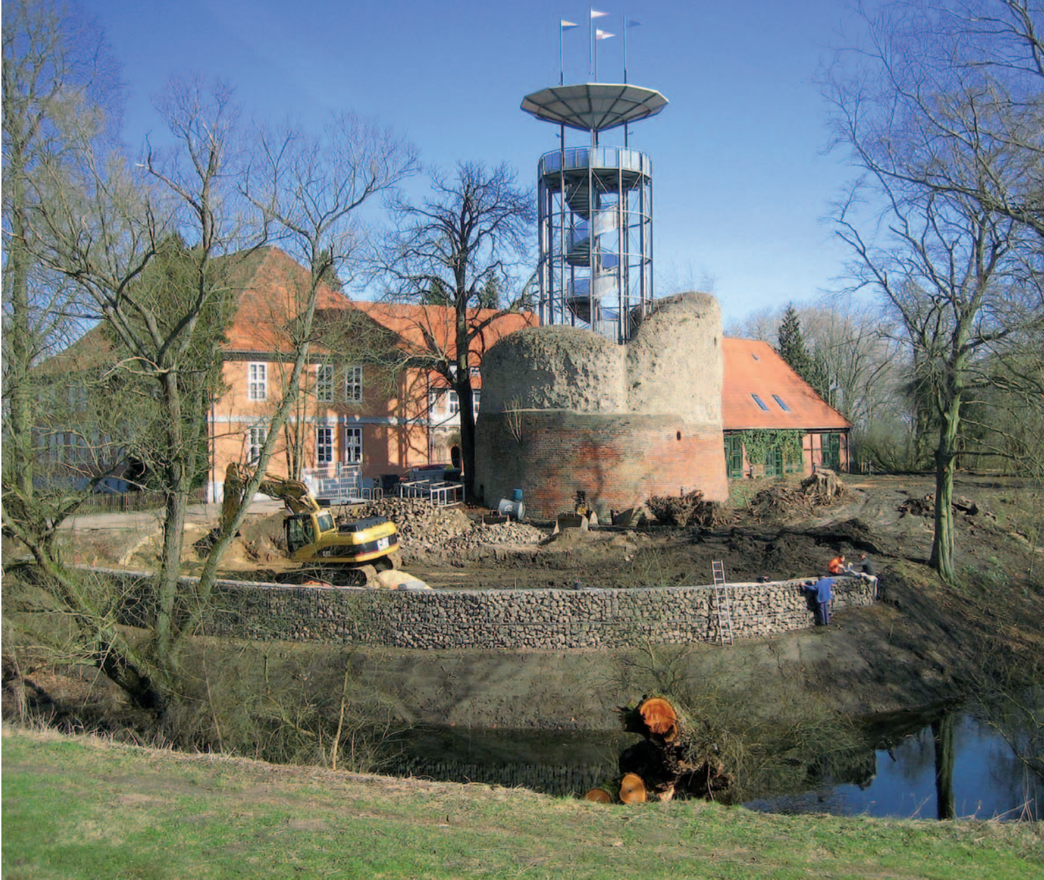
Blick vom alten Deich auf die Baustelle
