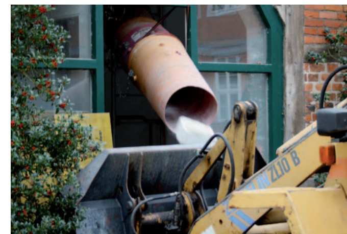
Remise wird entkernt
