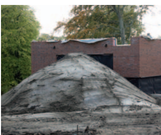
Anschüttung an der Ostseite des Biberbaus
