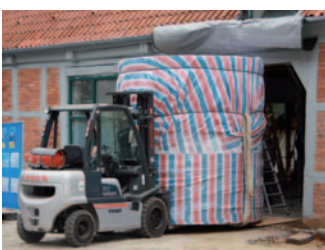
Anlieferung des Rundbeckens
