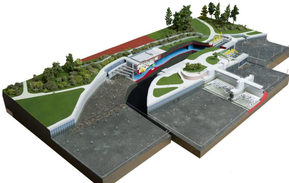
Durch Betätigen von verschiedenen Tasten am Modell können die einzelnen Funktionen und Bestandteile des Kraftwerks sichtbar gemacht werden: Fischwanderung flussaufwärts, Fischwanderung flussabwärts, Fließweg des Wassers, auf/zu, Generator und Turbine, Krafthaus, Triebwasserkanal, Einlaufbauwerk, Stauwehr
