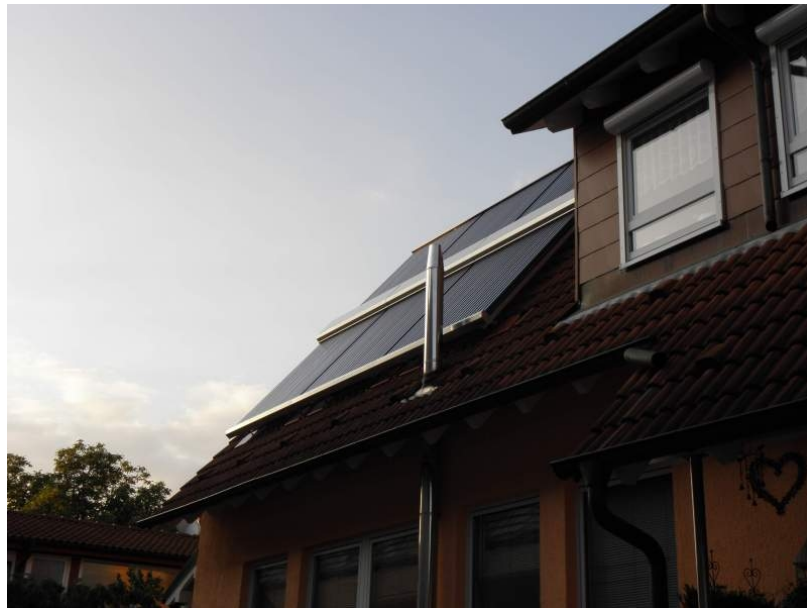
Abbildung 4: Kollektorfeld der Anlage Spoeck0001
